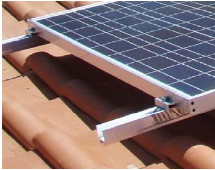
Εικόνα 38: Φωτοβολταϊκό πλαίσιο σε ειδική βάση προσαρμοζόμενη στο εξωτερικό του κελύφους
