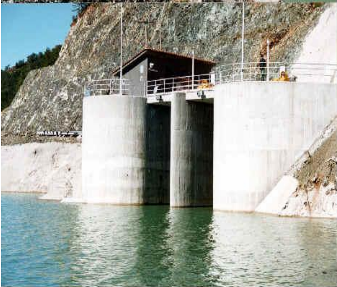
(Εκχειλιστής φράγματος Αώου)
