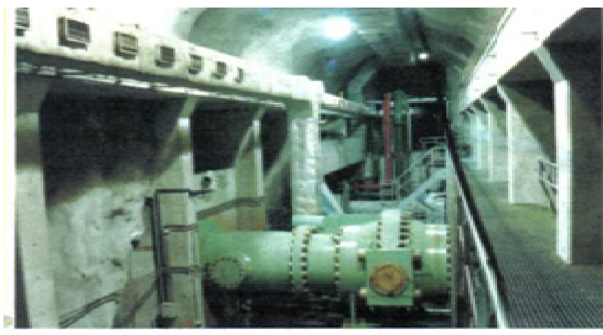
( Θάλαμος σφαιρικών βαλβίδων- σφαιρικές βαλβίδες )
