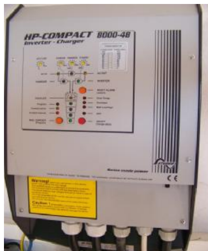
Σχήμα 6.11: Λεπτομέρεια του αντιστροφέα
