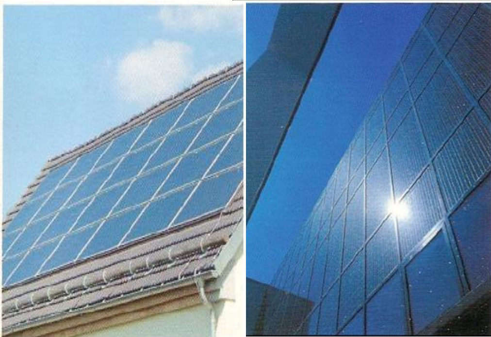
1.8. Εφαρμογές φωτοβολταϊκών για την παραγωγή ηλεκτρικής ενέργειας σε κτίρια
