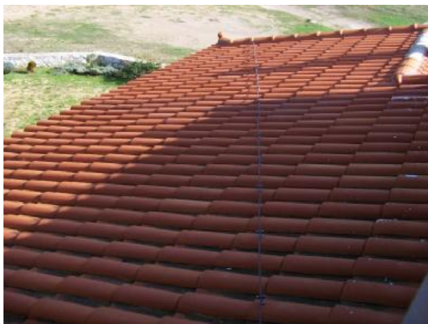
Σχήμα 6.7: Λεπτομέρεια του αγωγού καθόδου του αλεξικέραυνου. Διακρίνονται τα πολλά σημεία στήριξης για να αντέχει στις μηχανικές καταπονήσεις που προκαλούν τα κρουστικά ρεύματα κεραυνών.
