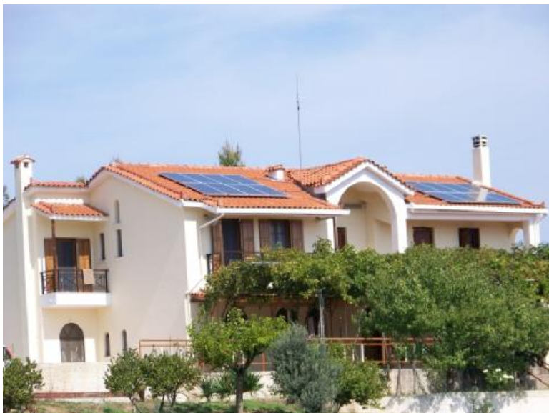
Σχήμα 6.2: Γενική άποψη του κτιρίου από τη νότια πλευρά. Διακρίνονται οι δύο συστοιχίες που αποτελούνται από 8 φωτοβολταϊκά στοιχεία έκαστη.
