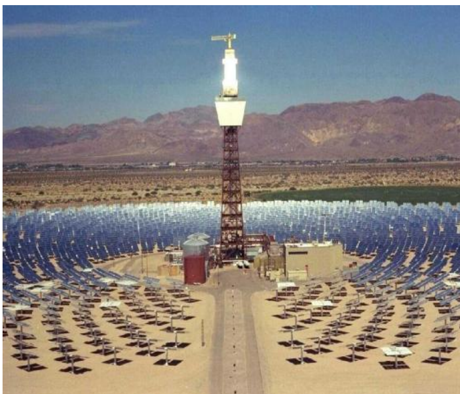
Σχήμα 1.2 Σταθμός παραγωγής ενέργειας 10 MW
