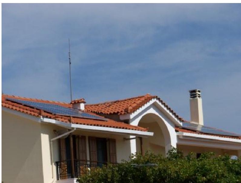
Σχήμα 6.3: Γενική άποψη του κτιρίου. Διακρίνονται τα φωτοβολταϊκά καθώς και το αλεξικέραυνο που προστατεύει όλη την κατασκευή.
