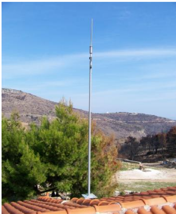
Σχήμα 6.6: το αλεξικέραυνο που προστατεύει τη διάταξη.
