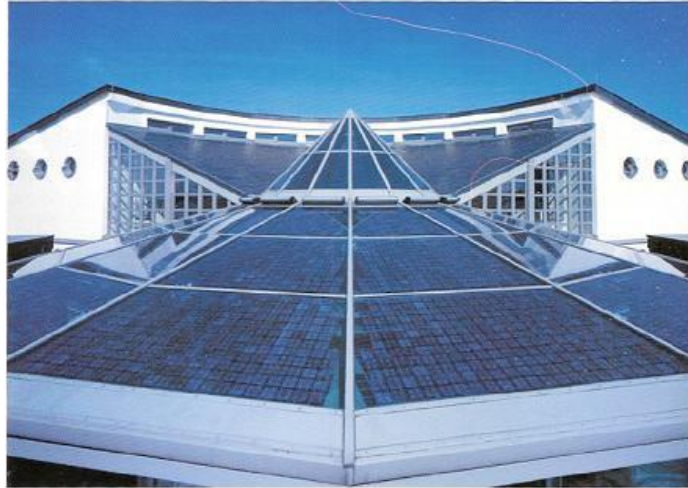
1.7. Εφαρμογές φωτοβολταϊκών για την παραγωγή ηλεκτρικής ενέργειας σε κτίρια
