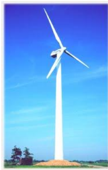
Σχήμα 2.2 Ανεμογεννήτρια οριζόντιου άξονα με τρία πτερύγια.
