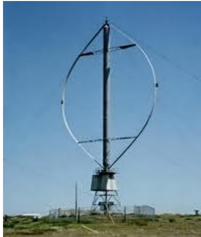
Σχήμα 2.1 Ανεμογεννήτρια κατακόρυφου άξονα τύπου Darrieus.
