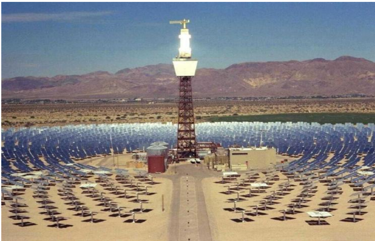
Σχήμα 2.11 Σταθμός παραγωγής ενέργειας 10 MW
