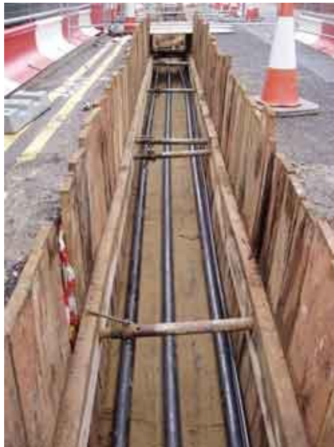
Υπογειωση εναέριων αγωγών και καλωδίων
