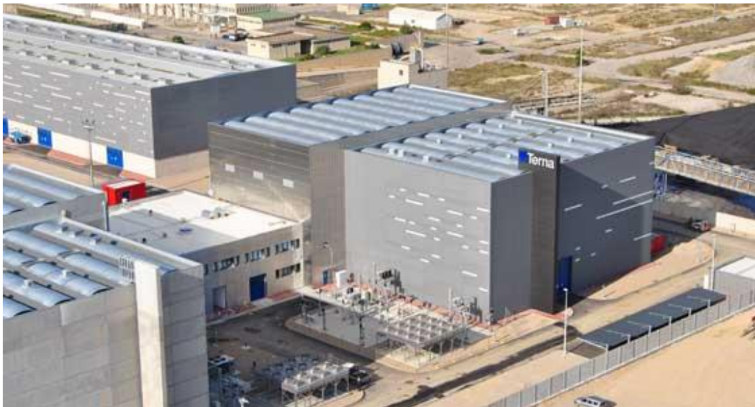
Σταθμός ηλεκτρικού ρεύματος στο Fiume Santo
