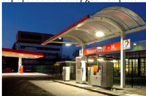
Σταθμός Ανεφοδιασμού υδρογόνου στο Spandau του Βερολίνου στη Γερμανία [31]
