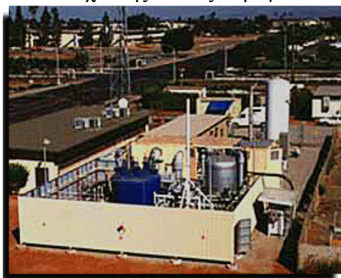
Μονάδα κυψελών καυσίμου MCFC, αποτελούμενη από 16 συστοιχίες, συνολικής ισχύος 2 MW, στην Santa Clara της Καλιφόρνια.
