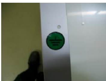
ΕΙΚΟΝΑ 6.29 ΤΟΠΟΘΕΤΗΣΗ ΣΗΜΑΝΣΗΣ ΓΕΙΩΣΗΣ
