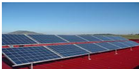
Διασυνδεδεμένο σύστημα σε μεταλλική οροφή της εταιρίας STANDOR Ltd. Αυλίδα Εύβοιας, Ιανουάριος 2008
