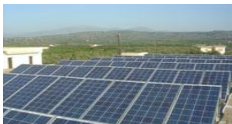
Διασυνδεδεμένο σύστημα 18 kWp της εταιρίας STYLCA. Αργολίδα, Οκτ. 2007
