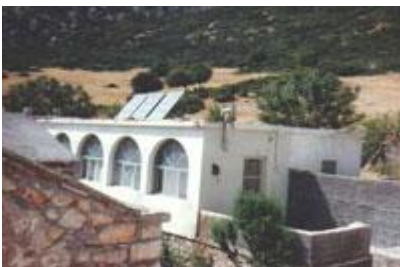
Υβριδικό φωτοβολταϊκό σύστημα σε συνδυασμό με το κεντρικό δίκτυο σε Ιερά Μονή της Καλύμνου.
