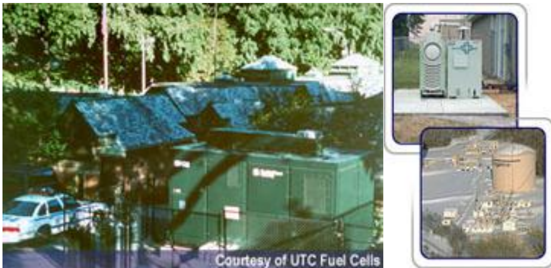
Εικόνα 4.3 (Αριστερά): Κυψέλες καυσίμου εγκατεστημένες σε ένα αστρονομικό τμήμα στο Central Park της Νέας Υόρκης. (Courtesy of UTC Fuel Cells)
