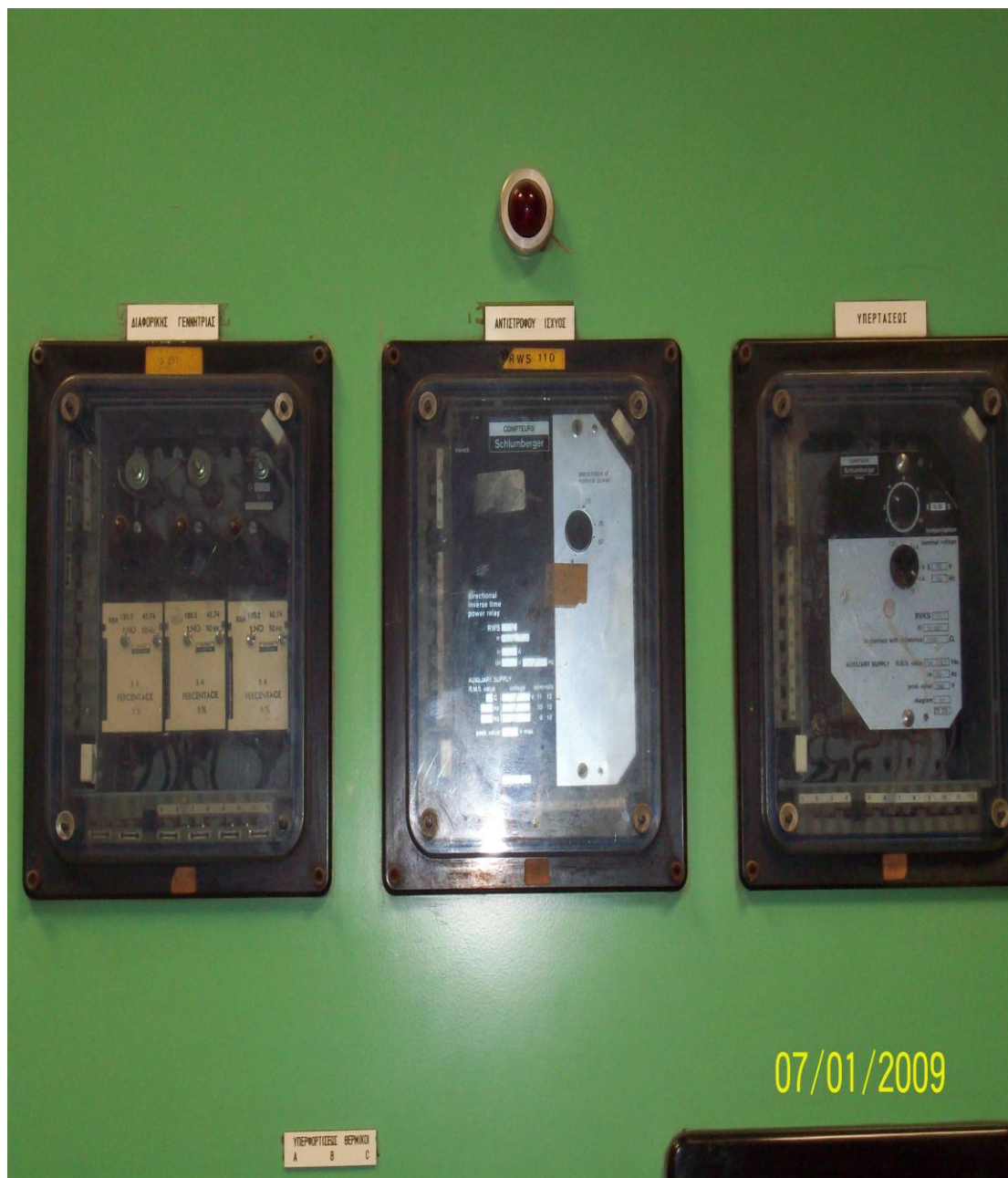
(Ηλεκτρονόμος υπέρτασης γεννήτριας)
