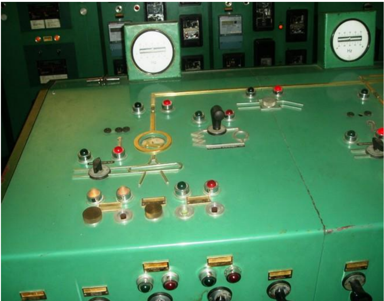
(Πάνελ συγχρονισμού πρώτης γεννήτριας)
