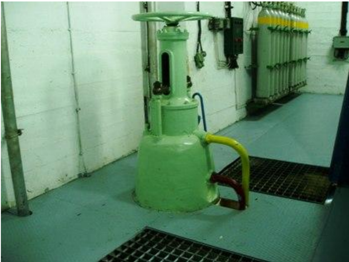
(Χειροκίνητη λειτουργία ανακουφιστικής βαλβίδας)
