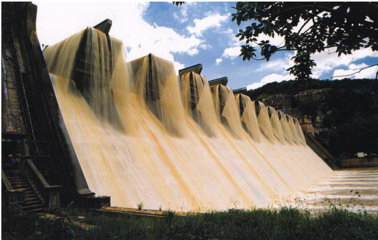
(Φράγμα με ανατρεπόμενα θυροφράγματα τύπου fusegate)
