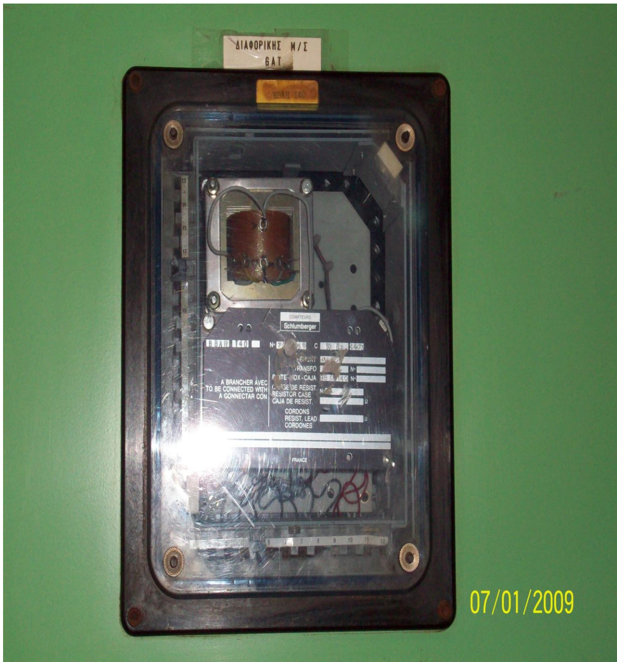
(Ηλεκτρονόμος διαφορικής γεννήτριας)
