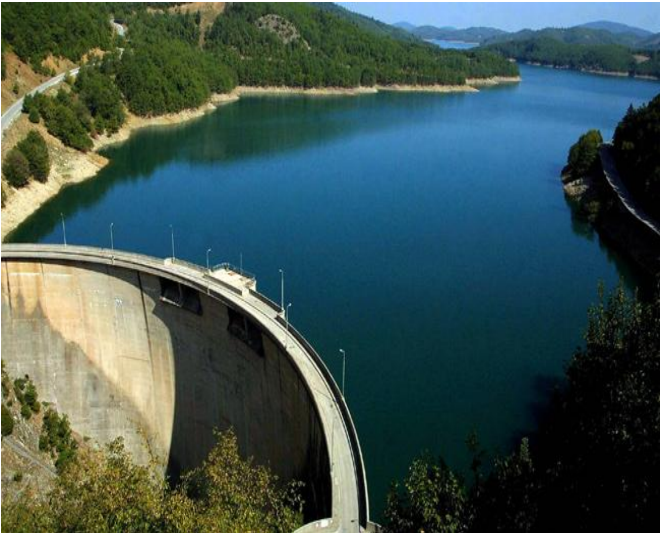
(Τοξωτό φράγμα λίμνης Πλαστήρα)
