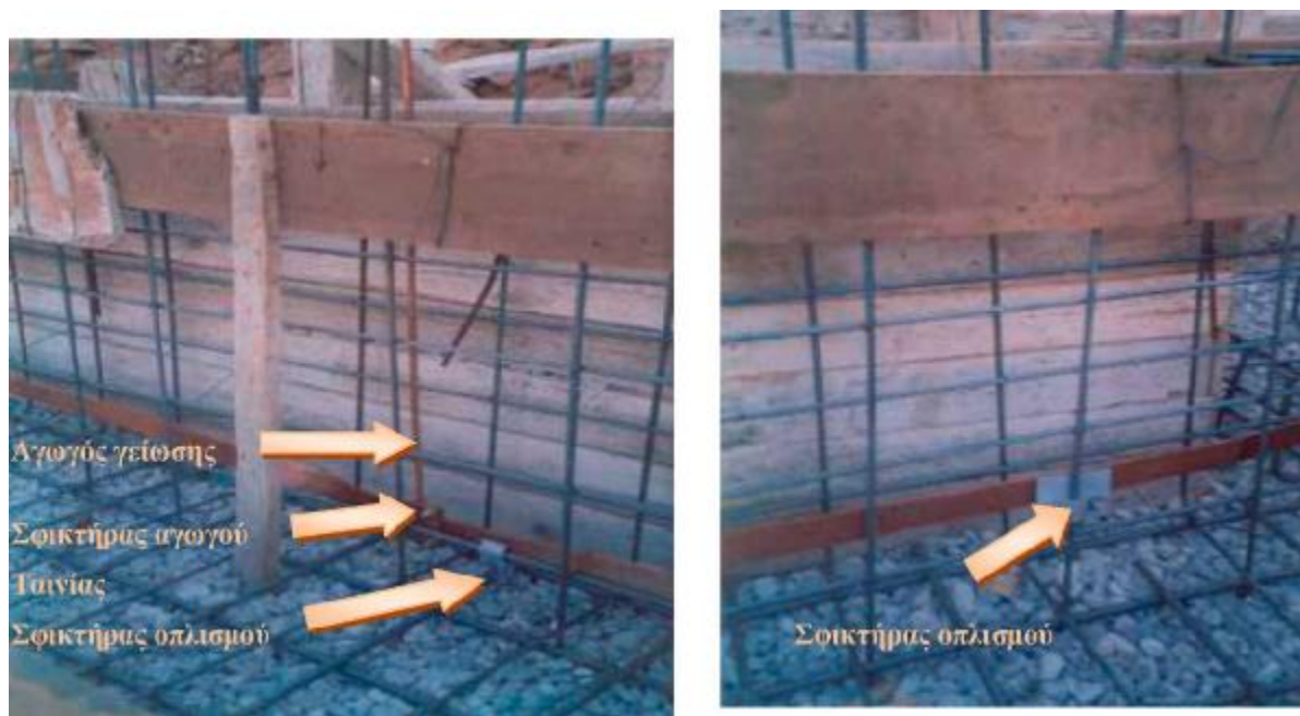
Σχήμα 4.2 Τρόποι σύνδεσης θεμελιακής γείωσης στα θεμέλια κτηρίου
