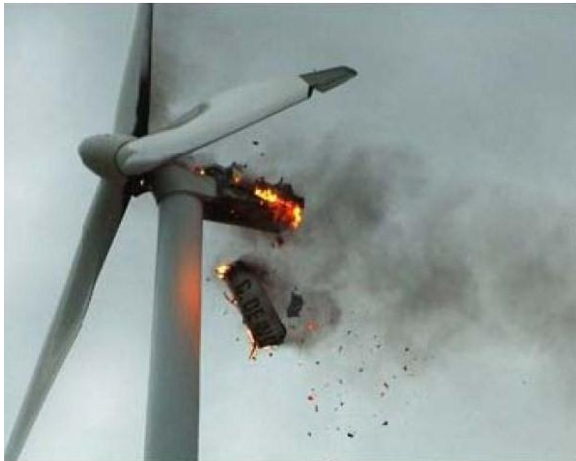
Εικόνα 15: Πλήγμα Α/Γ από κεραυνό
