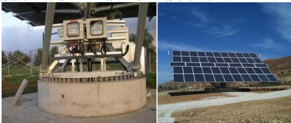
Εικόνα 4.2. - Σύστημα παρακολούθησης ηλιακής ακτινοβολίας(ηλιοτρόπιο, suntrackingsystem)
