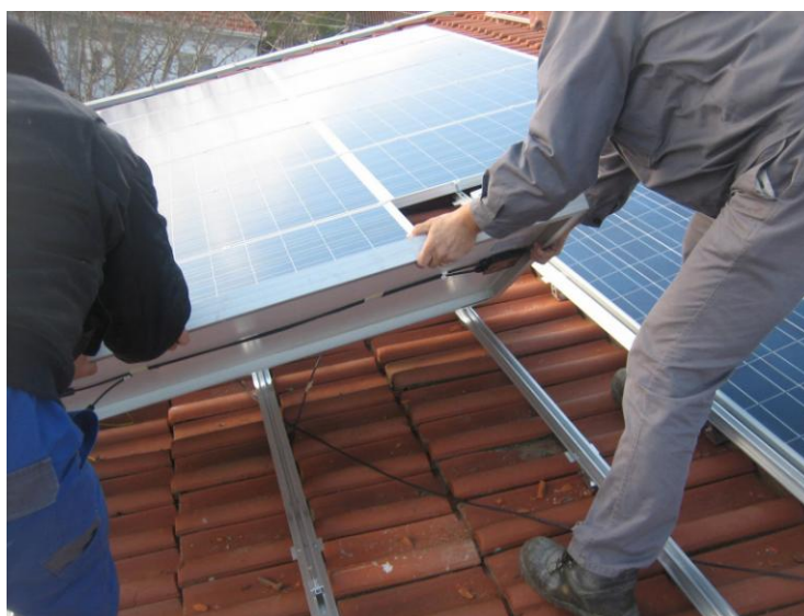
Εικόνα. Τοποθέτηση φωτοβολταικών σε ειδική βάση προσαρμοζόμενη στο εξωτερικό του κελύφους
