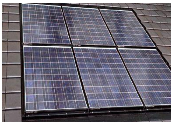
Εικόνα. Φωτοβολταϊκό πλαίσιο με απευθείας τοποθέτηση
