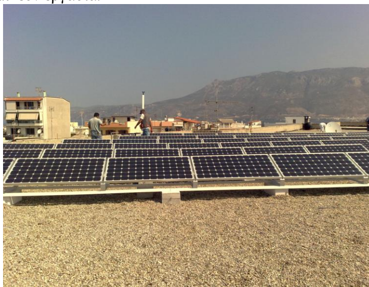
Εικόνα. Τοποθέτηση φωτοβολταικών σε κεκλιμένα στηρίγματα
