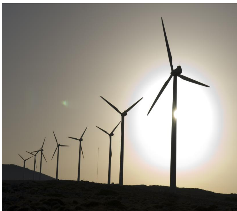
Εικόνα 4. Αιολικό πάρκο Σητείας
