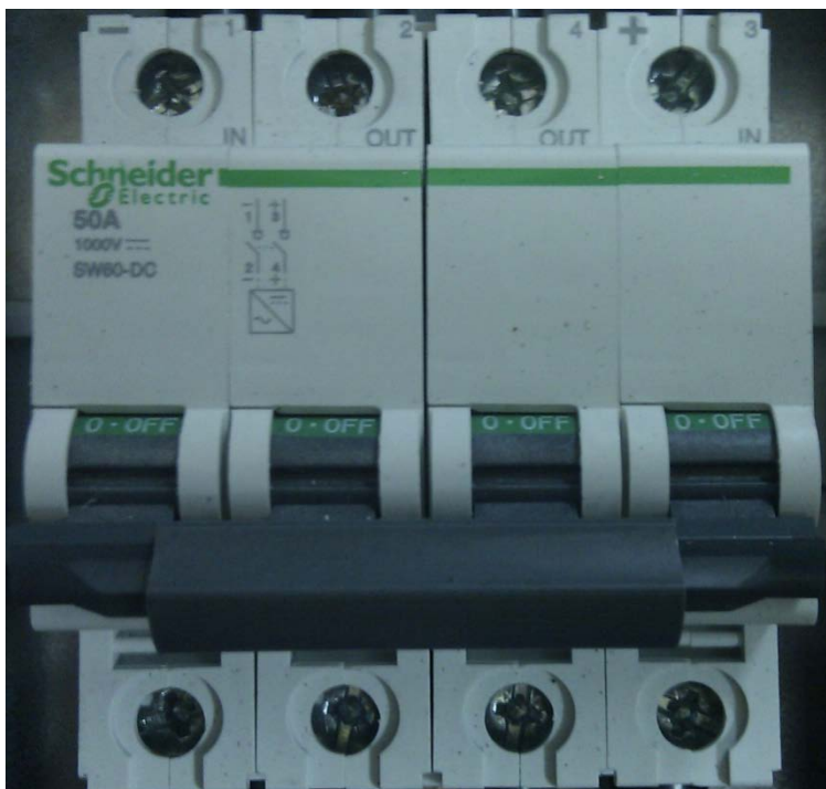
Εικόνα 5.3: Διπολικός διακόπτης συνεχούς τάσης 1000V- 50A. Χρησιμοποιείται σε πίνακες DC μέχρι 20KVA ως Γενικός διακόπτης.
