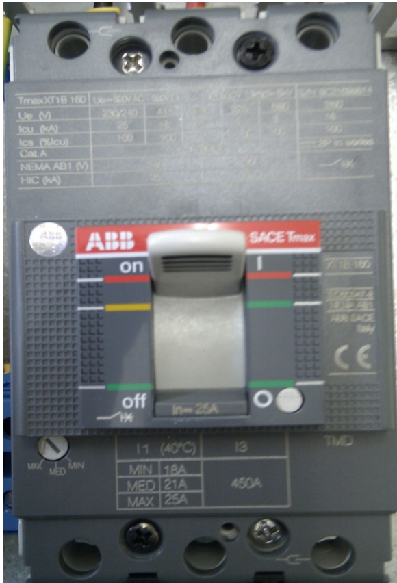
Εικόνα 5.7: Αυτόματος διακόπτης ισχύος 25 A.
