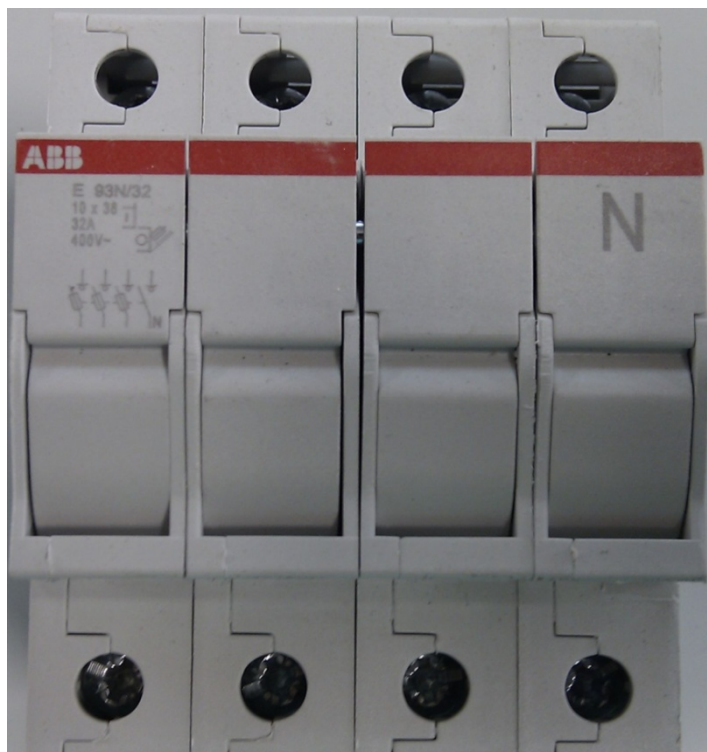
Εικόνα 5.8: Ασφαλειοαποξεύκτης AC τετραπολικός, τρεις φάσεις και ουδέτερος.
