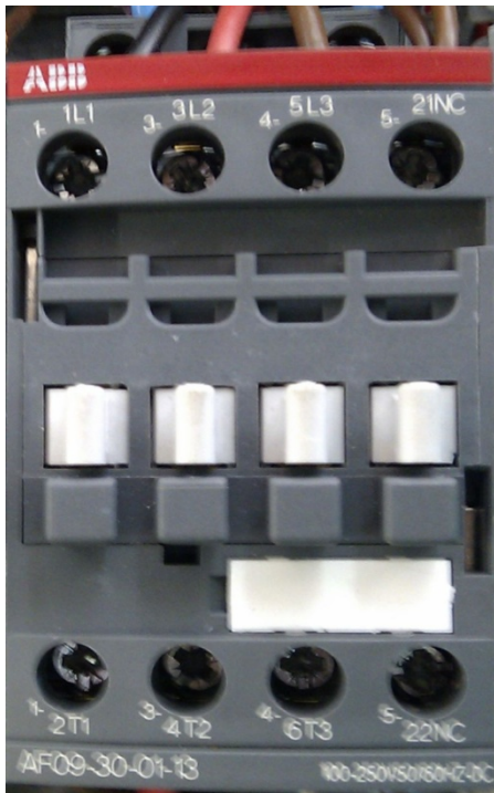
Εικόνα 5.6: Ηλεκτρονόμοι για τον αυτοματισμό των φωτοβολταϊκών.
