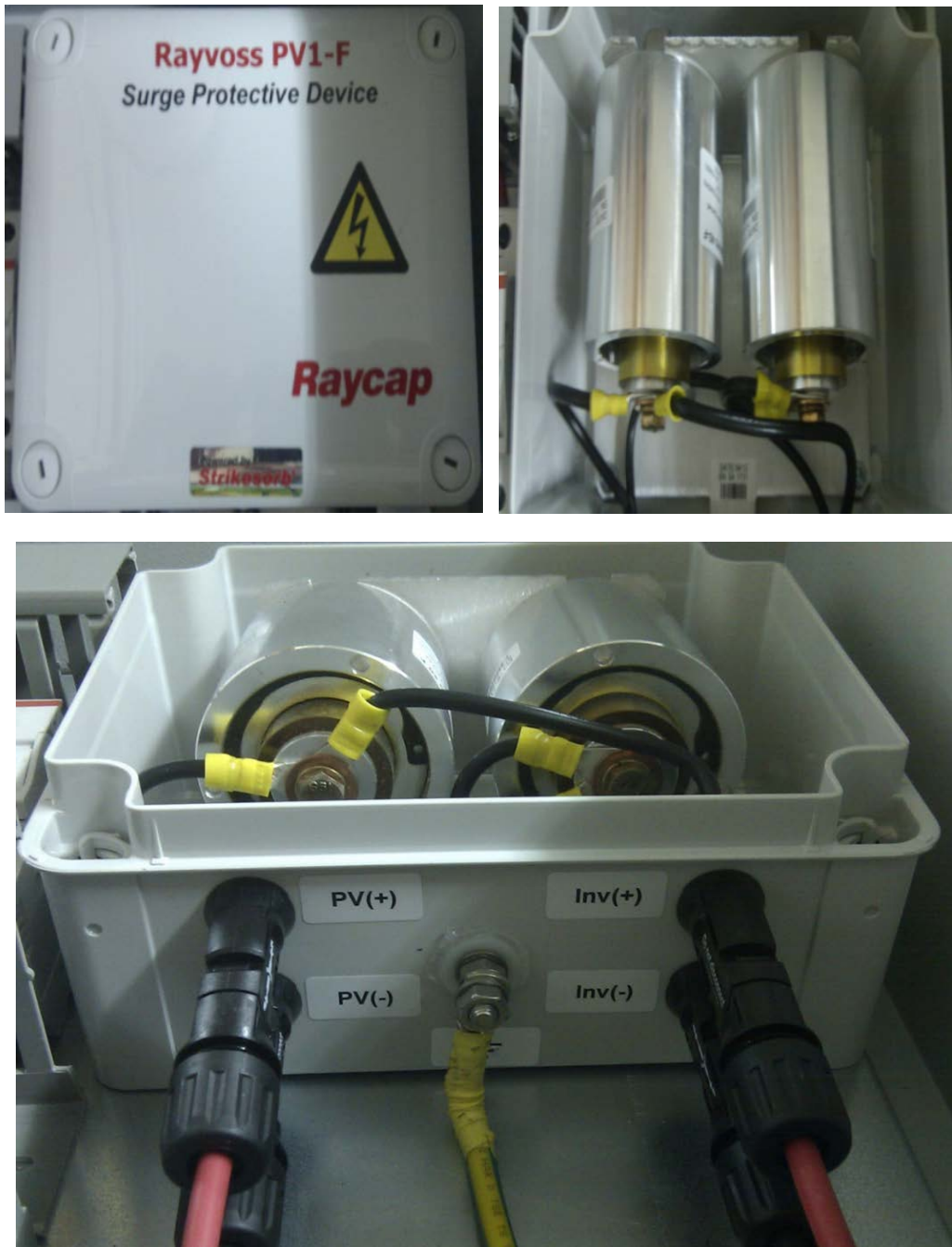
Εικόνα 5.4: Αντικεραυνικό βαρέως τύπου DC 140KA. Όταν η τάση ξεπεράσει τα επιτρεπτά όρια του αντικεραυνικού γίνεται διάσπαση διακένου και το ρεύμα κατευθύνεται προς την γη.
