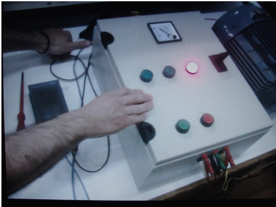
Στάση λειτουργίας του κινητήρα με την χρήση του τερματικού διακόπτη
