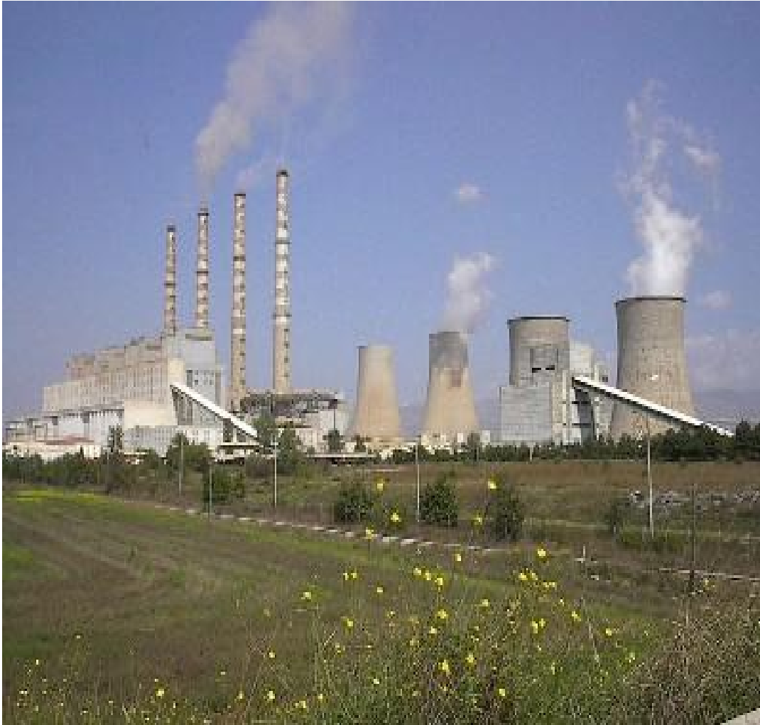
Εικόνα 13: βιομηχανία εκμετάλλευσης της βιομάζας
