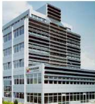
χρήση Φ/Β ως οριζόντιοι πρόβολοι (σκίαστρα) σε κτίριο γραφείων στην Γερμανία Πηγή: Photovoltaics in buildings
