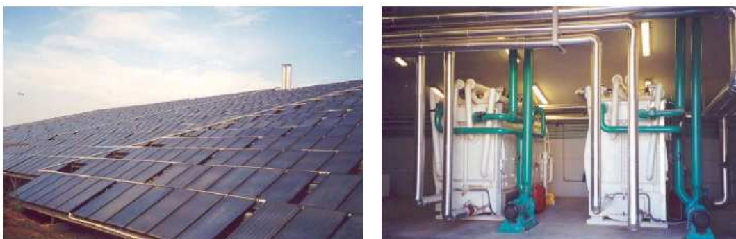
Σχήμα: Πεδίο επίπεδων ηλιακών συλλεκτών (αριστερά) και ηλιακοί ψύκτες (δεξιά).
