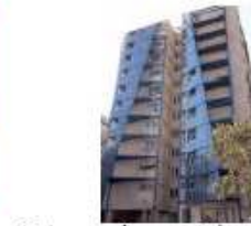
Πολυκατοικία στον Ταύρο (12 kWp)
