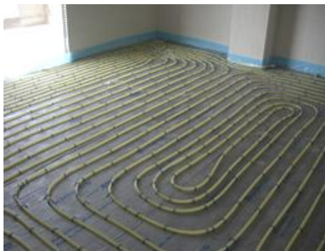
Σχήμα 5.6: Απεικόνιση ενδοδαπέδιας θέρμανσης
