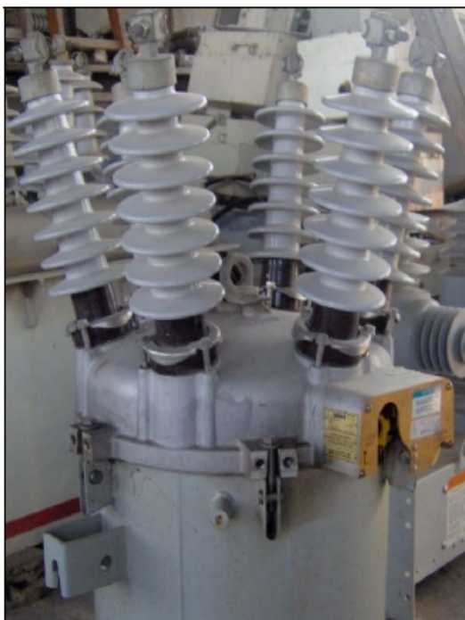
Εικόνα 2,9 : Κυλινδρικός Δ/ΑΕ τύπου ΚFVME
