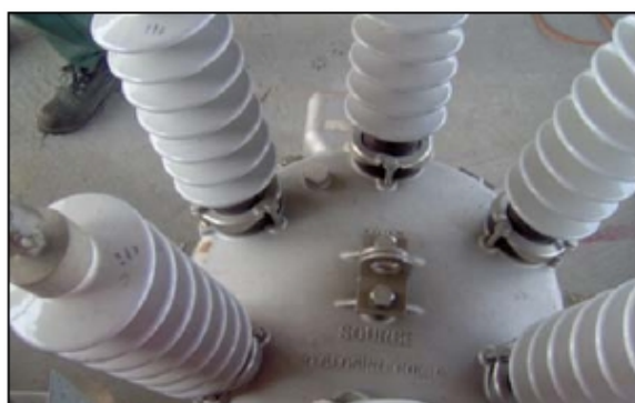
Εικόνα 2,9 : Κυλινδρικός Δ/ΑΕ τύπου ΚFVME
