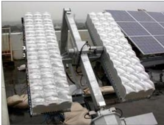
Εικόνα 4: Πολικό ηλιοτρόπιο με συγκεντρωτικά πλαίσια
