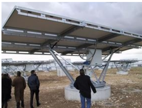
Εικόνα: Ηλιοτρόπιο δυο αξόνων
