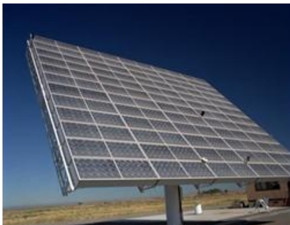
Εικόνα 1: Ηλιοτρόπιο με συγκεντρωτικά Φ/Β πλαίσια
