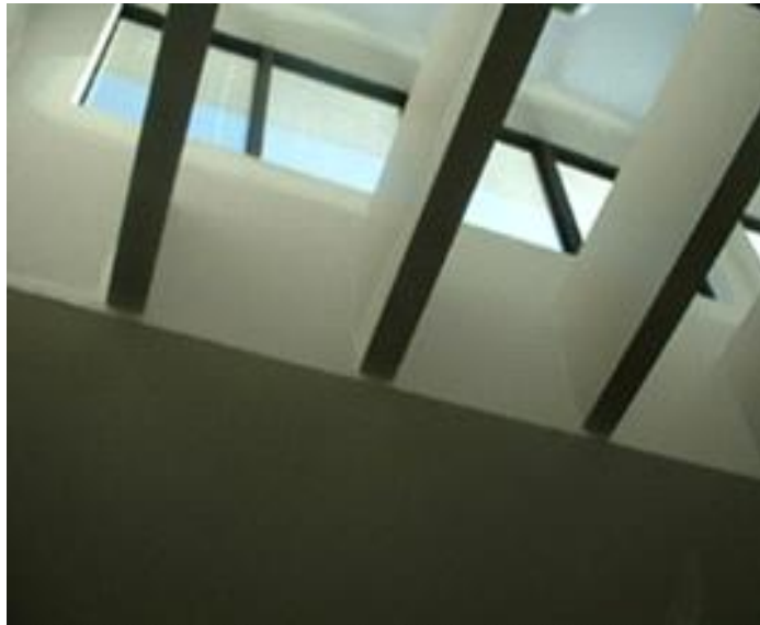
-Ανοίγματα οροφής σε κατοικία-
