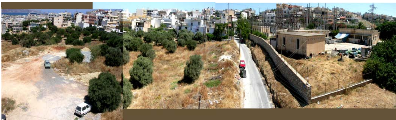
Δεξιά διακρίνεται ο υποσταθμός της ΔΕΗ – πηγή προσωπικό αρχείο
