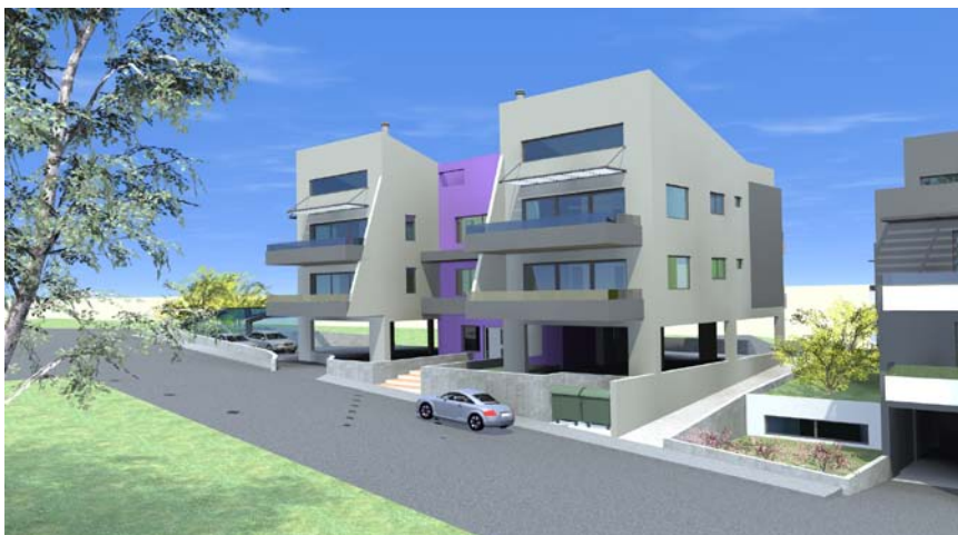
Κτίριο 1B(μόβ) – πρόσοψη επί της οδού Μελετίου Μεταξάκη- πηγή προσωπικό αρχείο
