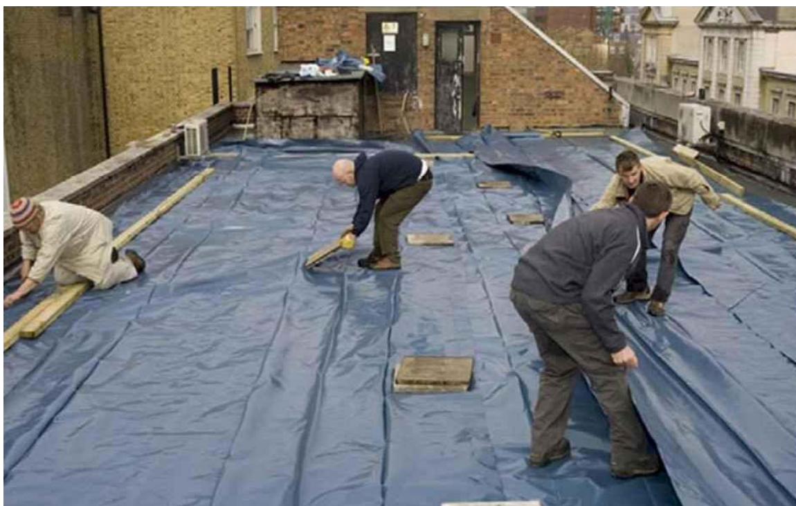
Τοποθέτηση μανδύα στέγνωσης - πηγή Internet
