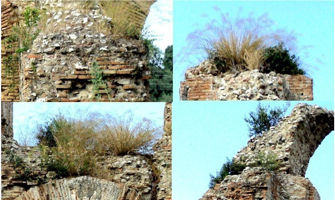
Εικόνα 4. 21 Ανάπτυξη χαμηλής βλάστησης στη στέψη των τοίχων
