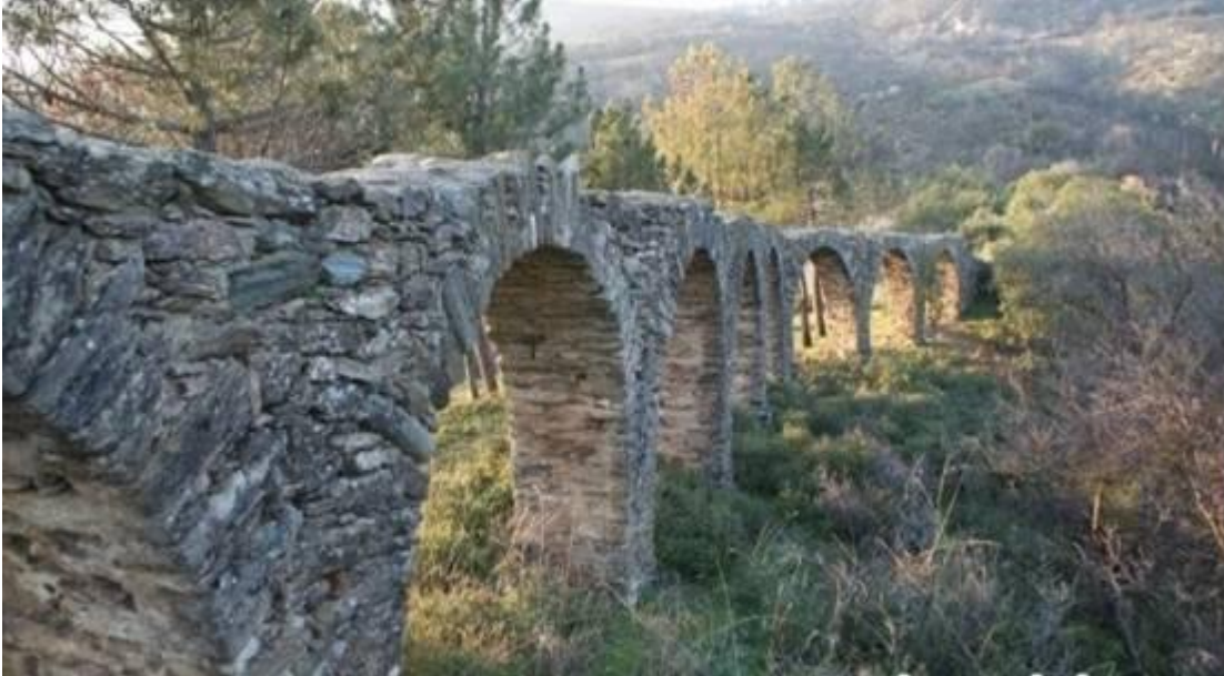
Εικόνα 1.10 Υδραγωγείο Μεταξοχωρίου Αγιάς
