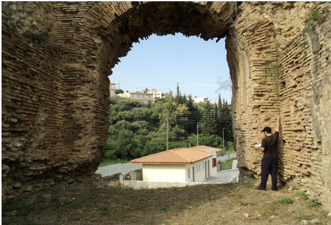
Εικόνα 4. 13 Καμάρα τμήματος του υδραγωγείου
