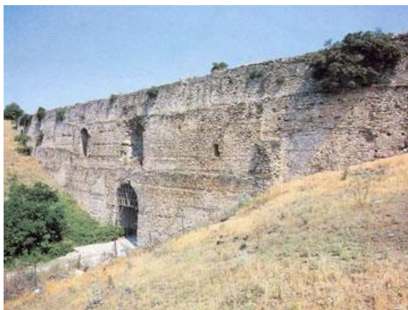
Εικόνα 1.8 Υδραγωγείο του Χορτιάτη
