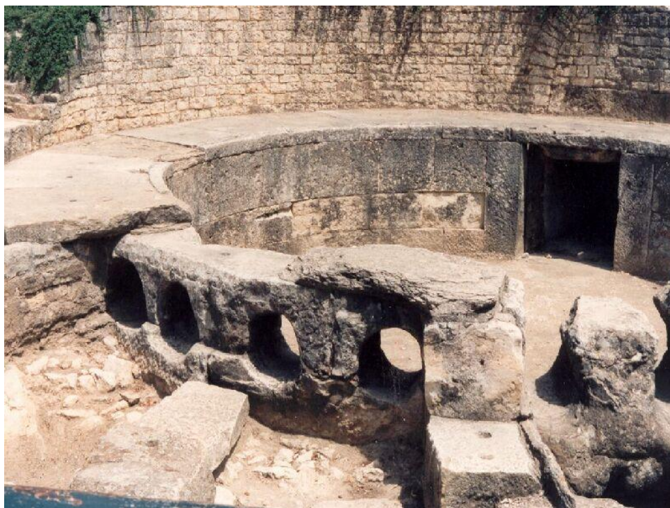
Εικόνα 2. 22 Λεκάνη διανομής ( castellum divisorium ) στο τέλος του υδραγωγείου της πόλης Νιμ στη Γαλλία
