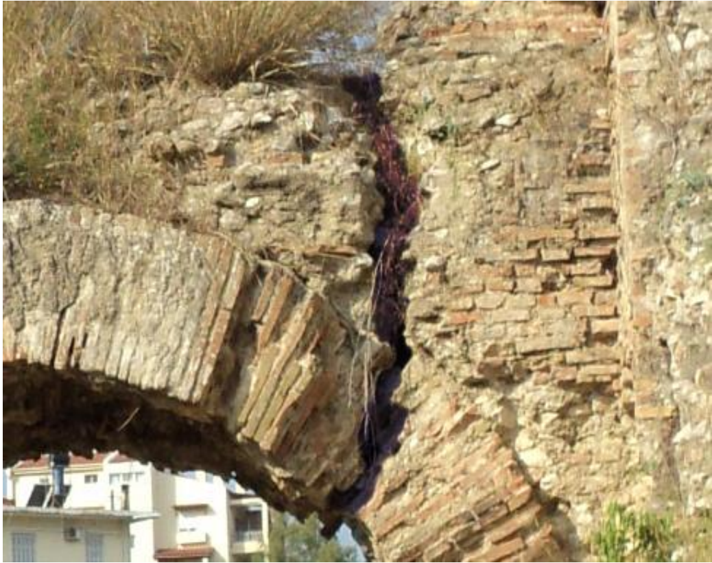
Εικόνα 4. 15 Διαμπερές ρηγμάτωση
