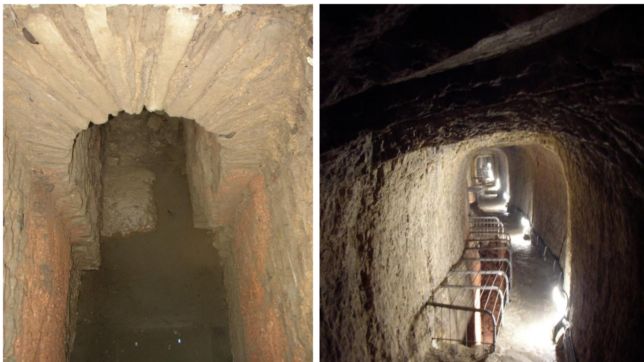
Εικόνα 2. 12 α) Σήραγγα υδραγωγείου στη Λυών β) Σήραγγα υδραγωγείου στη Σάμο
