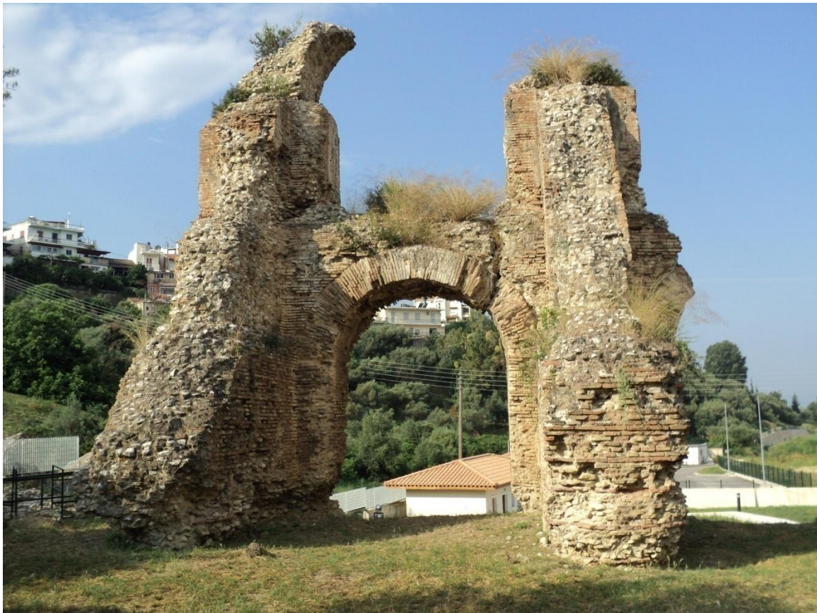
Εικόνα 2. 6 Σημερινή κατάσταση τμήματος του ρωμαϊκού υδραγωγείου
