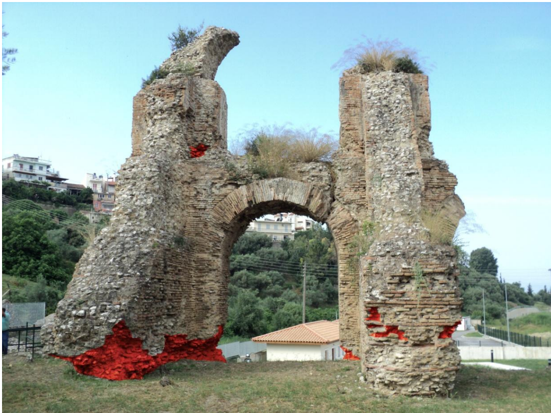
Εικόνα 4. 18 Αποδιοργάνωση, αποσάθρωση και αποκόλληση κονιάματος
