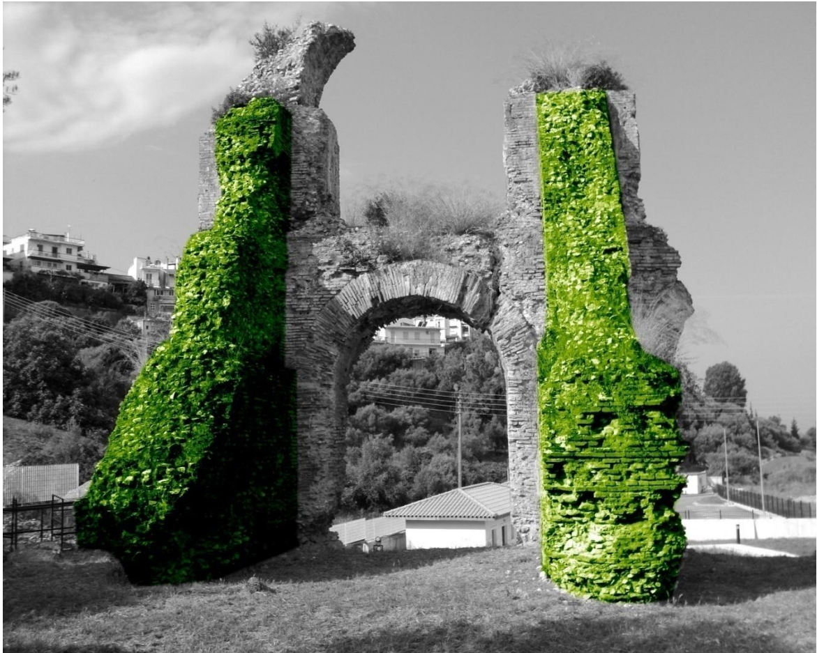
Εικόνα 4.14 Αντηρίδες τμήματος του υδραγωγείου
