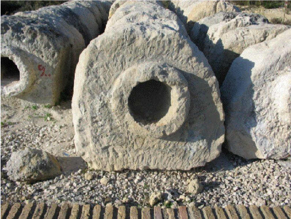
Εικόνα 2. 25 Σωλήνες του υδραγωγείου του Cadiz (Ισπανία)
