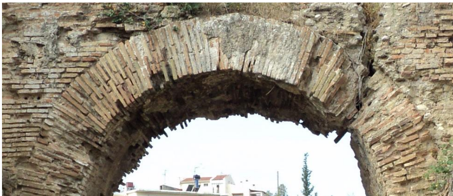
Εικόνα 4. 11 Καμάρα χωρίς κεντρικό κλειδί
