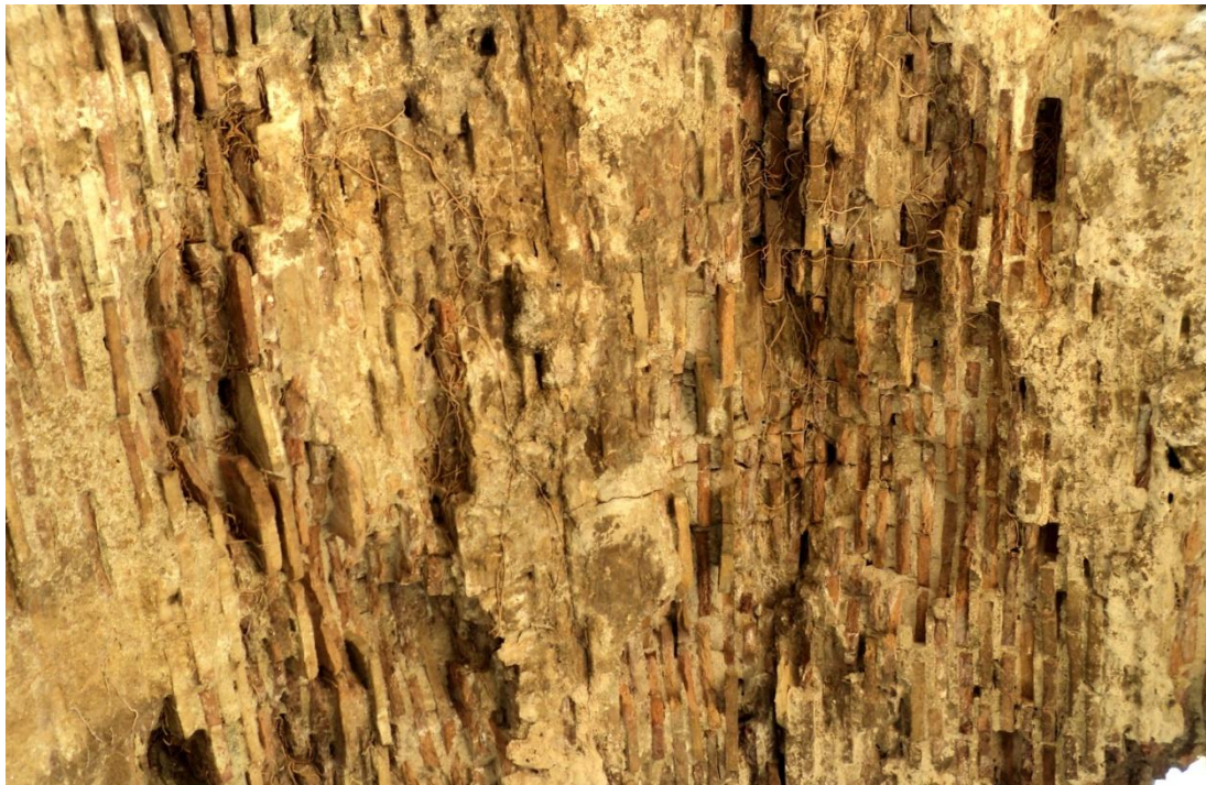
Εικόνα 4. 20 Ανάπτυξη φυτικών ριζών στον ημικυλινδρικό θόλο της κάμαρας
