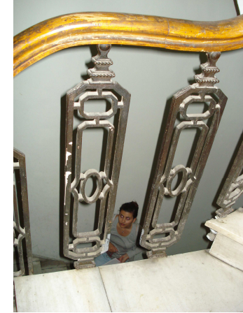
(Κλιμακοστάσιο β κτιρίου φωτ. 67)
