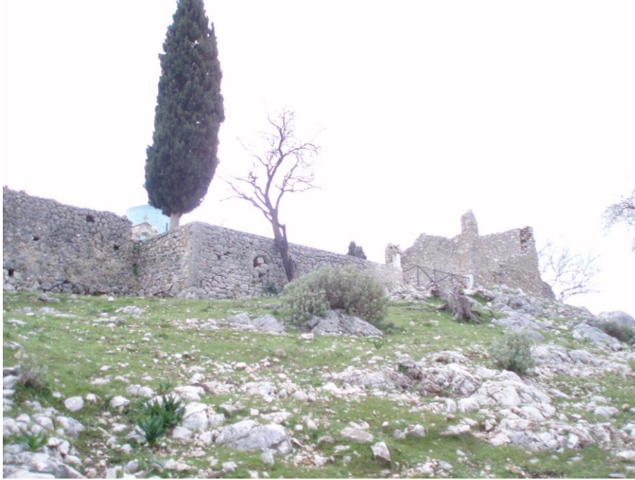
5. Εξωτερική άποψη της Μονής (2).
