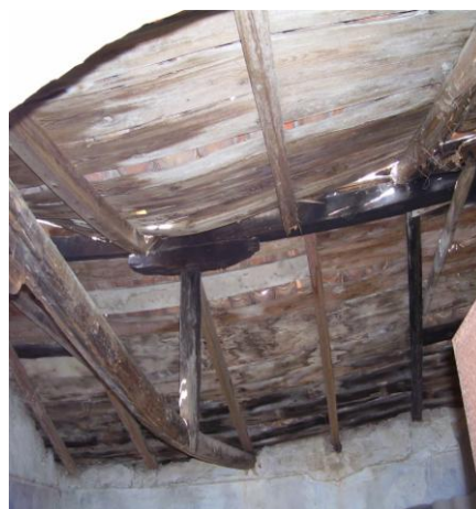
87. Υποχώρηση τμήματος της στέγης στα κελιά (K2)
