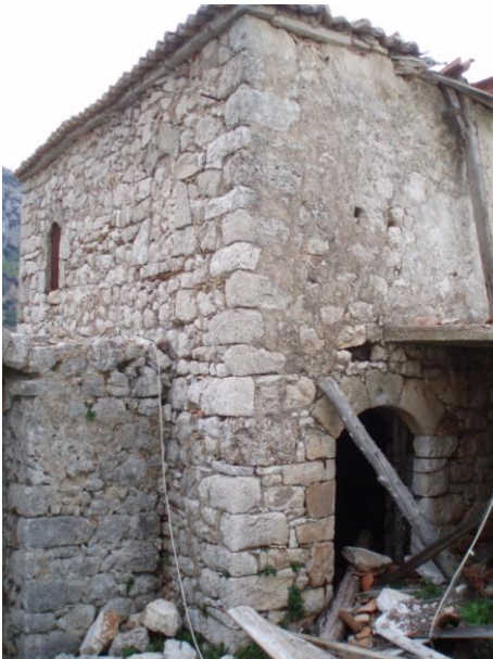
19. Μη προσβάσιμος χώρος στο ισόγειο των κελιών. (©10)
