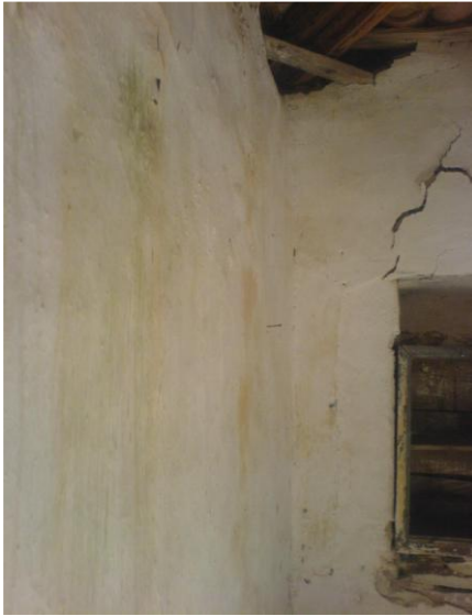
78. Ρωγή σε τοιχοποιία στο εσωτερικό κελιού (Κ2) 79. Διάβρωση εξωτερικού τοίχου (Κ2)
