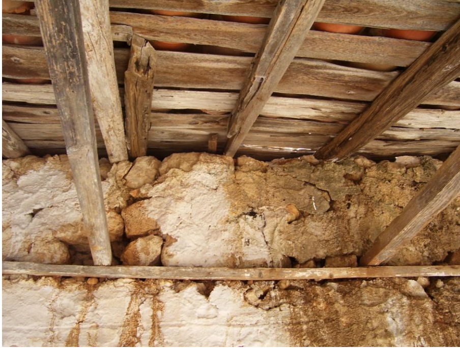
49. Μέρος της στέγης εξωτερικά.
