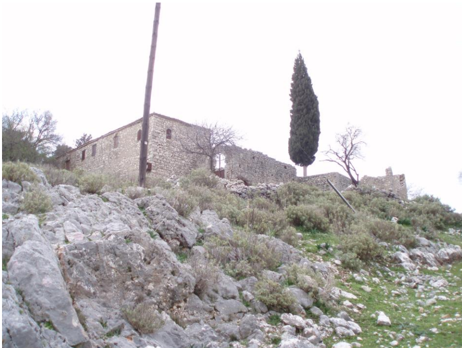
4.Εξωτερική άποψη της Μονής (1).
