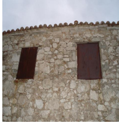
48. Σφραγισμένο άνοιγμα στο νότιο τείχος των κελιών (Π1)
