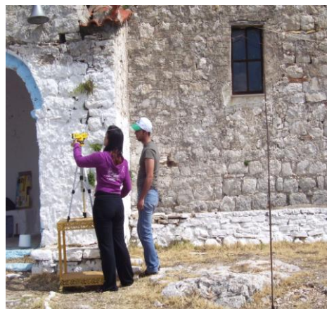
5. Χρήση laser για τη χωροστάθμιση
