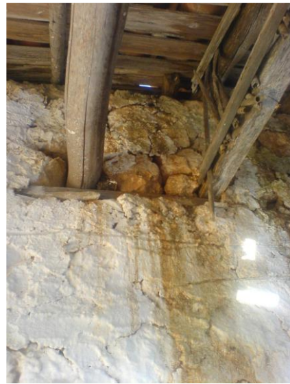
78. Ρωγή σε τοιχοποιία στο εσωτερικό κελιού (Κ2) 79. Διάβρωση εξωτερικού τοίχου (Κ2)
