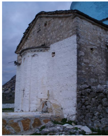
55. Ασβέστης εξωτερικά στο ιερό
