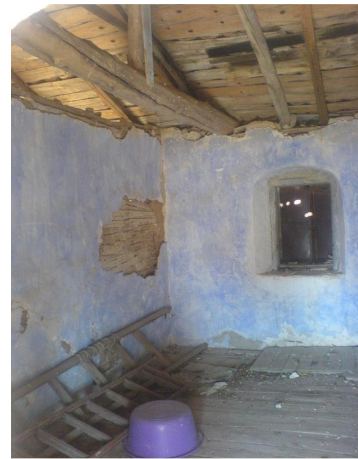
56. Επίχρσιμα εσωτερικά σε κελί
