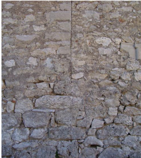
27. Κατασκευαστικός αρμός με παρουσία γωνιόλιθων 28. Το προστώον
