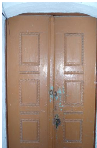
52. Μεταλλικό κούφωμα σε κελί (Θ4)
