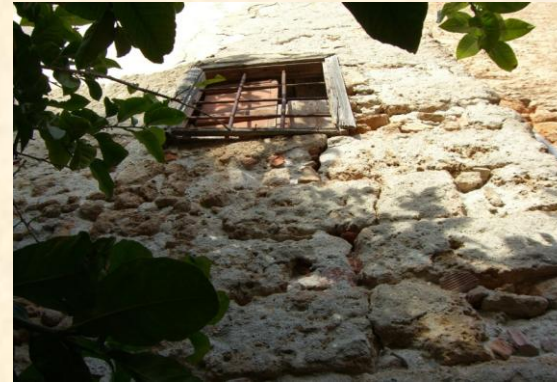
Εικόνα 25: Εξωτερική τοιχοποιία στην ανατολική πλευρα του κτιρίου
