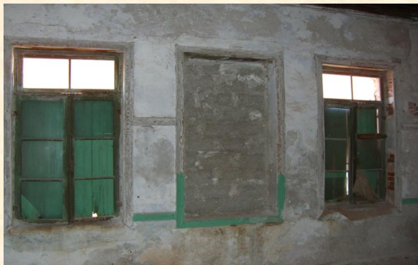
Εικόνα 57: Αποσάθρωση ξύλινων στοιχείων και κλείσιμο ανοιγμάτων με οπτόπλινθους
