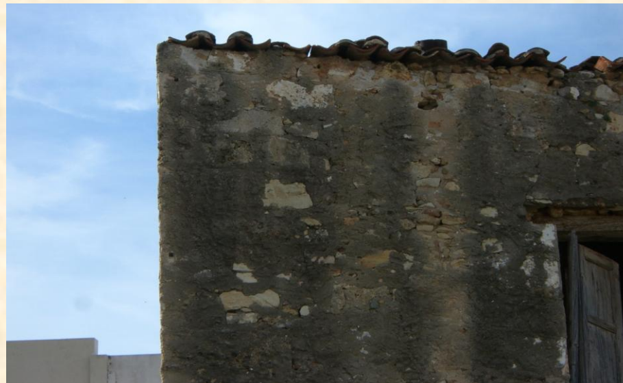
Εικόνα 30: Μέρος τοιχοποιίας στο ανατολικό τμήμα του κτιρίου
