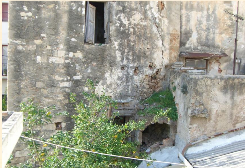
Εικόνα 33: Μέρος τοιχοποιίας στο νότιο τμήμα του κτιρίου
