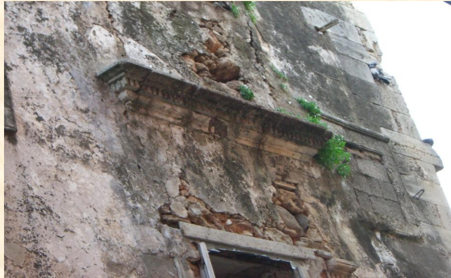
Εικόνα 29: Μέρος τοιχοποιίας στο βόρειο τμήμα του κτιρίου
