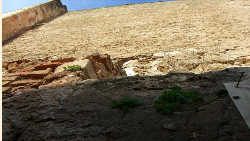
Εικόνα 32: Μέρος τοιχοποιίας στο ανατολικό τμήμα του κτιρίου
