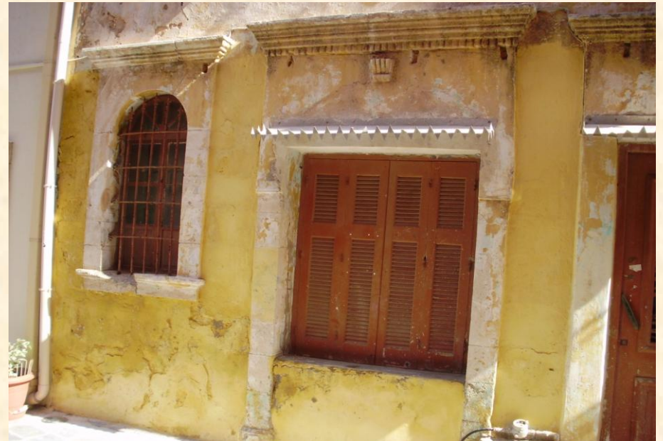
Εικόνα 44: Παράθυρα βόρειας όψης
