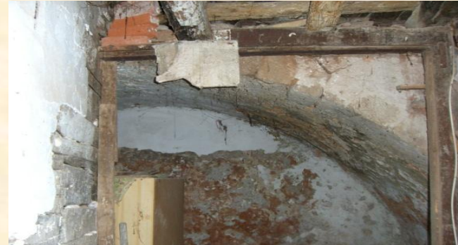
Εικόνα 46: Μέρος του θόλου στο ισόγειο του κτιρίου
