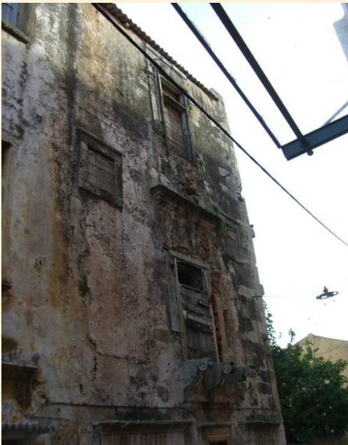
Εικόνα 24: Βόρεια όψη, β΄ όροφος
