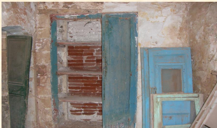
Εικόνα 53: Κουφώματα και ντουλάπια αποσαθρωμένα και σπασμένα
