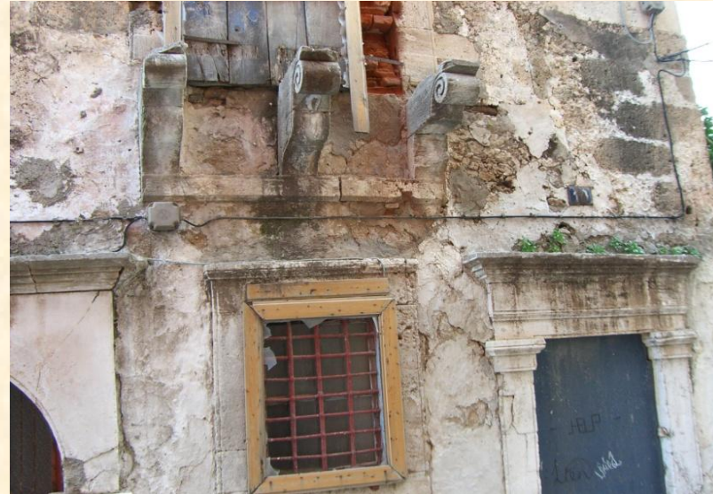
Εικόνα 48: Φουρούσια στην βόρεια πλευρα του κτιρίου
