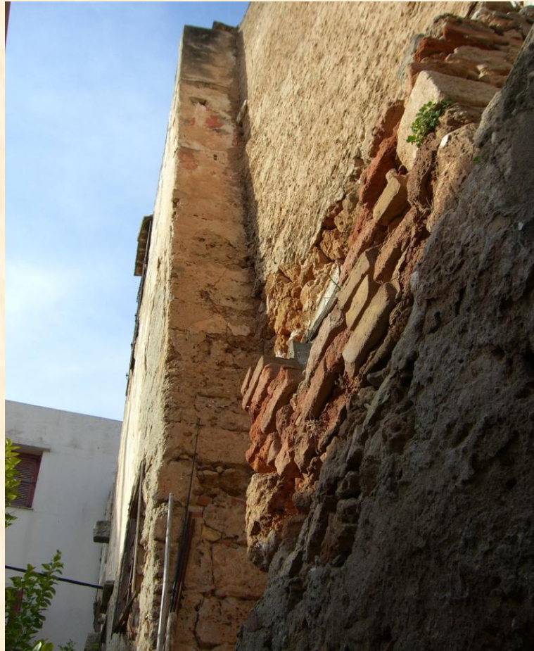
Εικόνα 31: Μέρος τοιχοποιίας στο ανατολικό τμήμα του κτιρίου
