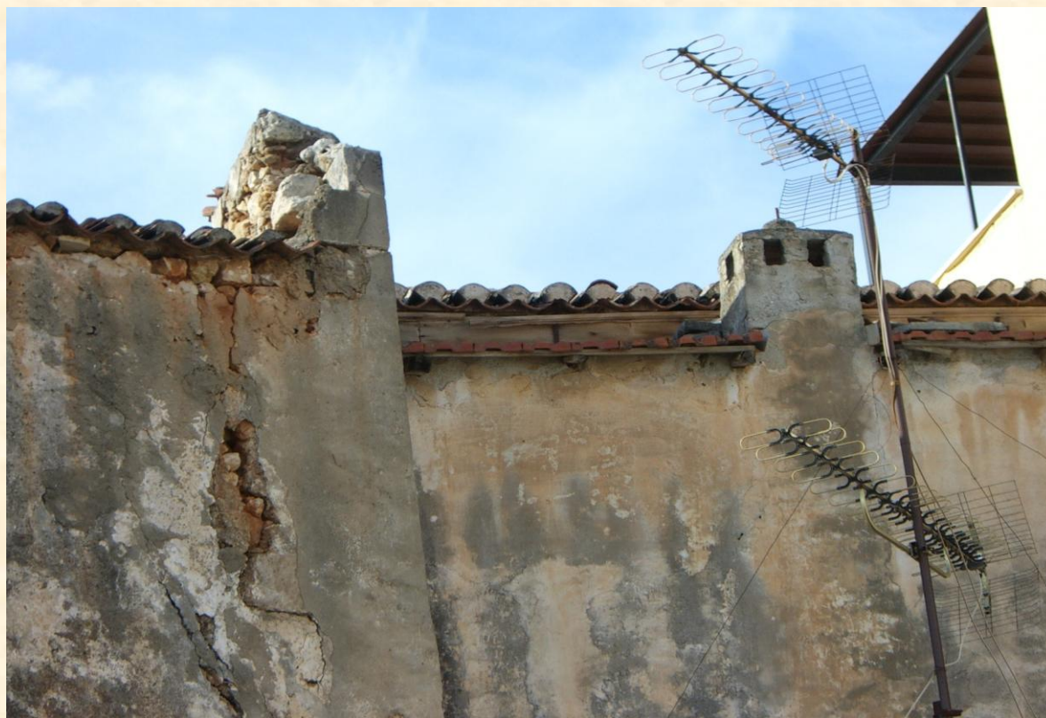
Εικόνα 68: Καθαίρεση επιχρίματος
