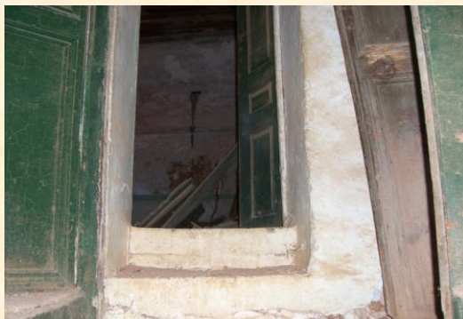
Εικόνα 51: Εσωτερικά ξύλινα κουφώματα τα οποία έχουν καθαιρεθεί
