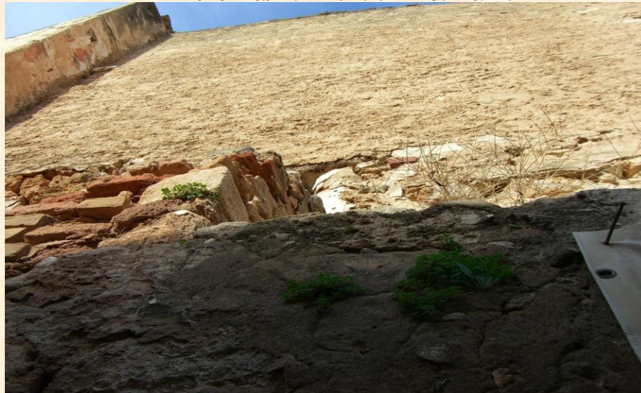
Εικόνα 65: Εμφάνιση πρασινάδας, αποκόλληση μεγάλου μέρους του επιχρίσματος
