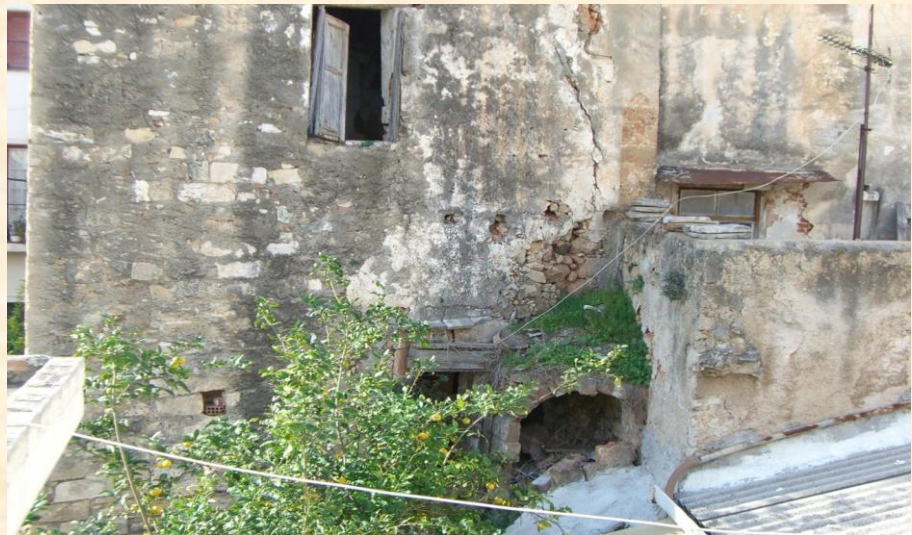
Εικόνα 67: Πρασινάδα, ρογμές, αλλοίωση χρώματος, καθαίρεση επιχρίσματος
