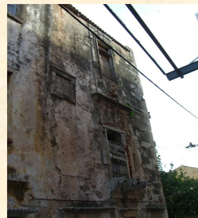
Εικόνα 35: Παράθυρα Βόρειας πλευράς
