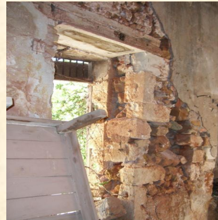
Εικόνα 26: Μέρος τοιχοποιίας στο εσωτερικό του κτιρίου
