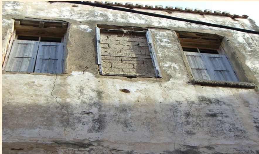
Εικόνα 63: Καθαίρεση κουφωμάτων, δημιουργία ρογμών
