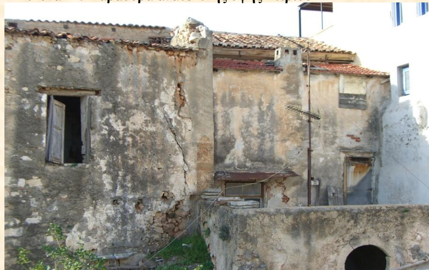
Εικόνα 42: Παράθυρα στη νότια όψη του κτιρίου
