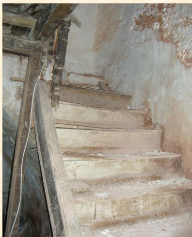
Εικόνα 49: Εσωτερική σκάλα που οδηγεί από το ισόγειο στον α΄ όροφο
