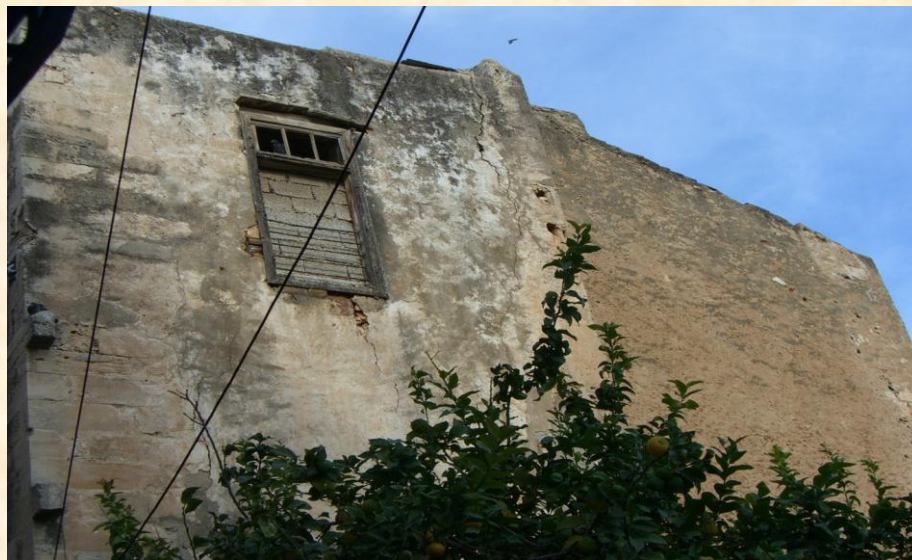
Εικόνα 66: Ρογμές, αλλοίωση χρώματος
