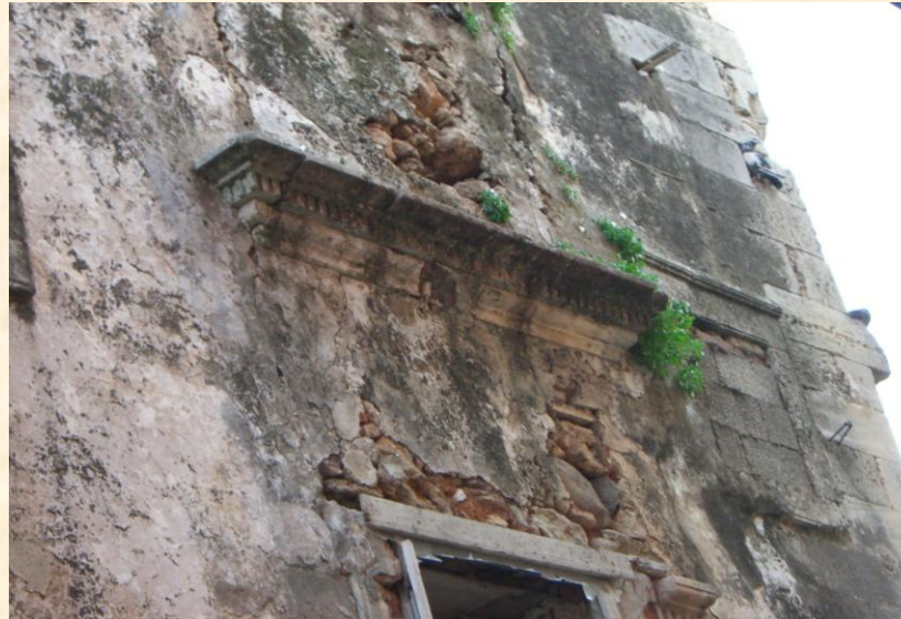
Εικόνα 61: Εμφάνιση πρασινάδας και μούχλας. Αποκόλληση μεγάλου μέρους της τοιχοποιίας
