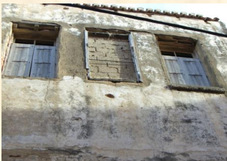
Εικόνα 34: Παράθυρα Βόρειας πλευράς
