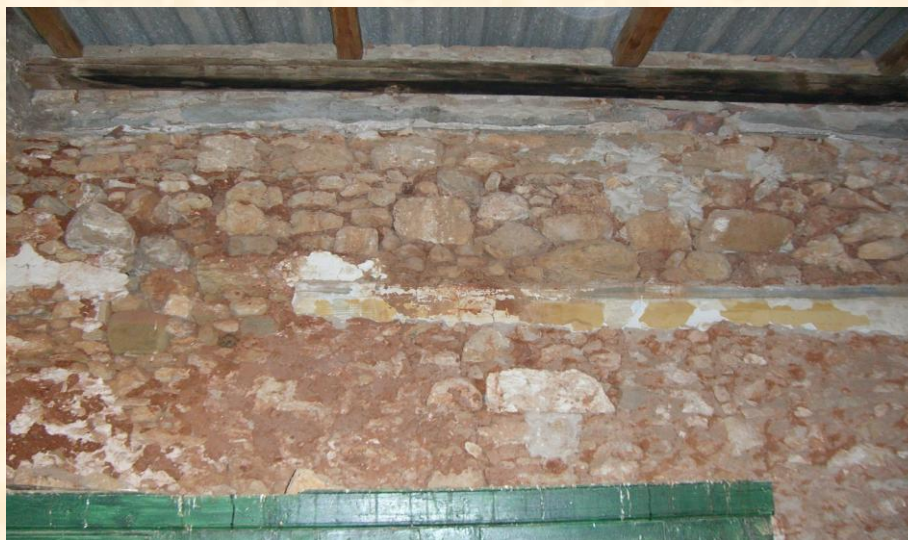
Εικόνα 28: Μέρος τοιχοποιίας στο εσωτερικό του κτιρίου στον β' όροφο
