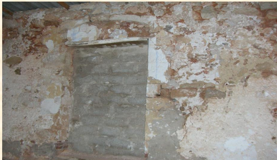
Εικόνα 27: Μέρος τοιχοποιίας στο εσωτερικό του κτιρίου στον α' όροφο
