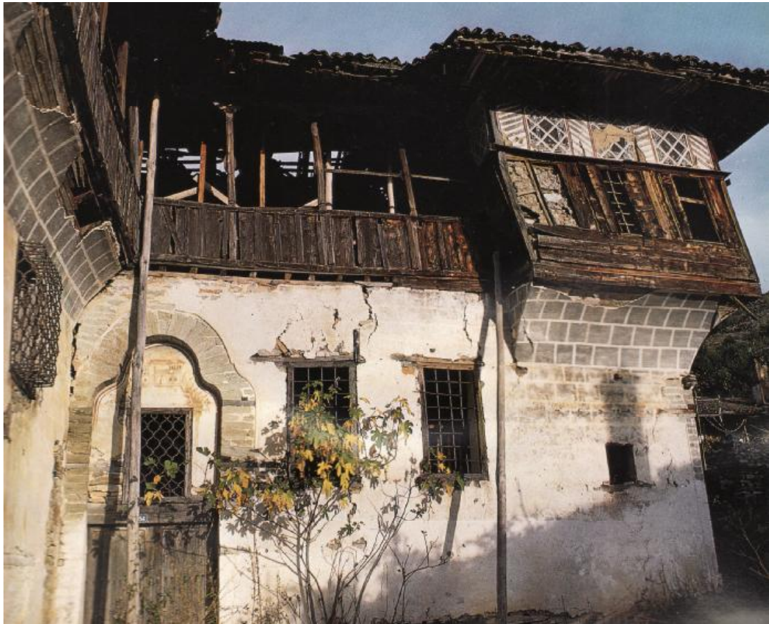
Εικόνα 11. Αποψη του ΝΑ τοίχου όπου διακρίνεται η απομίμηση ισόδομου συστήματος στο μεσοπάτωμα αλλά και η απομίμηση ορθομαρμάρωσης με την παρεμβολή των ζωγραφιστών φεγγιτών στη φρίζα του κιοσκιού (Αναστασία Διαμ. Διαμαντοπούλου, «Αμπελάκια», στο Ελληνική παραδοσιακή αρχιτεκτονική, ό.π., σ. 147).
