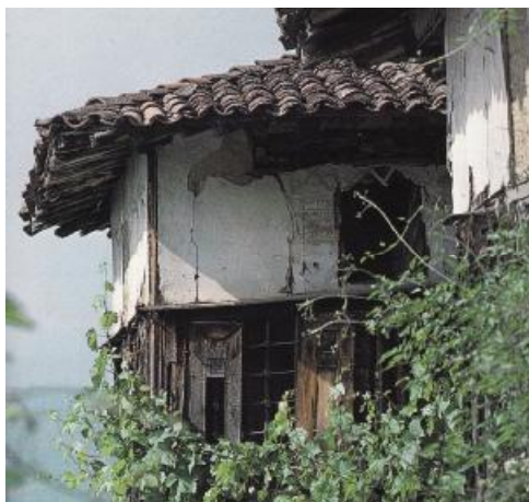
Εικόνα 15. Άποψη της φρίζας που φιλοξενούσε την κτητορική επιγραφή (Αναστασία Διαμ. Διαμαντοπούλου, «Αμπελάκια», στο Ελληνική παραδοσιακή αρχιτεκτονική, ό.π., σ. 141).
