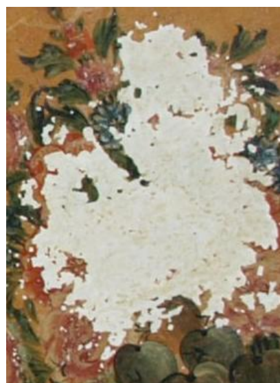
Εικόνα 2. Η προετοιμασία σε ξύλινη επιφάνεια αποκαλύφθηκε λόγω της απολέπισης των χρωμάτων στο ταβάνι του οντά του αετού στον όροφο του αρχοντικού Γ. Σβάρτς (προσωπικό αρχείο του Σ. Μ. Αραμπατζή).
