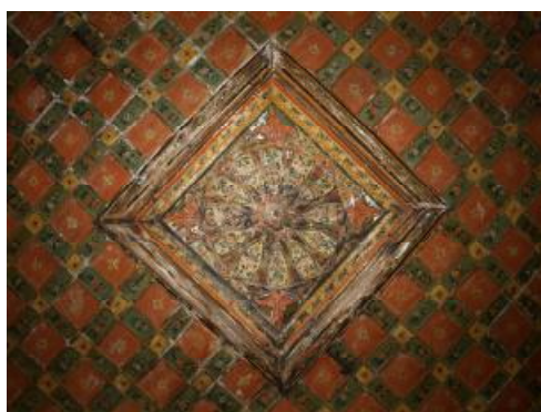
Εικόνα 61. Το φάτνωμα και τμήμα του κάμπου του ταβανιού στο βορειοδυτικό σοφά (φωτ. από προσωπικό αρχείο του Σ. Μ. Αραμπατζή).
