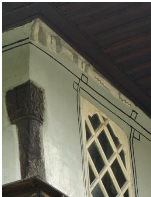
Εικόνα 8. Τα ψήγματα απομίμησης ορθομαρμάρωσης επάνω από τον αριστερό φεγγίτη της ΒΑ φρίζας του οντά του αετού του ορόφου (προσωπικό αρχείο του Σ. Μ. Αραμπατζή).
