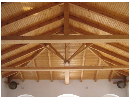
Εικ. 40 : Στέγη χώρου 1.01
