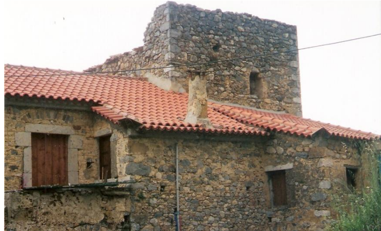
Εικ. 29 : Ανατολική όψη πύργου
