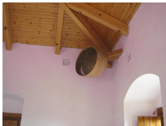
Εικ. 41 : Στέγη χώρου 1.01
