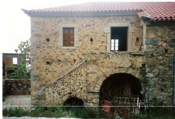
Εικ. 23 : Ανατολική όψη, καμάρες κάτω από σκάλα
