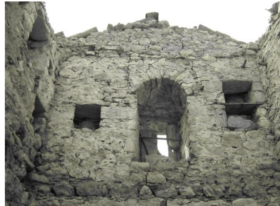
Εικ. 49 : Δυτική εσωτερική όψη πύργου
