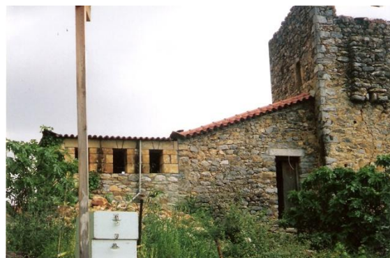
Εικ. 25 : Βόρεια όψη
