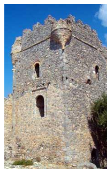
Εικ. 14 : Πύργος Καπετανάκη
