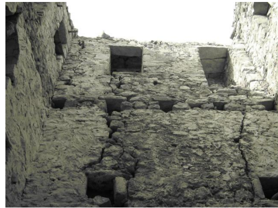
Εικ. 47 : Βόρεια εσωτερική όψη πύργου
