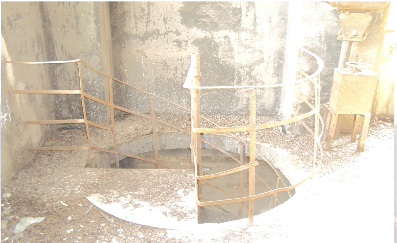
Σκάλα που οδηγεί στο υπόγειο
