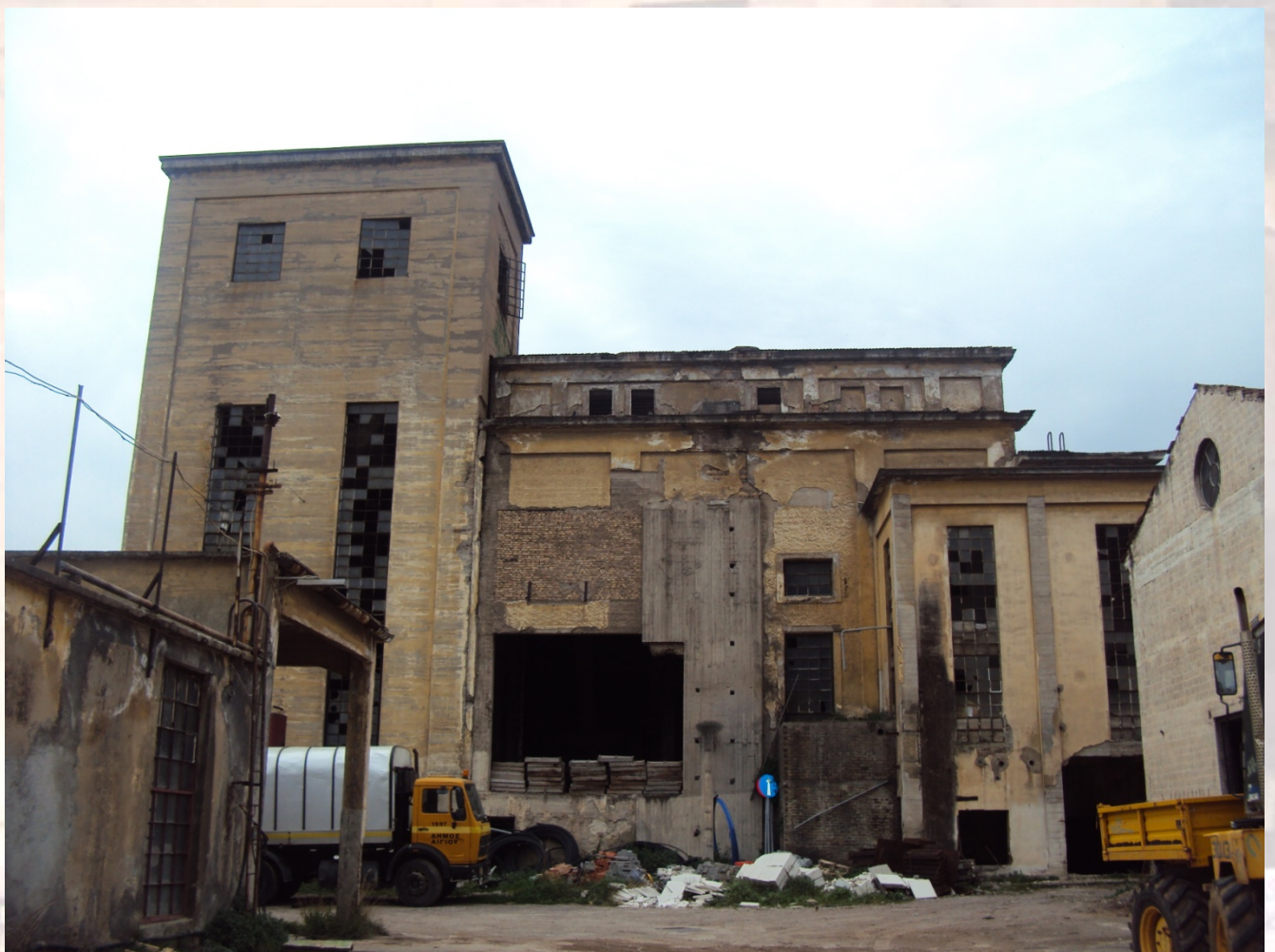
Βορειοανατολική όψη λεβητοστασίου
