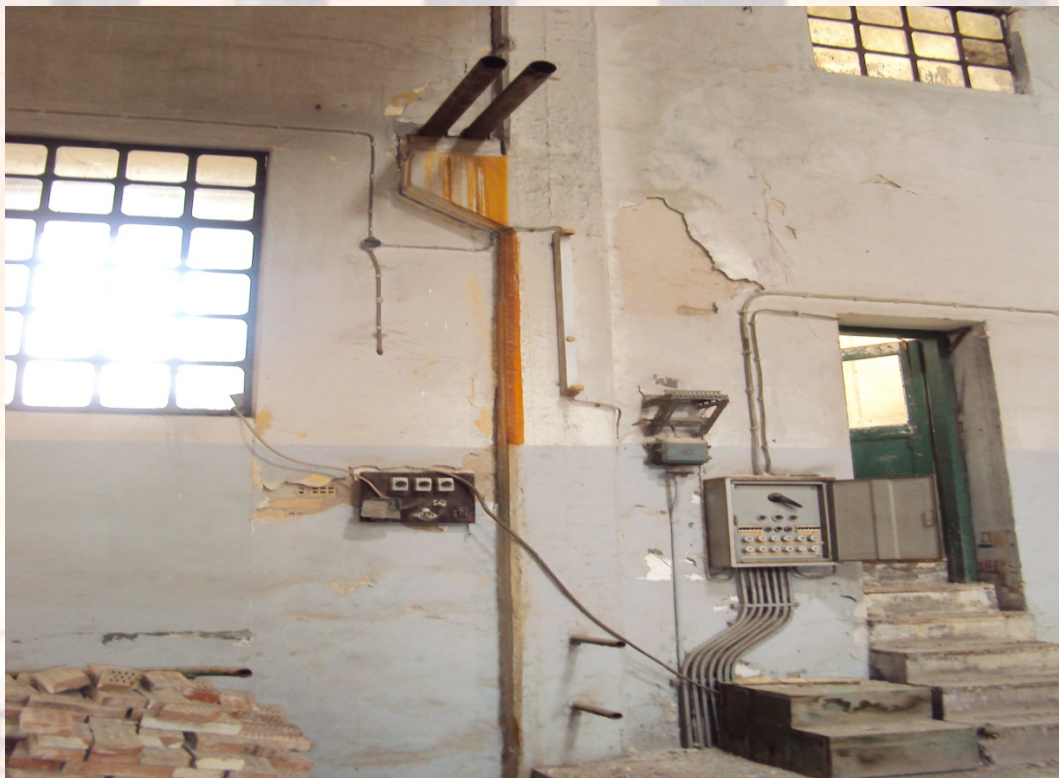
Είσοδος στο χώρο των WC
