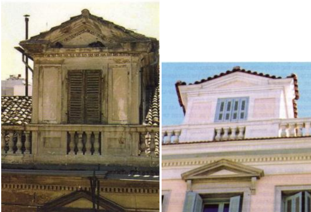
Διάκοσμος και αέτωμα κτιρίου πριν και μετά την αποκατάσταση
