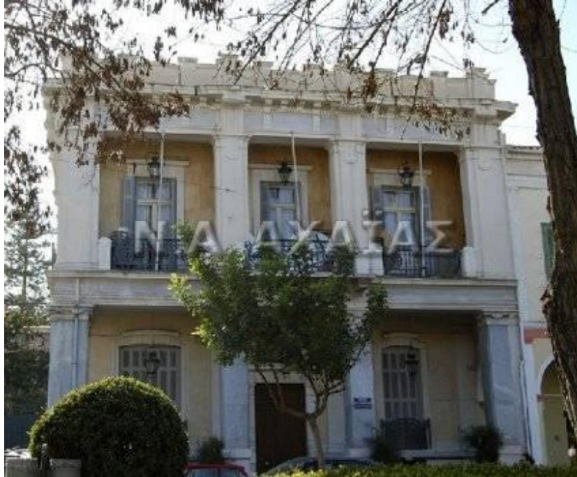
Οικία Γαλανόπουλου, 1924. Χαρακτηριστικό δείγμα αστικής κατοικίας του μεσοπολέμου, με εκλεκτικιστικό ύφος και στοιχεία άρτ-ντεκώ
