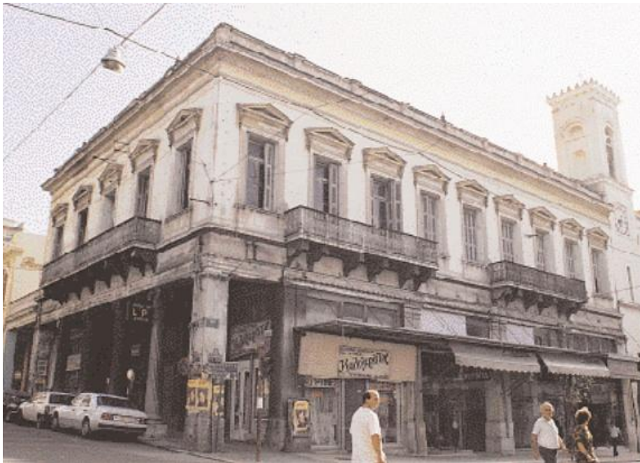
Οικία Περιβολαροπούλου Αγίου Νικολάου και Μαιζώνος, έτος κατασκευής 1900
