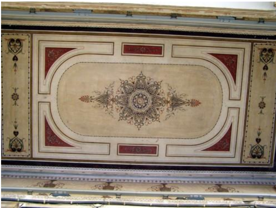
Οροφωγραφίες ισόγειας εξωτερικής στοάς κτιρίου
