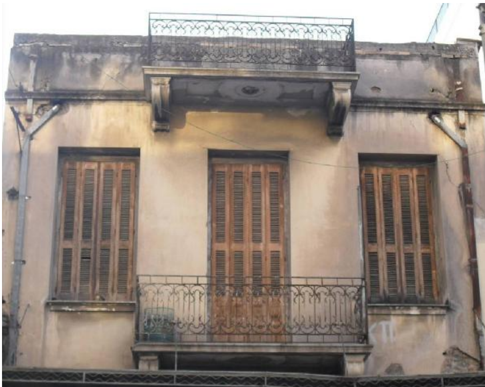
Λεπτομέρεια μαρμάρινων εξωστών και λιτής συμμετρικής διάρθρωσης ορόφου
