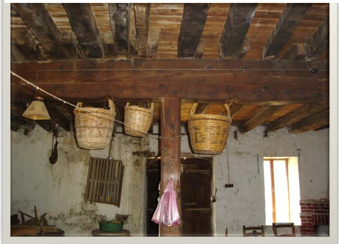
Εικόνα 26 ΠΡΟΒΟΛΗ ΤΟΥ ΔΟΚΑΡΙΟΥ ΚΑΙ ΤΟΥ ΥΠΟΣΤΥΛΩΜΑΤΟΣ ΣΤΟ ΚΕΝΤΡΟ ΤΟΥ ΚΤΙΡΙΟΥ
