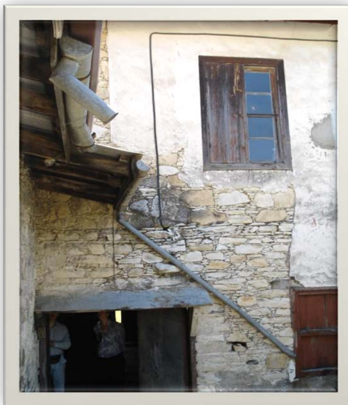
Εικόνα 31 ΔΥΤΙΚΗ ΟΨΗ ΚΤΙΡΙΟΥ
