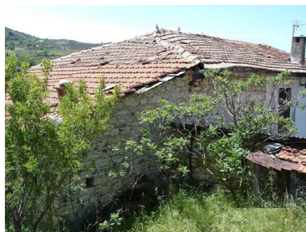
Εικόνα 19 βορειοανατολική λήψη στέγης
