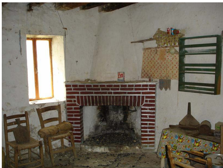
Εικόνα 30 τζάκι επενδυμένο με τουβλάκι στο ισόγειο
