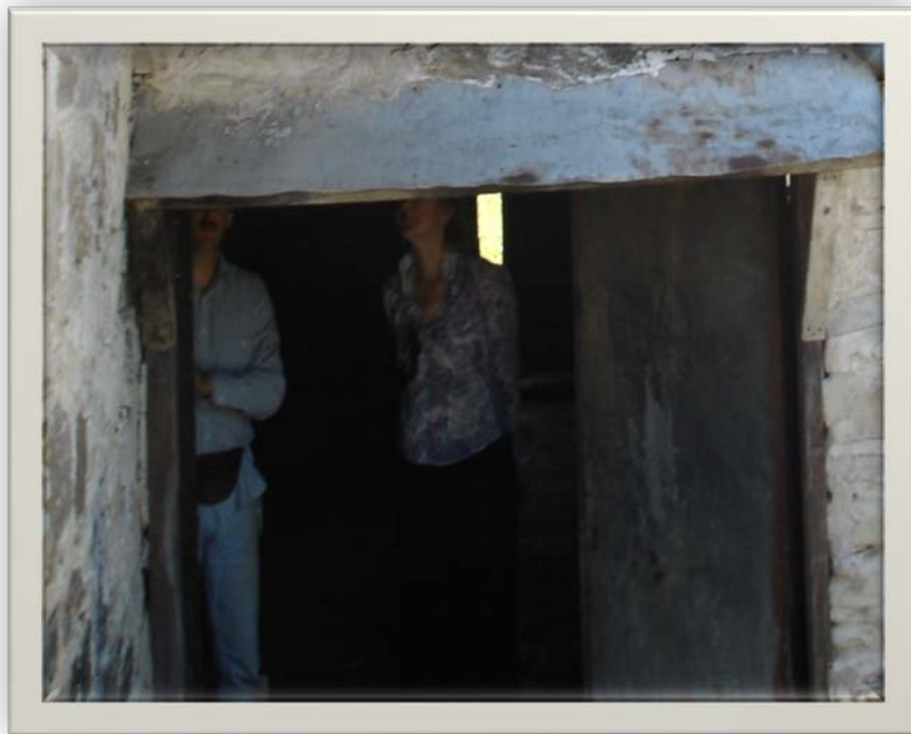
Εικόνα 18 ΜΕΤΑΛΛΙΚΗ ΕΞΩΘΥΡΑ ΒΟΡΕΙΑ ΤΟΥ ΚΤΙΡΙΟΥ ΣΤΟ ΙΣΟΓΕΙΟ
