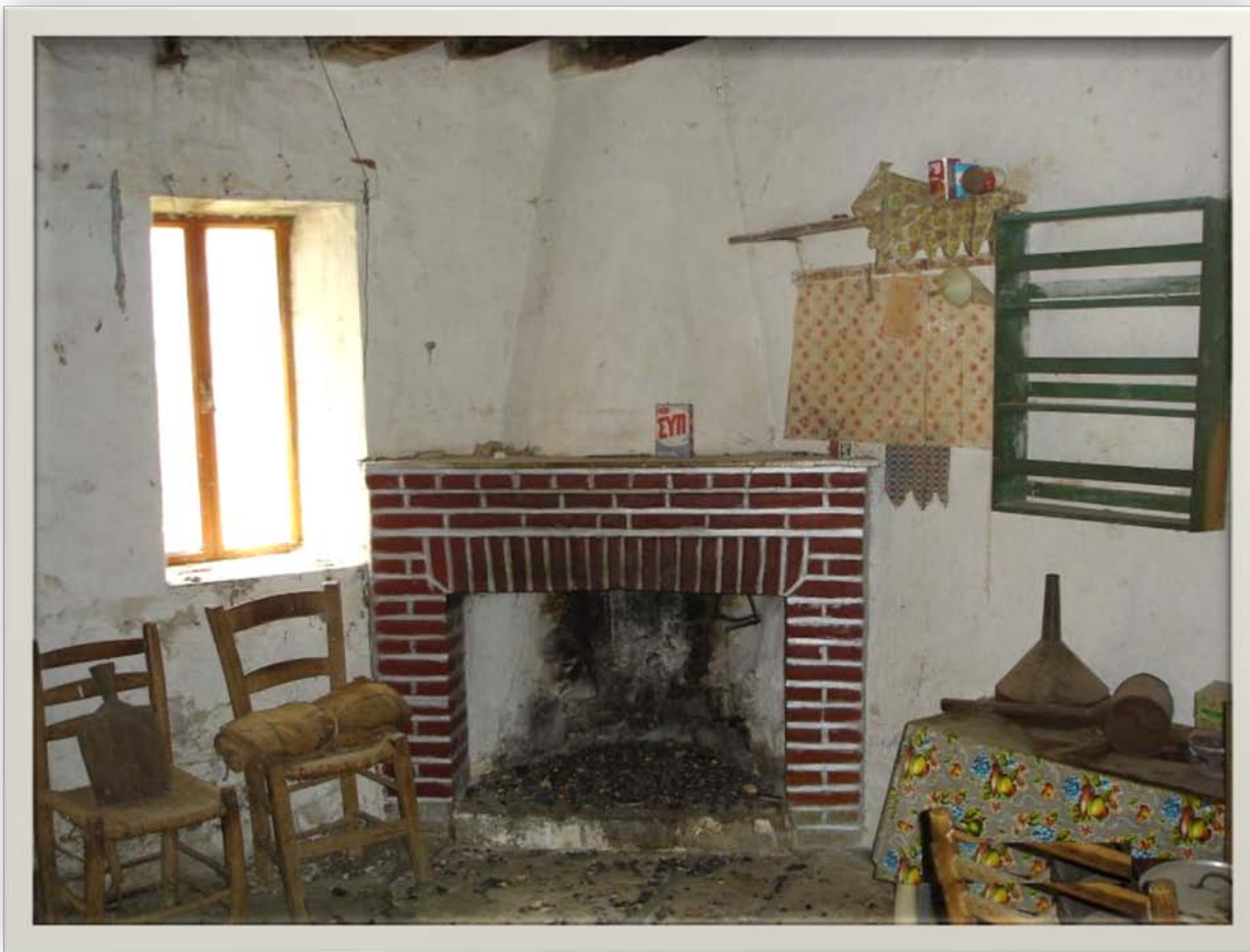
Εικόνα 30 ΑΡΙΣΤΕΡΑ ΤΗΣ ΚΕΝΤΡΙΚΗΣ ΕΙΣΟΔΟΥ ΤΟ ΤΖΑΚΙ ΜΕ ΕΠΕΝΔΥΣΗ ΑΠΟ ΤΟΥΒΛΑΚΙ
