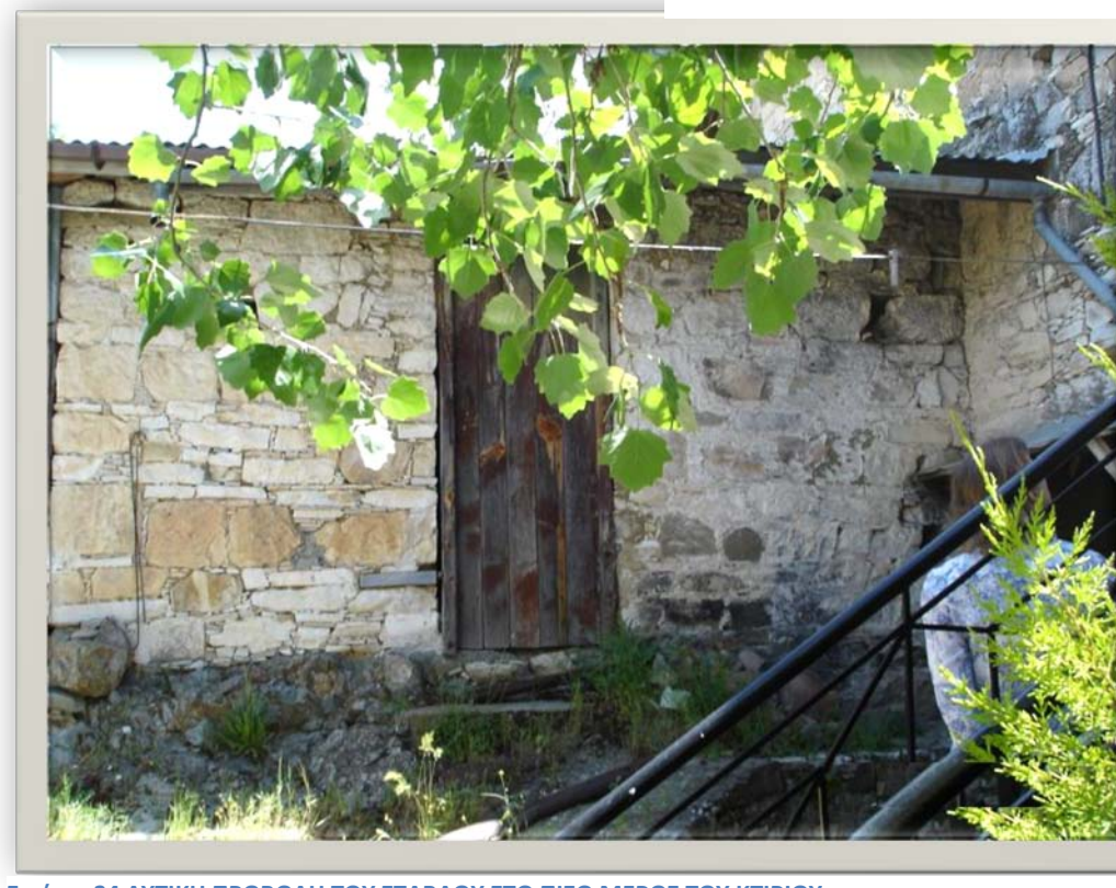
Εικόνα 34 ΔΥΤΙΚΗ ΠΡΟΒΟΛΗ ΤΟΥ ΣΤΑΒΛΟΥ ΣΤΟ ΠΙΣΩ ΜΕΡΟΣ ΤΟΥ ΚΤΙΡΙΟΥ
