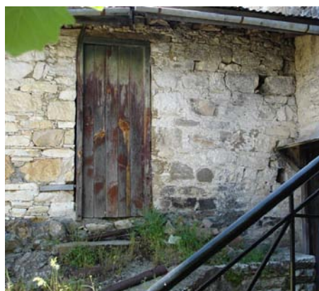
Εικόνα 33 Εξωτερική θύρα στάβλου στην βόρεια πλευρά
