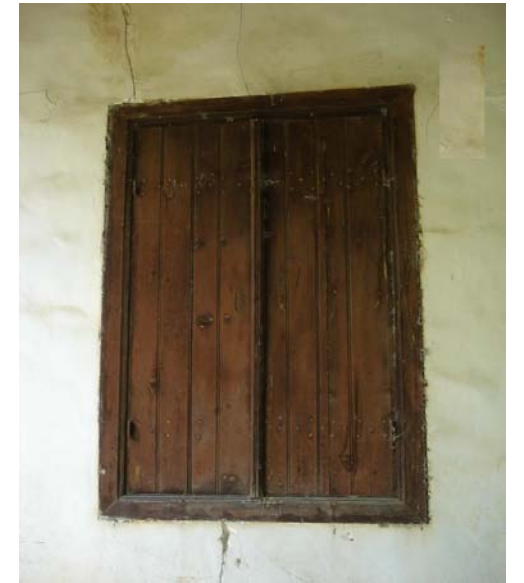
Εικόνα 78 εξωτερικό δίφυλλο σανιδωτό παράθυρο με μεταλλικούς μεντεσέδες
