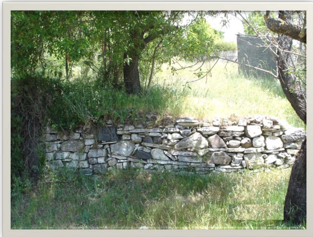
Εικόνα 61 ΛΗΨΗ ΤΗΣ ΞΗΡΟΛΙΘΟΔΟΜΗΣ ΔΕΞΙΑ ΤΗΣ ΠΡΟΣΩΨΗΣ ΤΟΥ ΚΤΙΡΙΟΥ
