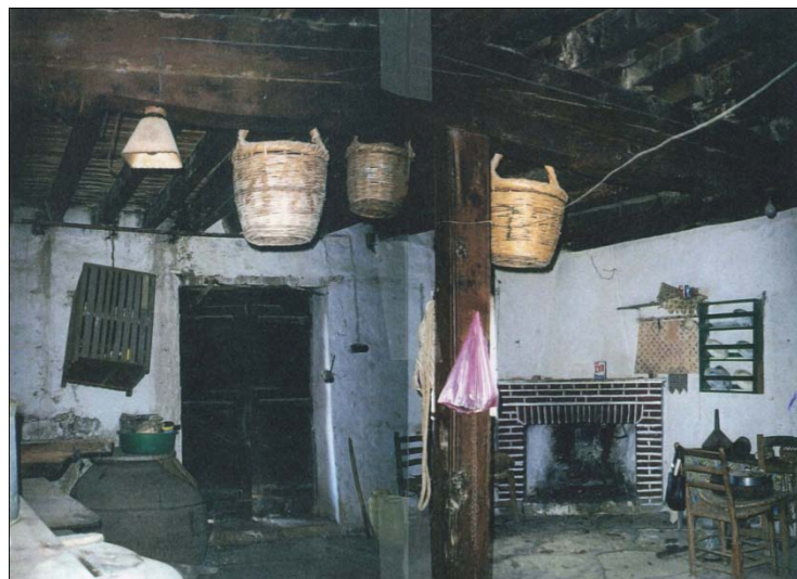
Εικόνα 100 οριζόντιοι φορείς βολίτζια στο διαχωρισμό ισόγειου - ορόφου
