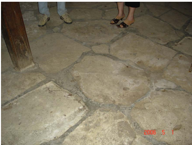
Εικόνα 23 δάπεδο ισόγειου από ασβεστολιθικές πέτρες
