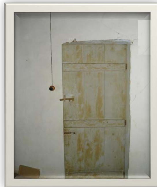
Εικόνα 42 ΕΣΩΤΕΡΙΚΗ ΛΗΨΗ ΘΥΡΑΣ ΑΠΟ ΤΟ ΔΩΜΑΤΙΟ
