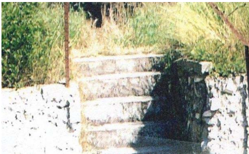
Εικόνα 107 σκάλα στην περίφραξη του κτιρίου
