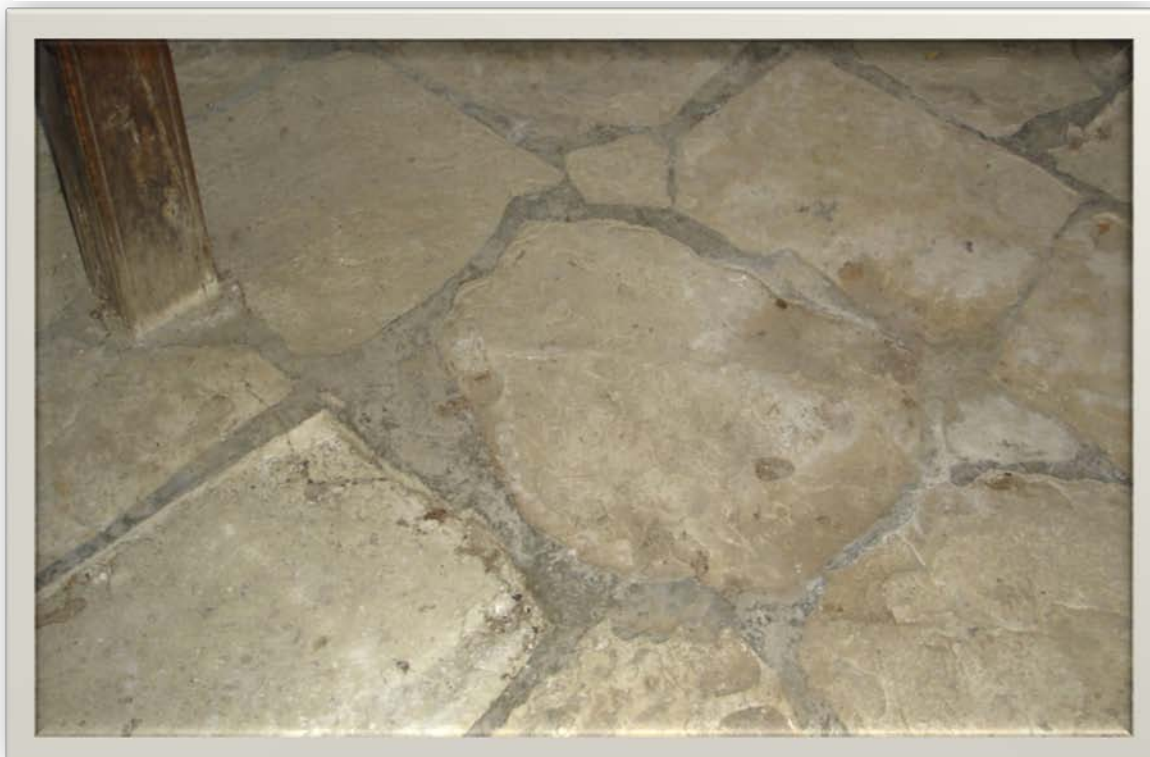
Εικόνα 23 ΠΛΑΚΩΣΤΡΩΤΟ ΜΕ ΜΕΓΑΛΕΣ ΣΕ ΜΕΓΕΘΟΣ ΠΛΑΚΕΣ ΚΑΙ Η ΑΡΜΟΛΟΓΗΣΗ ΤΟΥΣ
