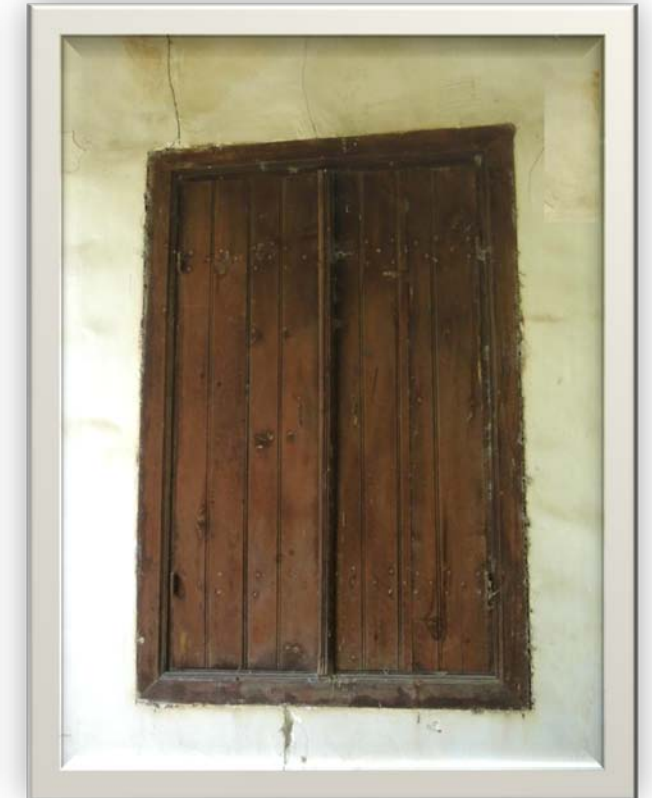
Εικόνα 13 ΕΞΩΤΕΡΙΚΟ ΠΑΡΑΘΥΡΟ ΔΙΠΛΑ ΑΠΟ ΕΙΣΟΔΟ ΣΤΗΝ ΣΑΛΟΤΡΑΠΕΖΑΡΙΑ ΣΤΟΝ ΟΡΟΦΟ
