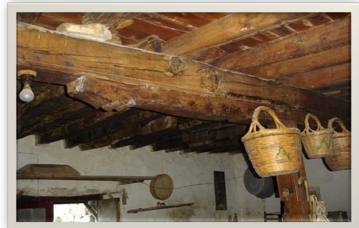
Εικόνα 7 ΤΟ ΣΚΑΛΙΣΜΑ ΤΟΥ ΔΟΚΑΡΙΟΥ ΚΑΙ Η ΤΟΠΟΘΕΤΗΣΗ ΤΟΥ ΣΤΟ ΚΑΤΩ ΜΕΡΟΣ ΤΟΥ ΔΟΚΟΥ
