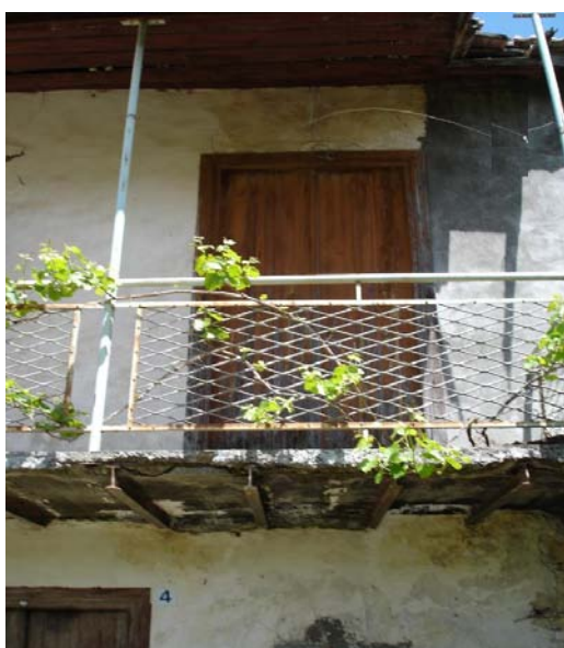
Εικόνα 8 κιγκλίδωμα εξώστη στον όροφο
