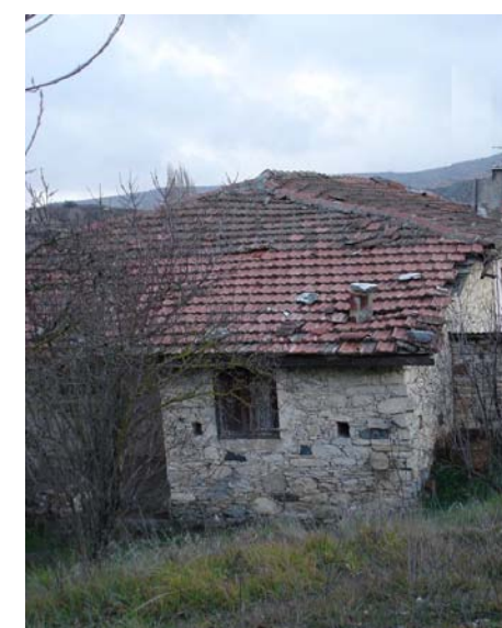
Εικόνα 90 προβολή της στέγης και της μεταγενέστερης επέκτασης
