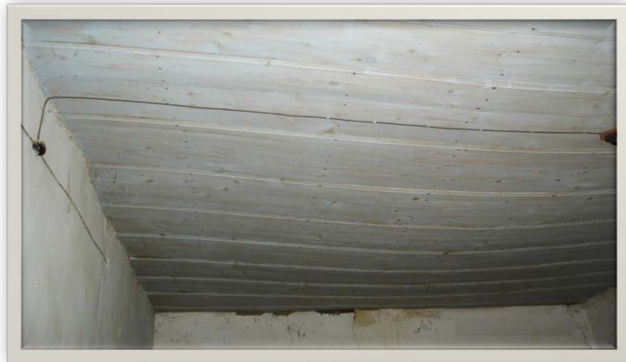
Εικόνα 54 ΠΡΟΒΟΛΗ ΤΟΥ ΔΩΜΑΤΙΟΥ ΣΤΟ ΒΟΡΕΙΟ ΜΕΡΟΣ ΤΟΥ ΚΤΙΡΙΟΥ
