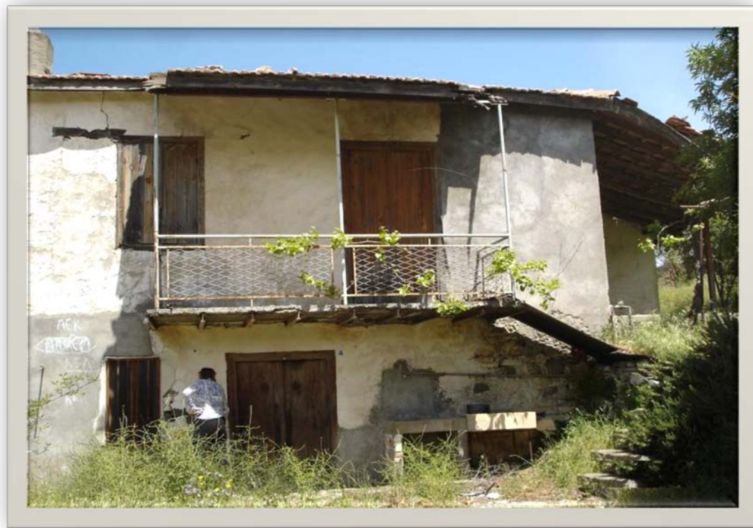
Εικόνα 5 ΝΟΤΙΟΑΝΑΤΟΛΙΚΗ ΟΨΗ ΚΤΙΡΙΟΥ -ΠΡΟΣΩΨΗ
