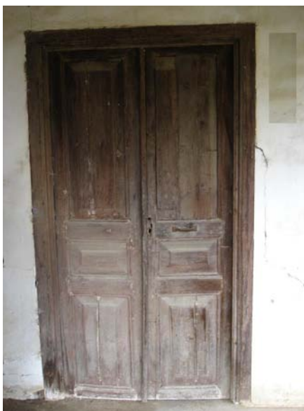
Εικόνα 76 Δίφυλλη εξωτερική ταμπλαδωτή θύρα στον όροφο
