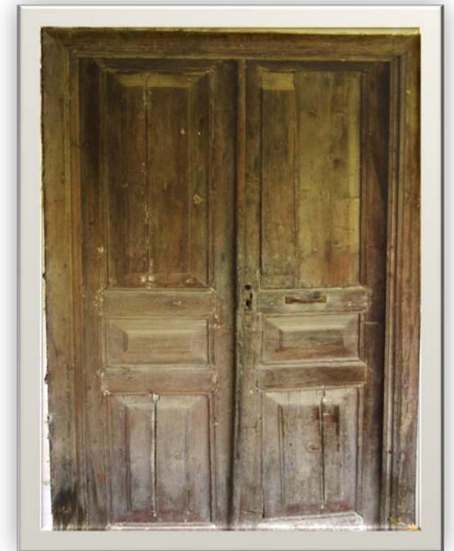
Εικόνα 47 ΘΥΡΑ ΕΞΩΤΕΡΙΚΗ ΤΑΜΠΛΑΔΩΤΗ ΣΤΗΝ ΕΙΣΟΔΟ ΤΗΣ ΚΟΥΖΙΝΑΣ
