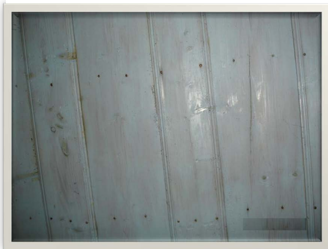
Εικόνα 57 ΛΗΨΗ ΤΗΣ ΑΝΩΨΗΣ ΟΡΟΦΗΣ ΣΤΟ ΔΩΜΑΤΙΟ
