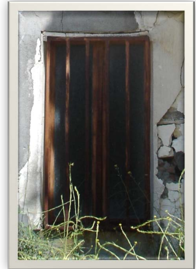
Εικόνα 105 ΠΡΟΒΟΛΗ ΕΞΩΤΕΡΙΚΗΣ ΜΕΤΑΛΛΙΚΗΣ ΓΡΑΔΕΛΛΑΣ ΣΤΟ ΠΑΡΑΘΥΡΟ ΤΗΣ ΕΙΣΟΔΟΥ
