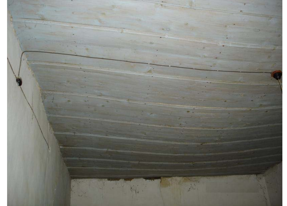
Εικόνα 54 προβολή του δωματίου στο βόρειο μέρος του κτιρίου
