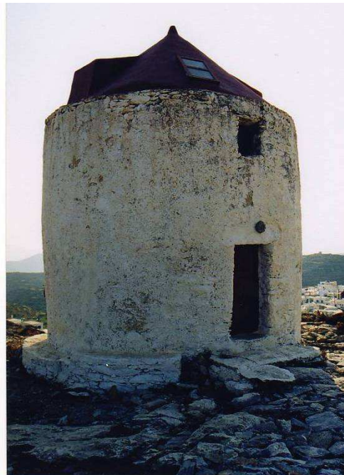
εικ.46. Θεμελίωση με εξωτερική περιφερειακή Αμοργός-Χώρα (Πηγή: προσωπική συλλογή)
