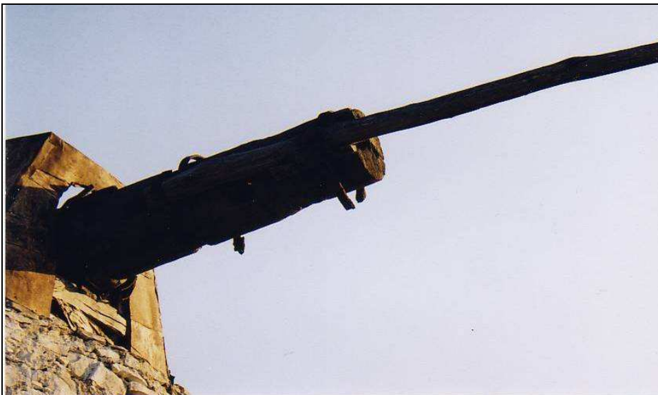
εικ.70. Αξόνι με μονό κούδουνα-Αμοργός, Χώρα (Πηγή: προσωπική συλλογή)
