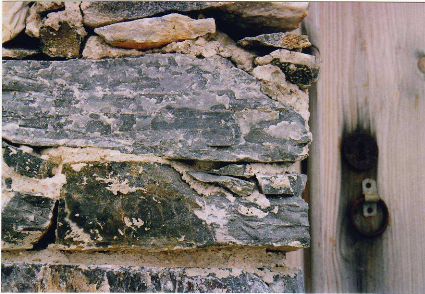
εικ.48. Τοιχοποιία από αφορμάριστες πέτρες –Αιγιάλη (Πηγή: προσωπική συλλογή)
