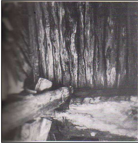
εικ.38. Δοκάρια που εδράζονται σε βορδονάρι (Πηγή: Ο ανεμόμυλος στις Κυκλάδες)
