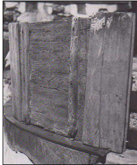
εικ. 101. Καδέρνα, κλειδιά και φάρκες (Πηγή: Ο ανεμόμυλος στις Κυκλάδες)
