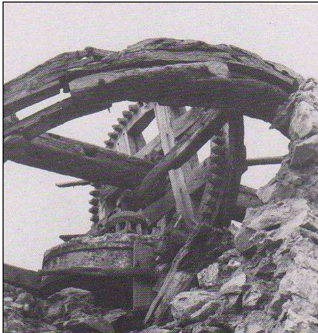
εικ.107. Τα δαχτυλίδια όπως φαίνονται από το εσωτερικό (Πηγή: Ο ανεμόμυλος στις Κυκλάδες)
