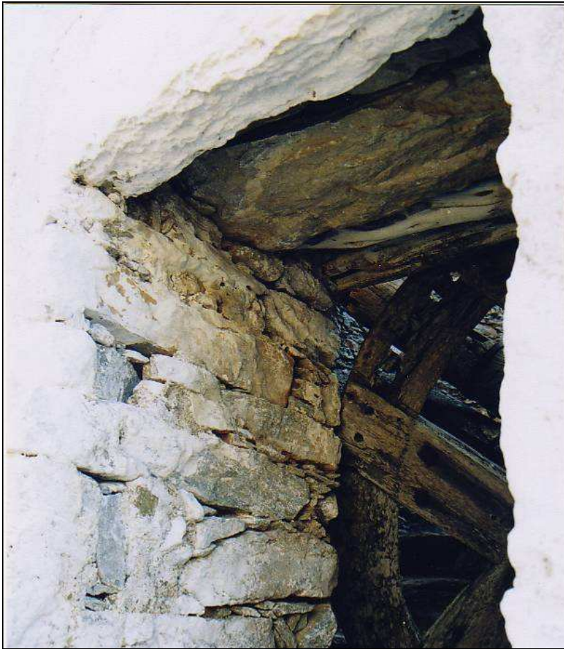
εικ.50. Οριζόντιο πρέκιασμα-μικτή κατασκευή-Αμοργός, Χώρα (Πηγή: προσωπική συλλογή)
