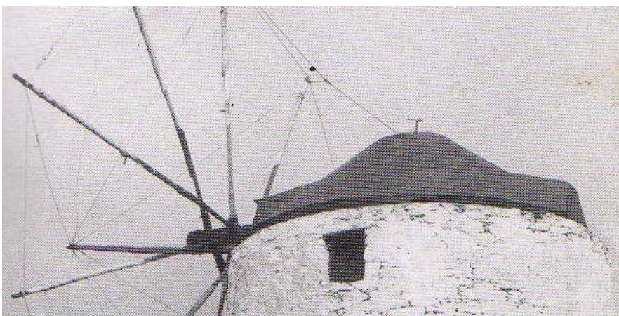
εικ.65. Χαμηλή επενδυμένη ξύλινη τρούλα, κωνική, με καμπύλη απόληξη (Αμοργός-Χώρα) (Πηγή: Ο ανεμόμυλος στις Κυκλάδες)
