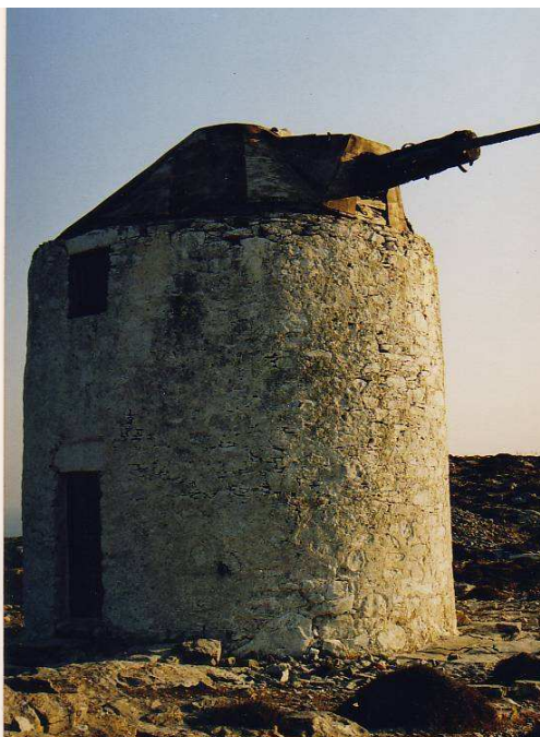
εικ.114. Τρούλα και αξόνι που διατηρούνται σε κακή κατάσταση. (Πηγή: προσωπική συλλογή)
