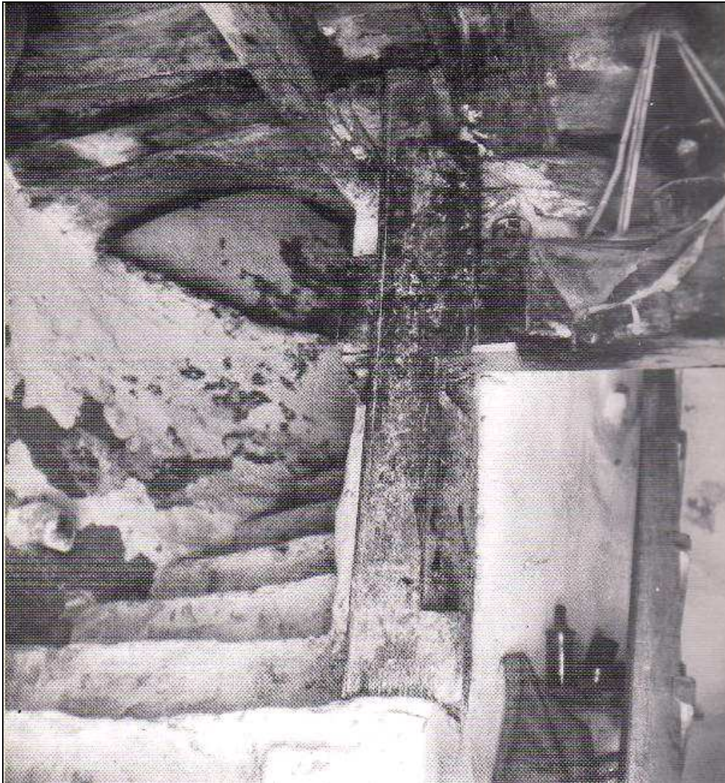
εικ.37. Η κατασκευή και η στήριξη του ξύλινου διαχωρισμού των ορόφων (Πηγή: Ο ανεμόμυλος στις Κυκλάδες)
