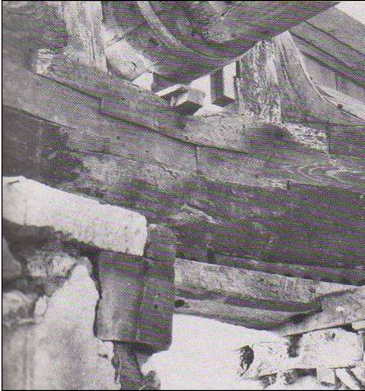
εικ.107. Τα δαχτυλίδια όπως φαίνονται από το εσωτερικό (Πηγή: Ο ανεμόμυλος στις Κυκλάδες)
