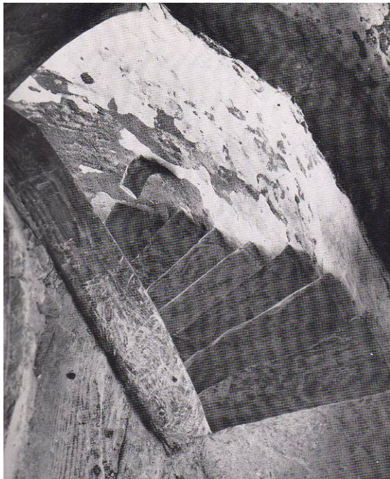
εικ.40. Κλαβανή. Δεξιά η πατούρα που εδράζονται τα δοκάρια. (Πηγή: Ο ανεμόμυλος στις Κυκλάδες)
