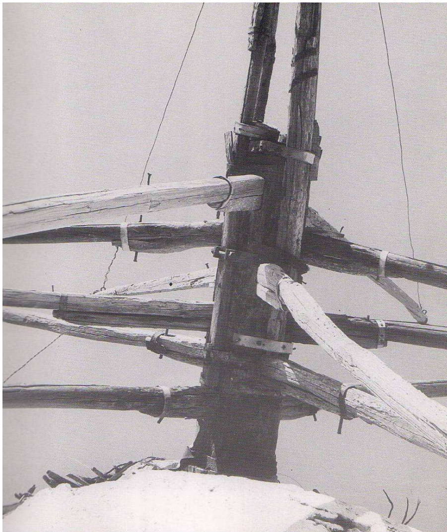
εικ.71. Το στερέωμα των κούδουνων και των αντενών με τις μάνες στο αξόνι (Πηγή: Ο ανεμόμυλος στις Κυκλάδες)
