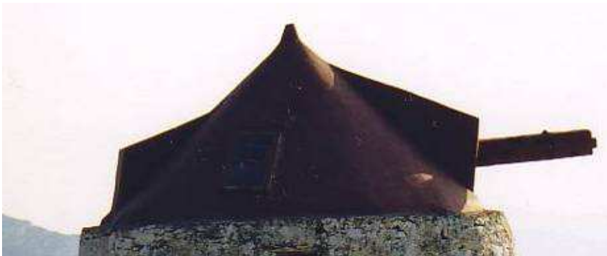
εικ.64 Ξύλινη κωνική τρούλα με υπερυψώσεις για την έδραση του αξονιού και μυτερή απόληξη(Αμοργός-Χώρα) (Πηγή: προσωπική συλλογή)
