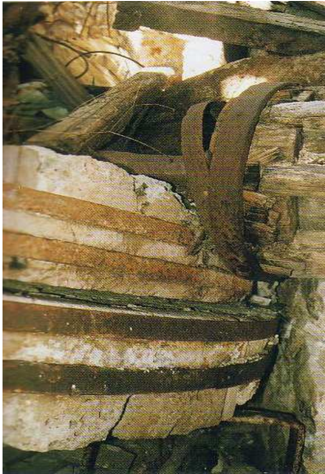
Τμήμα του μηχανισμού μύλου που έχει καταρρεύσει, στην Ιθάκη- μυλόπετρες και ανέμη
