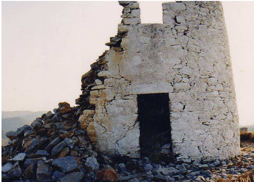
εικ.110.Κατεστραμένη τοιχοποιία μύλου-Χώρα (Πηγή: προσωπική συλλογή)
