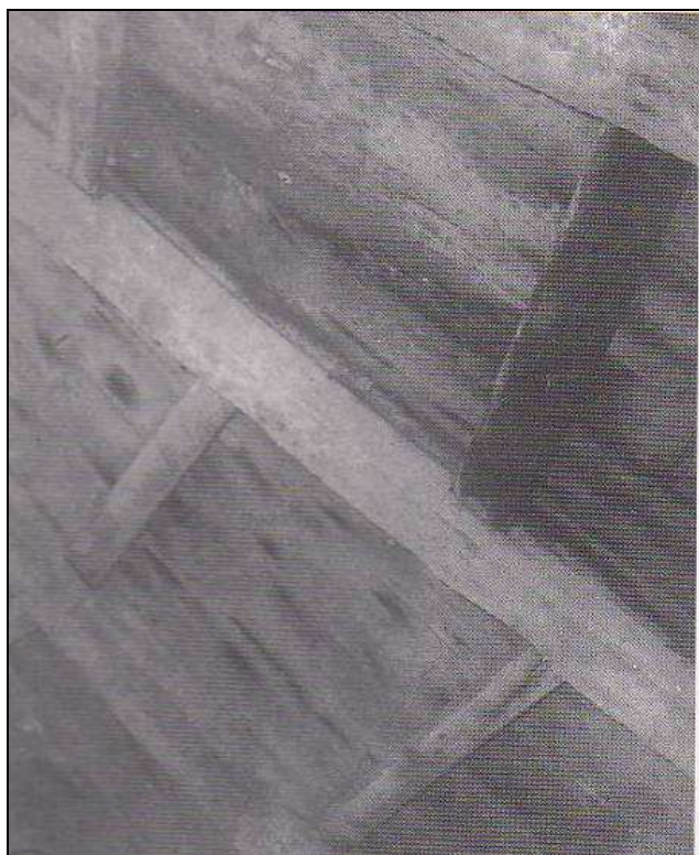
εικ.66. Σκελετός ξύλινης κωνικής τρούλας με οριζόντιες ενισχύσεις(Αμοργός-Χώρα) (Πηγή: Ο ανεμόμυλος στις Κυκλάδες)
