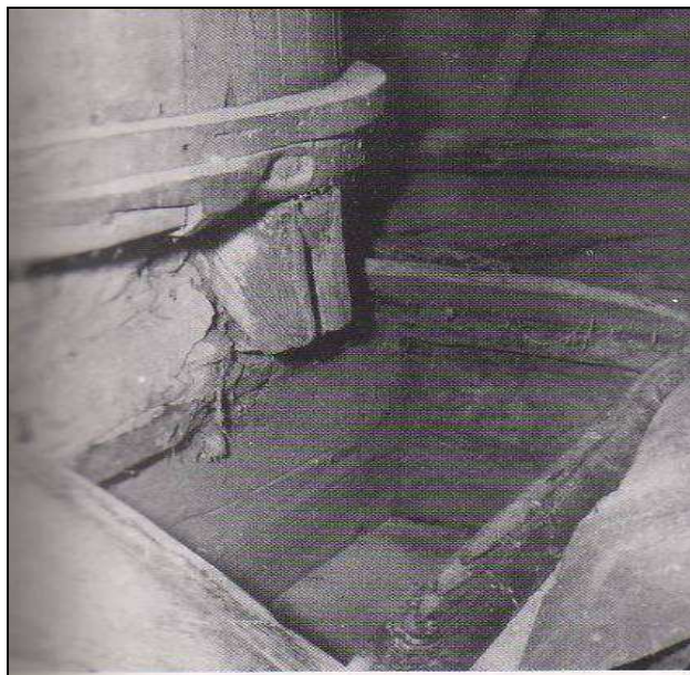
εικ. 103. Η αλευροκασέλα με την έξοδο του αλευριού από πάνω της (Πηγή: Ο ανεμόμυλος στις Κυκλάδες)
