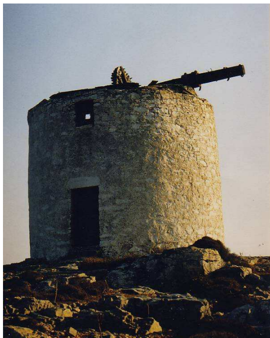
εικ.113. Εκτεθειμένος στις καιρικές συνθήκες μηχανισμός (Πηγή: προσωπική συλλογή)
