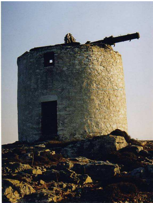
εικ.45. Θεμελίωση σε βραχώδες έδαφος Αμοργός-Χώρα (Πηγή: προσωπική συλλογή)
