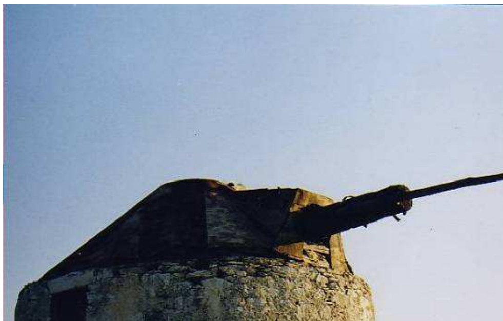
εικ.68. Χαμηλή επενδυμένη ξύλινη τρούλα, κωνική, με καμπύλη απόληξη(Αμοργός-Χώρα) (Πηγή: προσωπική συλλογή)
