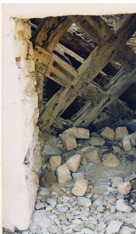
εικ.115,116. Τμήματα μηχανισμών που έχουν καταρρεύσει στο εσωτερικό των μύλων. (Πηγή: προσωπική συλλογή)
