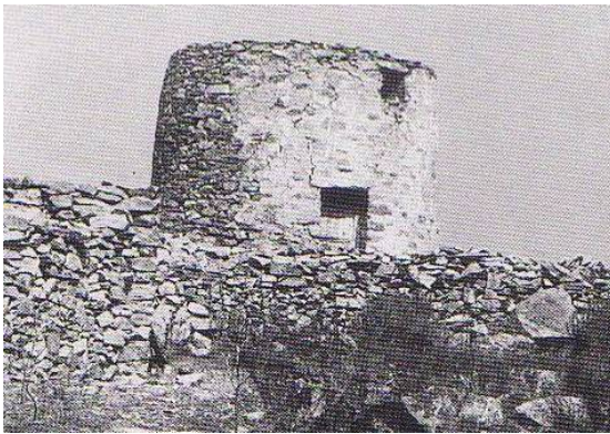
εικ.54. Έκκεντρη τοποθέτηση παραθύρου(Αμοργός-Βρούτσης) (Πηγή: Ο ανεμόμυλος στις Κυκλάδες)
