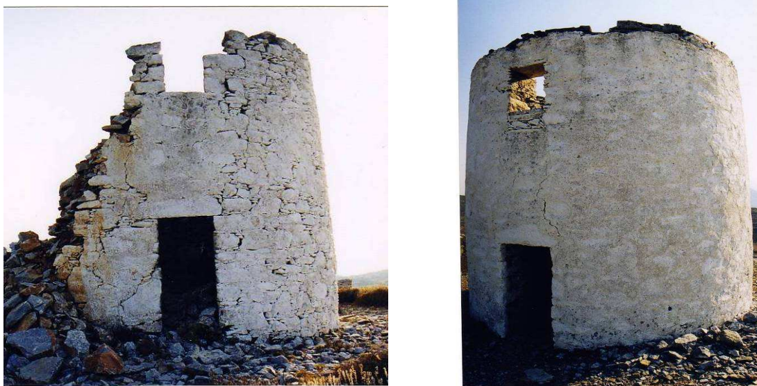
εικ.34,35. Ανεμόμυλοι με κυρτή εξωτερική επιφάνεια στη Χώρα της Αμοργού. (Πηγή: προσωπική συλλογή)
