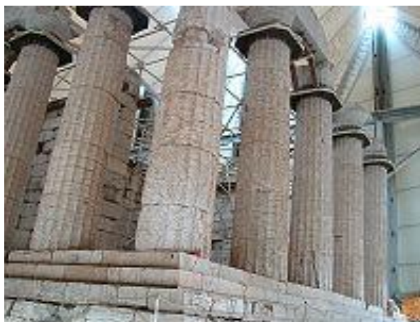
Εικόνα 41 Αποψη της εξωτερικής δωρικής κιονοστοιχίας του ναού
