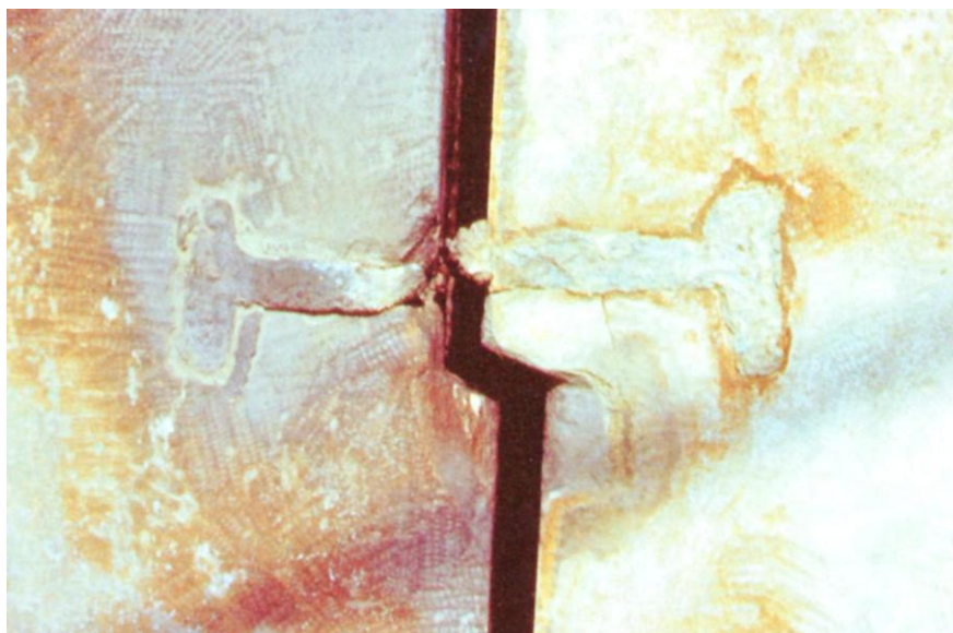
Εικόνα 70 Σύνδεσμος από τον νότιο τοίχο της ανατολικής στοάς των Προπυλαίων. Κατά την παραμόρφωση του τοίχου ο σιδερένιος σύνδεσμος έσπασε με αποτέλεσμα το μάρμαρο να διατηρήσει την ακεραιότητά του.
