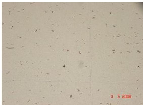
Εικόνα 2 Τεχνητό μάρμαρο τοποθετημένο σε δάπεδο
