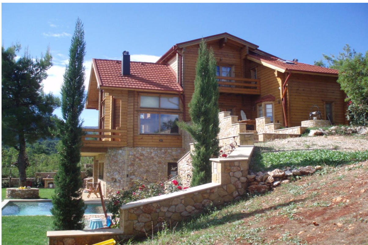
Εικ. 47: Ανατολική όψη υφιστάμενης, γειτονικής κατοικίας.
