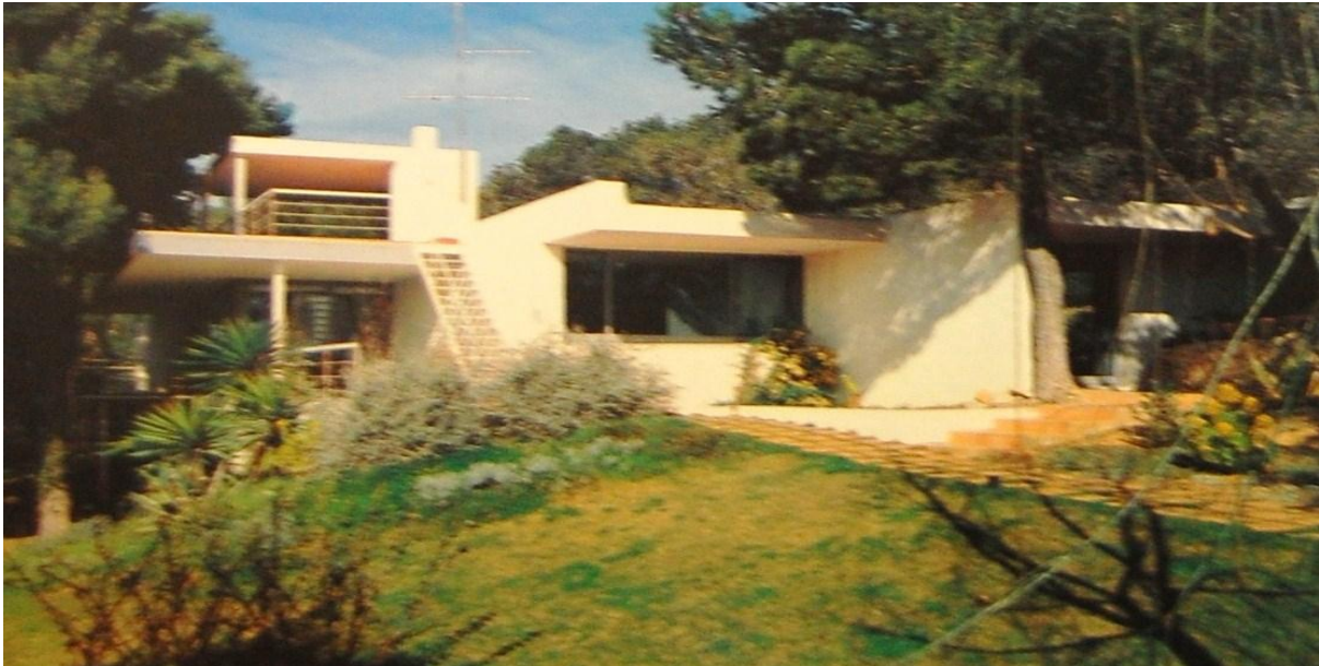
Εικ. 25: Τα βασικά υλικά του εξωτερικού είναι ασβεστοκονίαμα με μαρμαρόσκονη και γκρίζα μεταλλικά κουφώματα.
