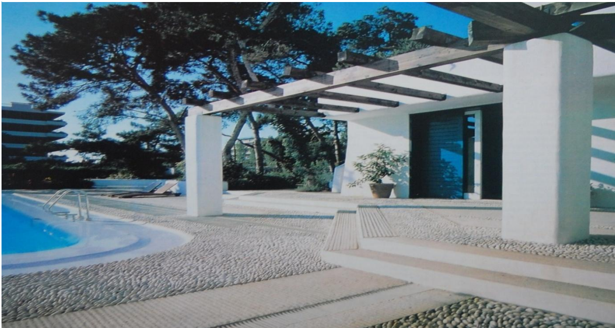
Εικ. 29: Η δαπεδόστρωση έγινε με τσιμέντο και βότσαλα που τοποθετήθηκαν τεχνίτες από τις Σπέτσες, διάλεγμενοι από τον αρχιτέκτονα.
