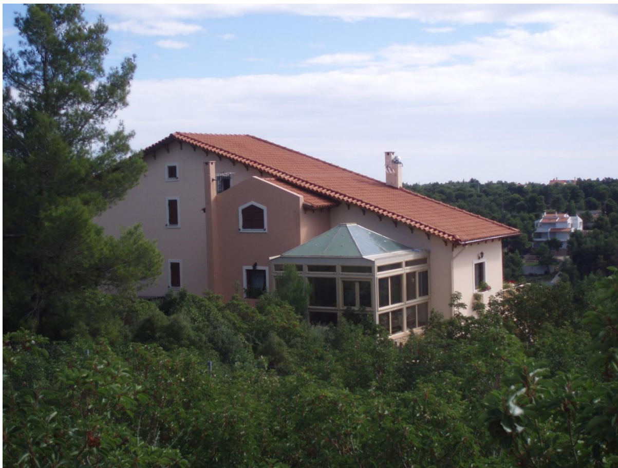
Εικ. 44: Βόρεια όψη υπάρχουσας κατοικίας στο όμορο οικοπέδο.
