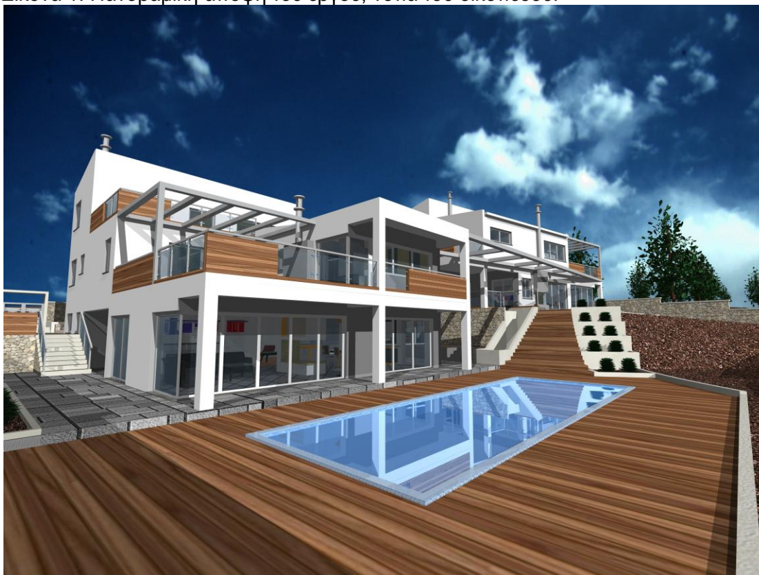
Εικόνα 2: Προοπτική λήψη, νότια του κτιρίου Α΄.
