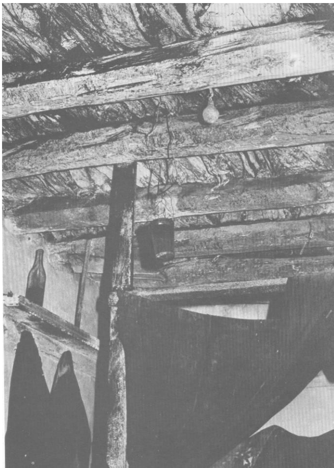
Εικ.19 Ολόκληρος κορμός χρησιμοποιείται για δοκάρια στο μεσοπάτωμα (Το κρητικό σπίτι, Δ. Βασιλειάδης, σελ. 247)
