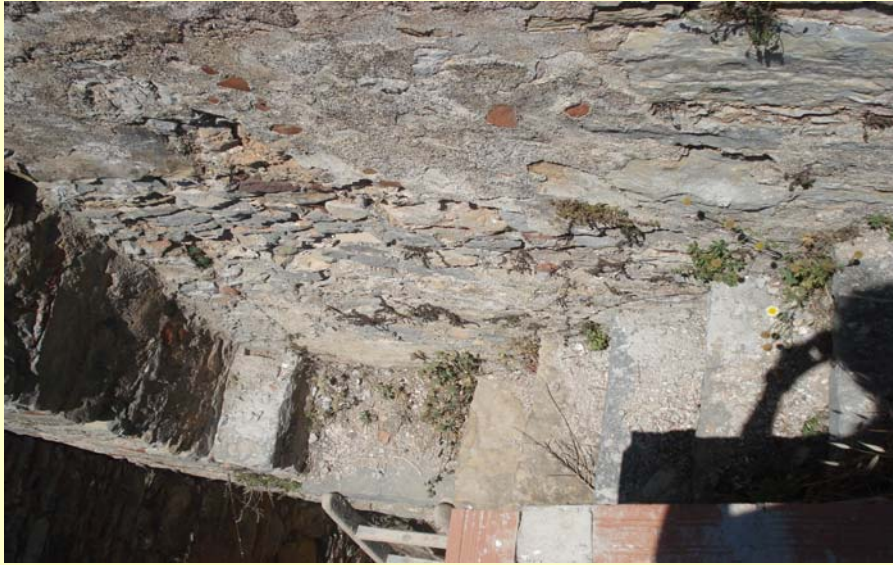
Εικ. 46 : Λίθινη σκάλα στο αίθριο.
