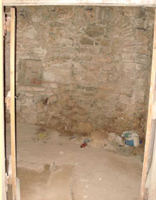
Εικ. 37 : Κλεισμένο άνοιγμα στον βορεινό τοίχο του κατωγιού.
