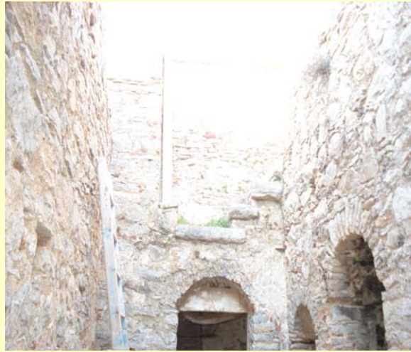
Εικ. 57 : Λίθινη σκάλα στο αίθριο.
