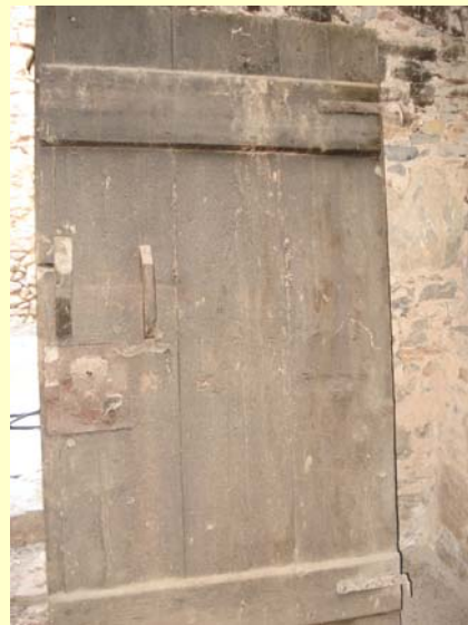
Εικ. 51 : Εσωτερική θύρα στο νοτινό δωμάτιο στο ανάγλι.
