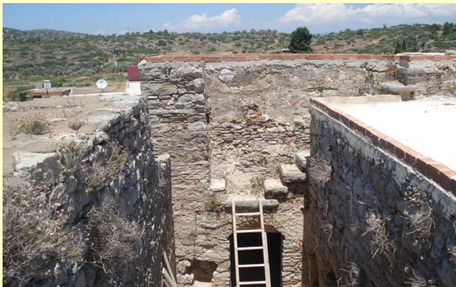
Εικ. 45 : Λίθινη σκάλα στο αίθριο.
