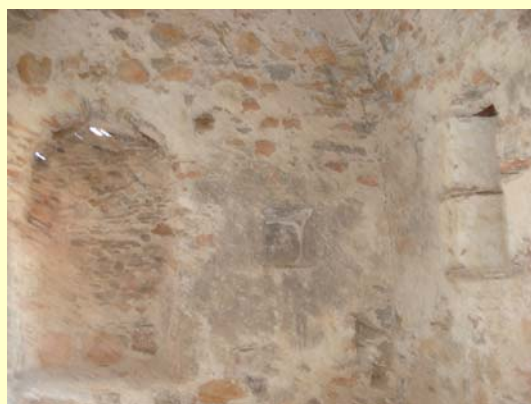
Εικ. 53 : Θυρίδα στο βορεινό δωμάτιο στο ανάγλι.
