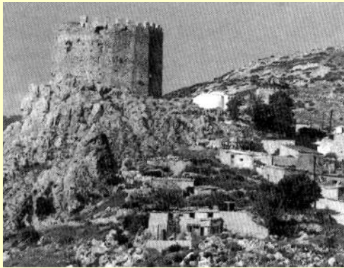
Εικ. 20 : Ο πύργος του Πιτυούς. Πηγή: Ν. Κουλουκάκη και συνεργάτες «Η ιταλική επίδραση στη Χίο», Χίος 2000
