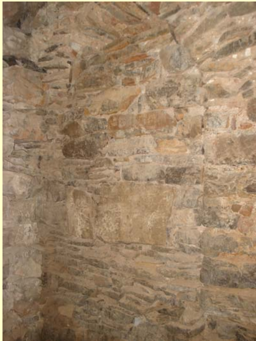
Εικ. 36 : Κλεισμένο άνοιγμα στον ανατολικό τοίχο του κατωγιού.
