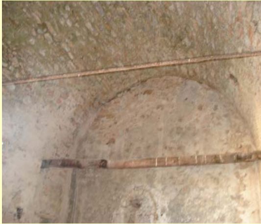
Εικ. 58-59 : Ελκυστήρες και κλειδιά στην βόρεια όψη του κτιρίου.
