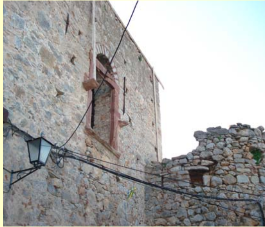
Εικ. 58-59 : Ελκυστήρες και κλειδιά στην βόρεια όψη του κτιρίου.
