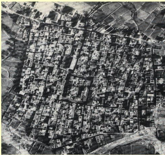
Εικ. 1 : Αεροφωτογραφία του χωριού Καλαμωτή, του 1934.. Πηγή : Χ. Μπούρας, «Ελληνική Παραδοσιακή Αρχιτεκτονική», Αθήνα 1992.
