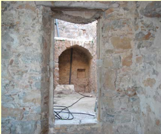
Εικ. 50 : Εσωτερική θύρα στο βορεινό δωμάτιο στο ανάγλι.
