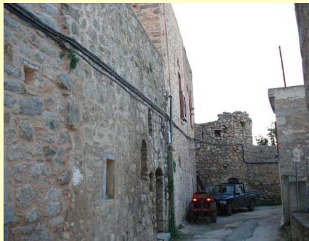
Εικ. 34 : Βόρεια όψη
