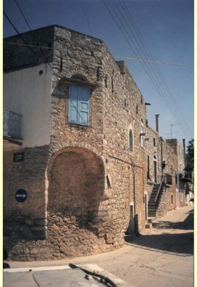
Εικ. 18 : Ο πύργος του δυτικού τριγωνικού τμήματος των Μεστών (πύργος του Μιλιά) Πηγή: Ιδία επεξεργασία.
