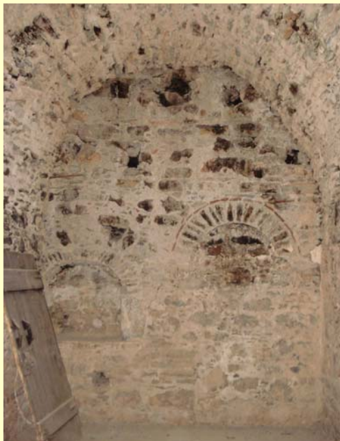
Εικ. 38 : Κλεισμένο άνοιγμα στον βορεινό τοίχο της κουζίνας στο άνωγι.
