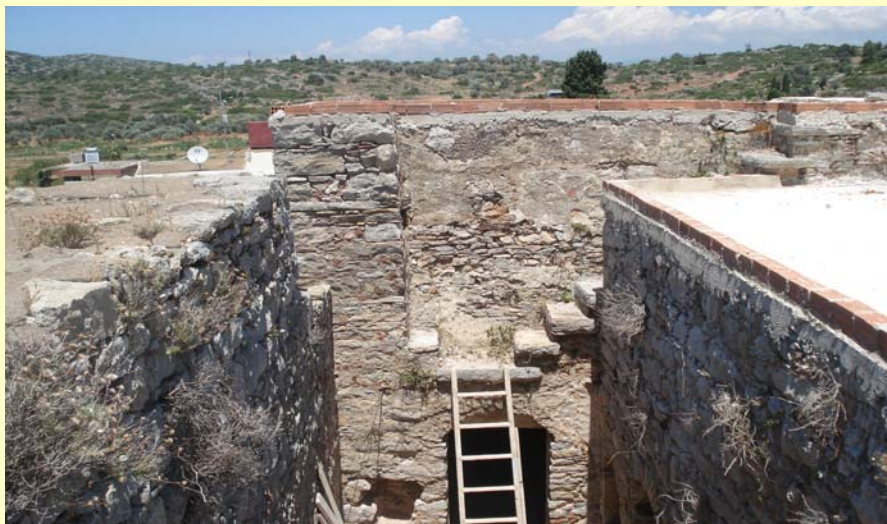
Εικ. 45 : Λίθινη σκάλα στο αίθριο.
