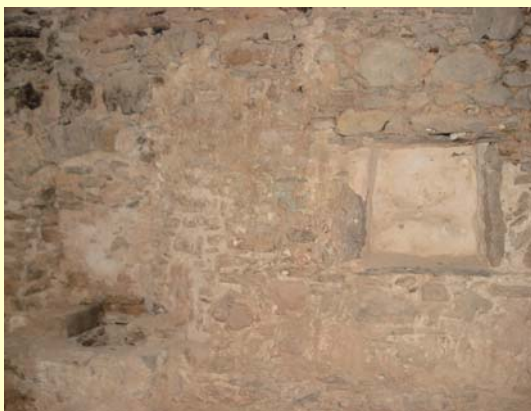
Εικ. 52 : Θυρίδα στο νοτινό δωμάτιο στο ανάγλι.
