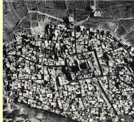
Εικ. 2 : Αεροφωτογραφία του χωριού Πυργί, του 1934.. Πηγή : Χ. Μπούρας, «Ελληνική Παραδοσιακή Αρχιτεκτονική», Αθήνα 1992.
