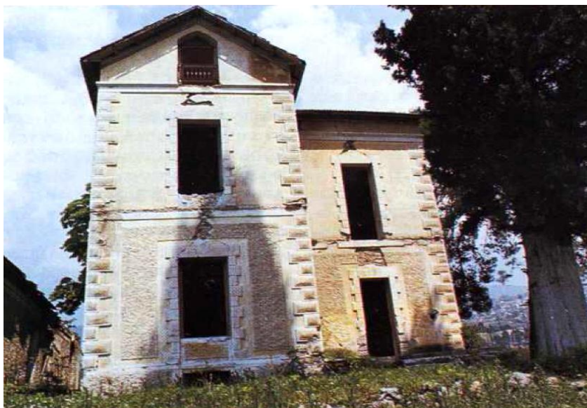
Εικ.9 Βίλα Καρτάλη στον Άγιο Γεώργιο Ιωλκού, κατεδαφίστηκε
