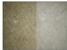
Χώρος 1.0 8(Εκ. 161)Μικροκόκκο δάπεδο
