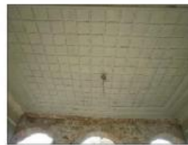
Χώρος 3. 01(Εκ.216) (Οροφή)
