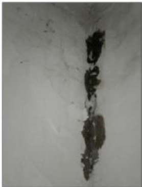
Χώρος 1.0 8(Εκ. 159)Εμφάνιση μικρορραγιών και υγρασίας
