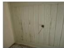
Χώρος 3.07(Εκ. 277 )Οροφή
