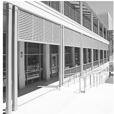
Εικόνα 49: Διάταξη από κάθετες, σταθερές, εξωτερικές περσίδες, κατάλληλες για ανατολικό και δυτικό προσανατολισμό.
