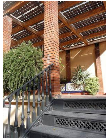
Εικόνα 85: Ενσωματωμένα φωτοβολταϊκά πάνελς στα στέγαστρα βεραντών που δημιουργούν χώρους ευχάριστους και λειτουργικούς, και μπορούν να ενσωματωθούν σε κτίρια, οποιασδήποτε
