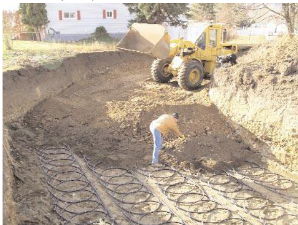
Εικόνα 96: Παράδειγμα εγκαταστάσεις γεωθερμικών αντλιών.
