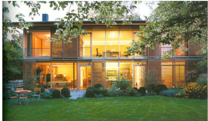
Εικόνα 108: Αποψη της Νότιας όψης της κατοικίας κατά ο σούρουπο με ανοιχτά τα σκίαστρα και τα τζάμια για δροσισμό.
