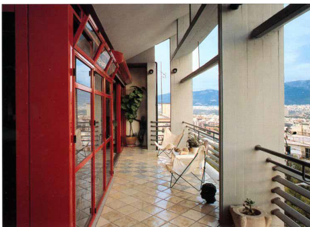
Εικόνα 106: Χρησιμοποιείται διπλό κέλυφος στη Νότια όψη. Το εσωτερικό για τη συλλογή της ηλιακής ενέργειας και το εξωτερικό για το σκίασμό της.
