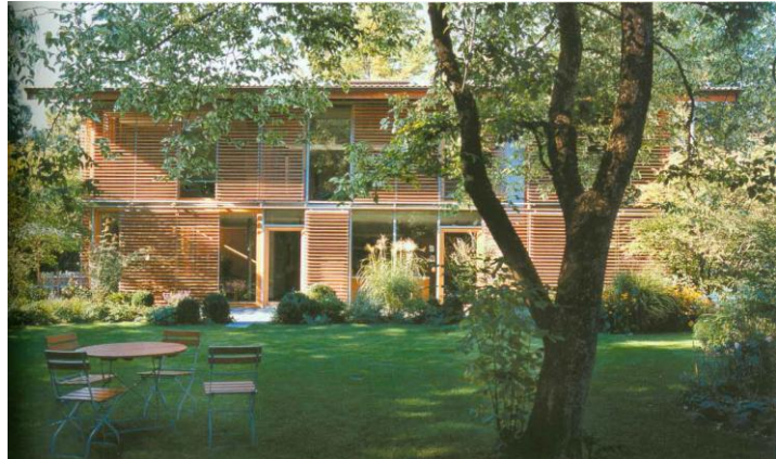
Εικόνα 107: Αποψη της Νότιας όψης της κατοικίας κατά την ημέρα με κλειστά τα σκίαστρα για σκίασμό των γυάλινων επιφανειών.
