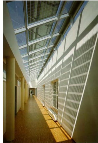
Εικόνα 83: Ενσωματωμένα φωτοβολταϊκά σε γυάλινη στέγη που εκτός από τη παραγωγή ενέργειας χρησιμεύει και για σκίασμό του εσωτερικού χώρου.
