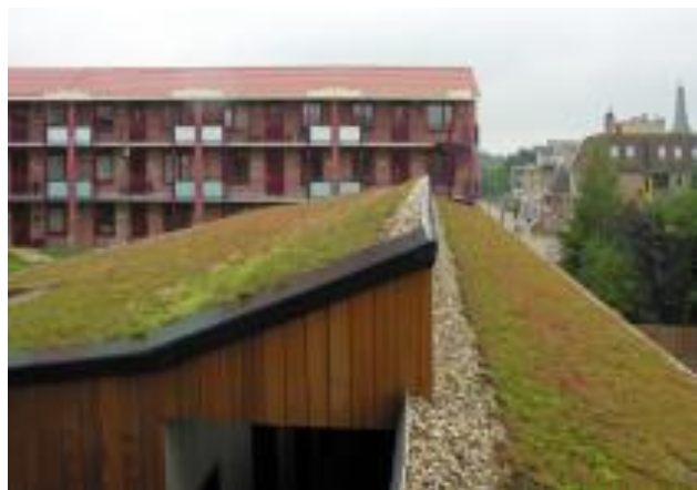
Εικόνα 53: Παράδειγμα εκτατικού τύπου φύτευσης σε επικλινή στέγη.
