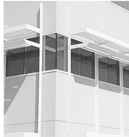
Εικόνα 48: Οριζόντιες εξωτερικές περσίδες, κατάλληλες για νότιο προσανατολισμό. Λειτουργούν αποδοτικά, εκτός από τις γωνίες. Διπλή σειρά περσίδων έχει χρησιμοποιηθεί.
