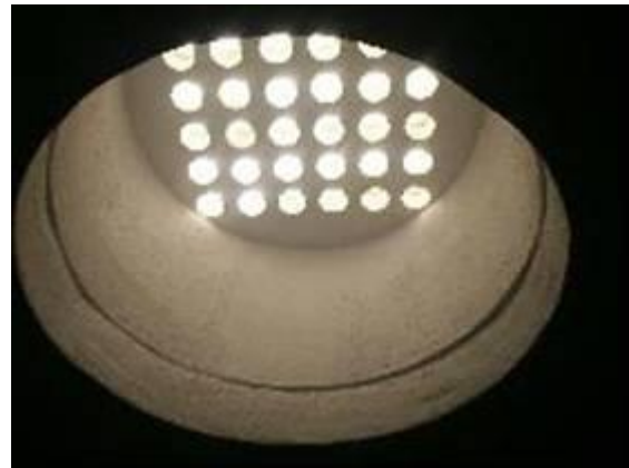
Εικόνα 71: Άνοιγμα οροφής για εσωτερικό φωτισμό.
