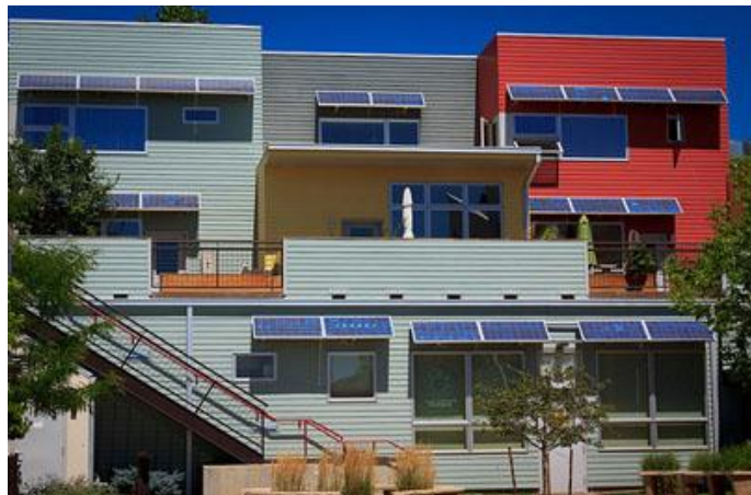
Εικόνα 86: Ενσωματωμένα φωτοβολταϊκά πάνελς στα στέγαστρα πάνω από τα κουφώματα των κτιρίων αποτελούν τον ιδανικό συνδυασμό μορφολογίας και λειτουργικότητας με την ενεργειακή απόδοση.
