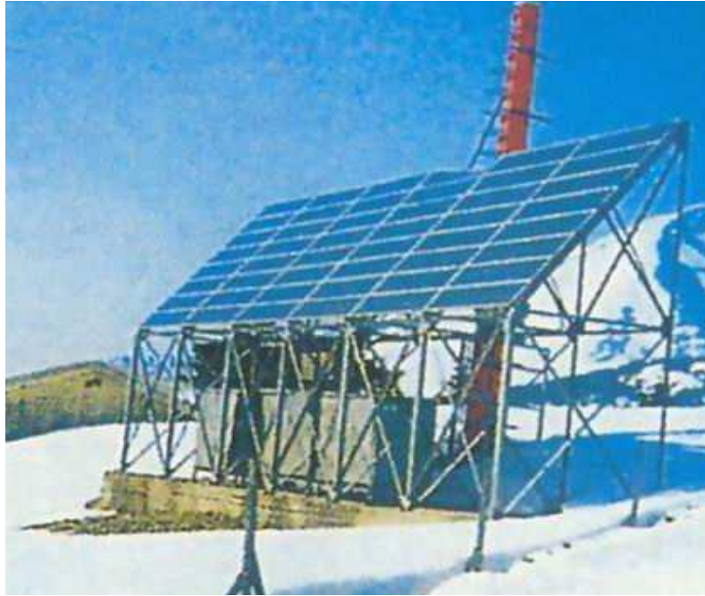
Εικ.2.15 Αυτόνομο φωτοβολταϊκό σύστημα τηλεπικοινωνιών στο όρος Δίρφη στην Εύβοια
