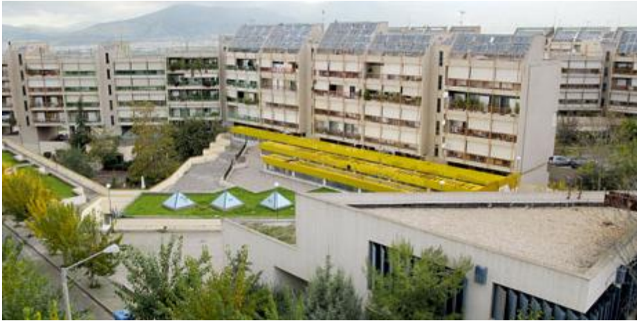
Εικ.2.6 Κτιριακό συγκρότημα με ηλιακούς συλλέκτες
