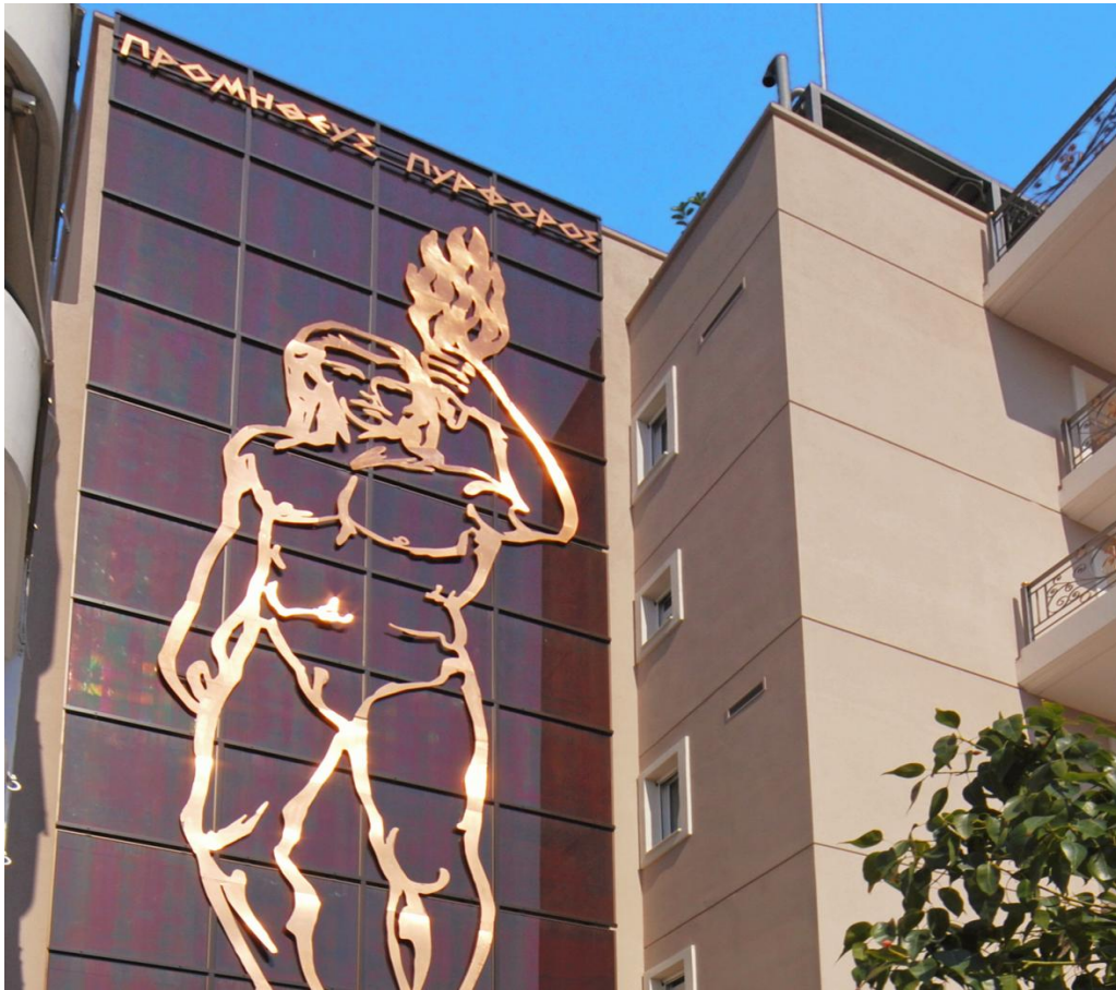
Εικ.4.14 Φωτοβολταϊκά στη πρόσοψη του κτιρίου
