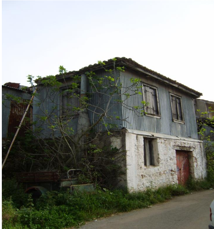
13. Σε αυτό το κτίριο το ισόγειο είναι λιθόκτιστο και ο όροφος είναι από λαμαρίνα.
