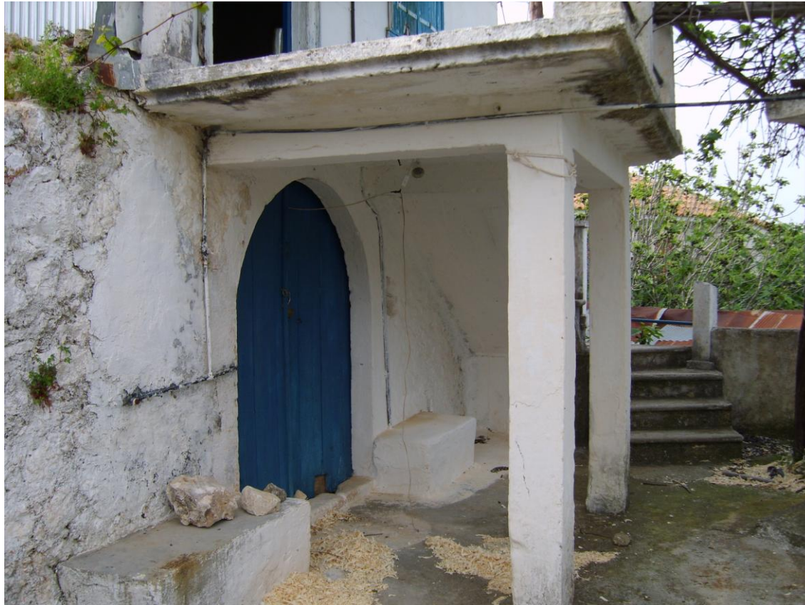
60. Απεικονίζονται συνολικά όλες οι φθορές που έχει ο εξώστης στη πλάκα και στις κολώνες.
