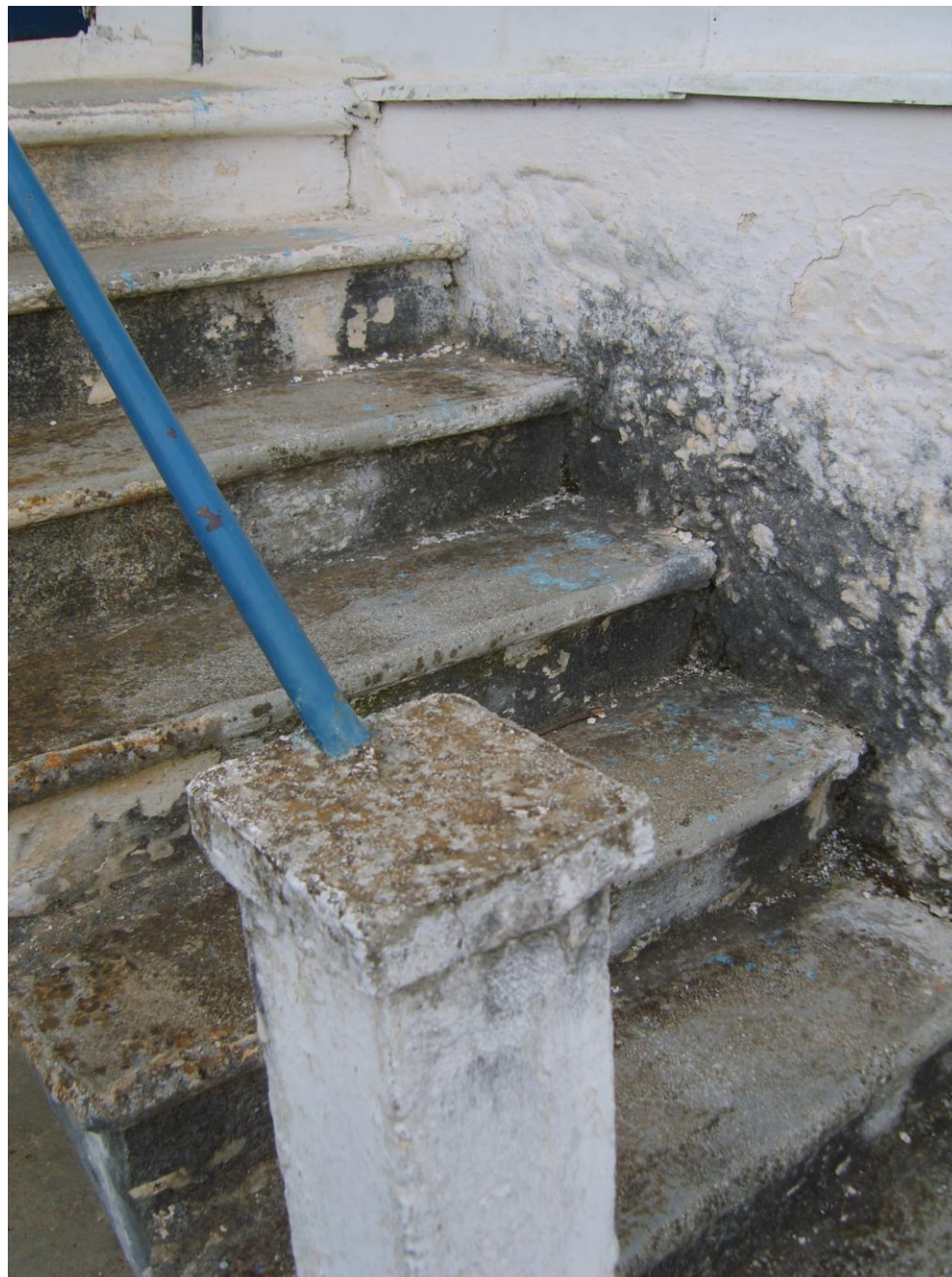
58. Η κλίμακα που έχει διαβρωθεί στις ακμές των σκαλοπατιών.
