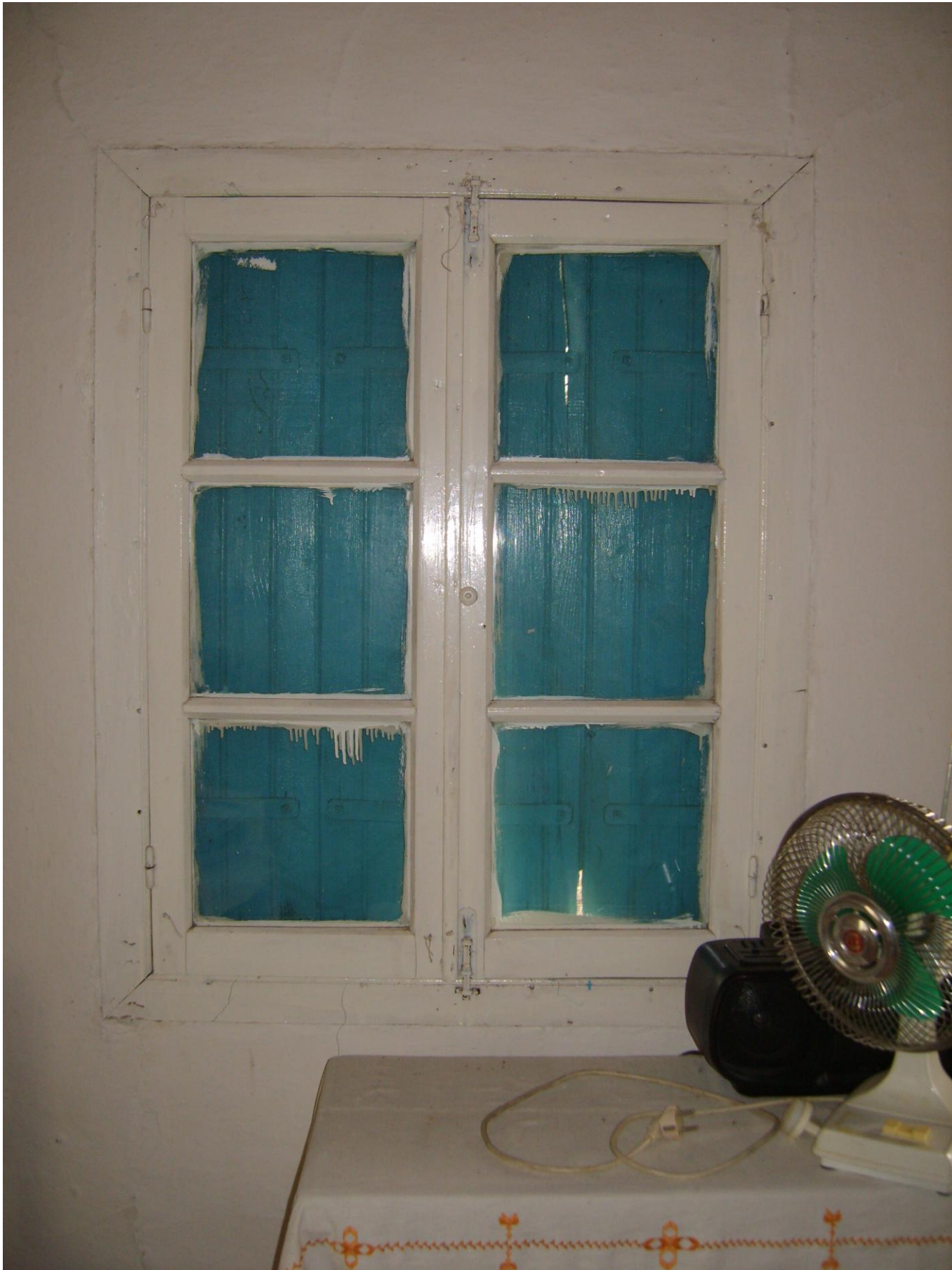
29. Εσωτερική όψη παραθύρου στον όροφο κτίριο 1.
