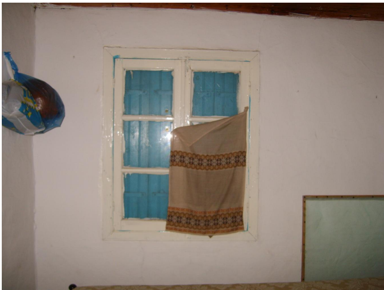
50. Απεικονίζεται η εσωτερική πλευρά του ορόφου που έχει σοβατιστεί.
