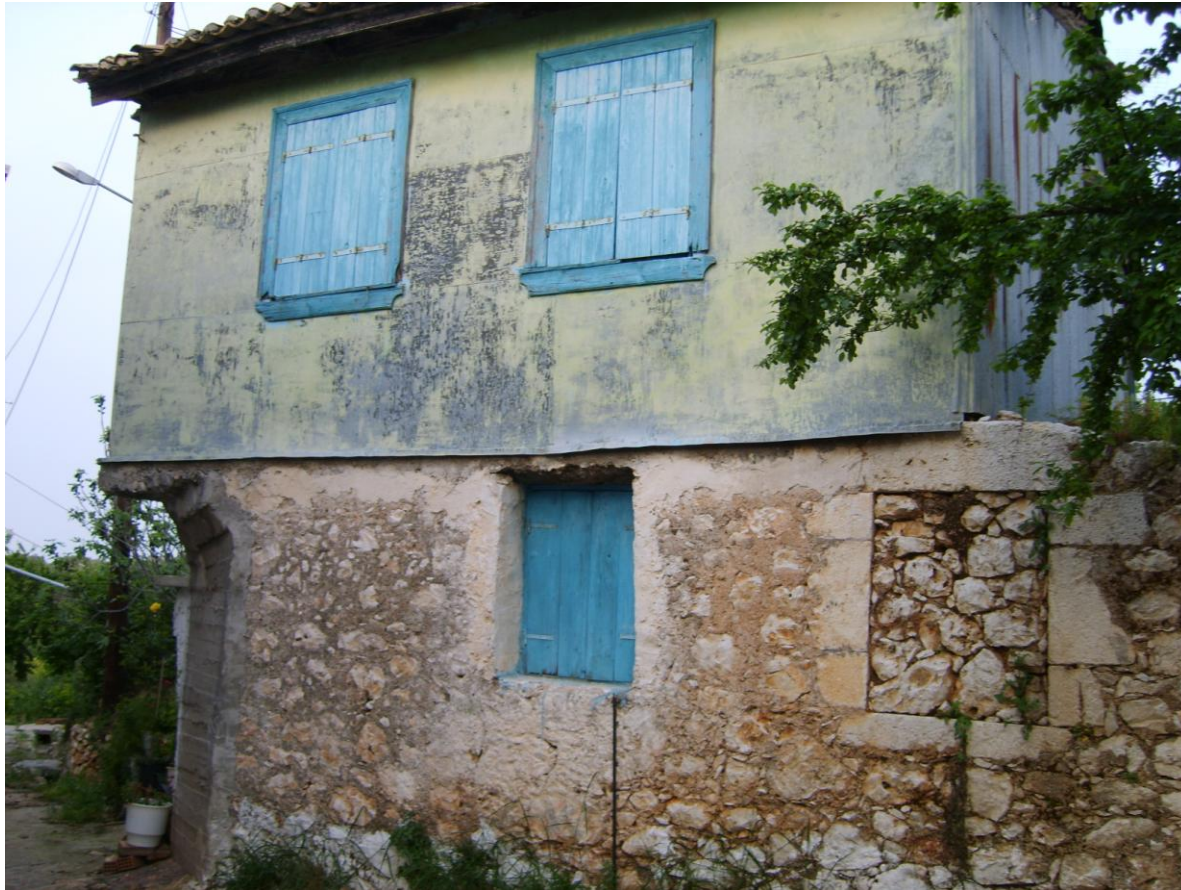
48. Η εξωτερική πλευρά του ορόφου στο κτίριο 1 έχει επενδυθεί με λαμαρίνα.
