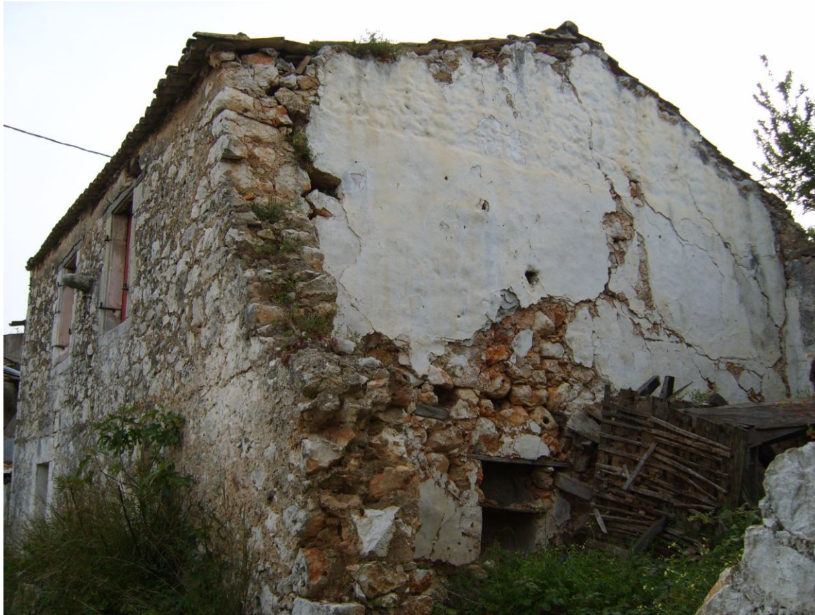
39.Βόρεια όψη κτιρίου 3.
