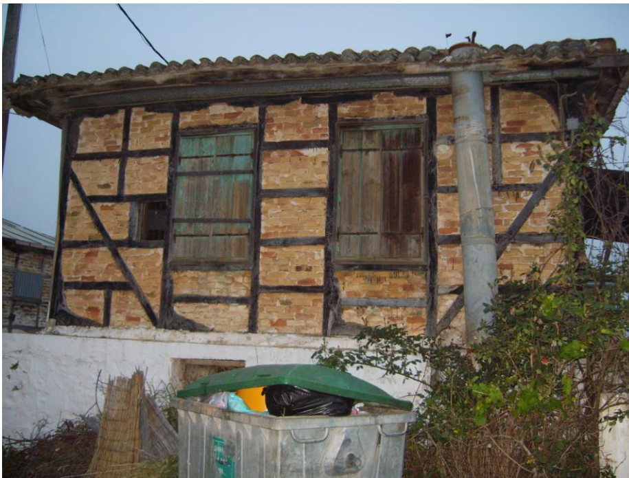
14. Στο κτίριο στον όροφο έχουμε τον τρόπο της ξυλοδεσιάς.
