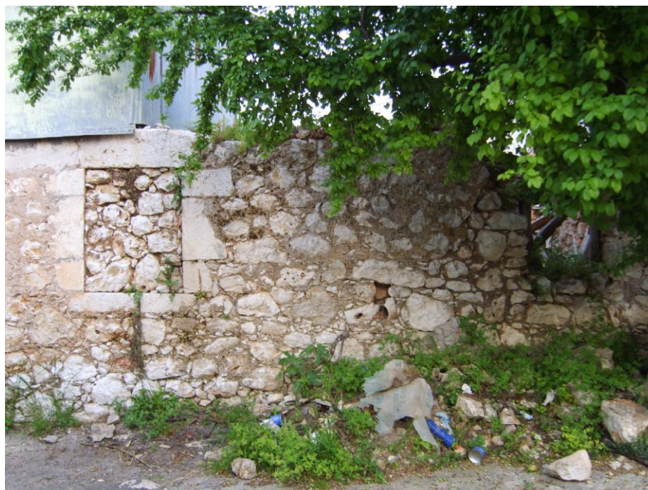
75. Απεικονίζεται η τοιχοποιία στο ισόγειο στη δυτική όψη.
