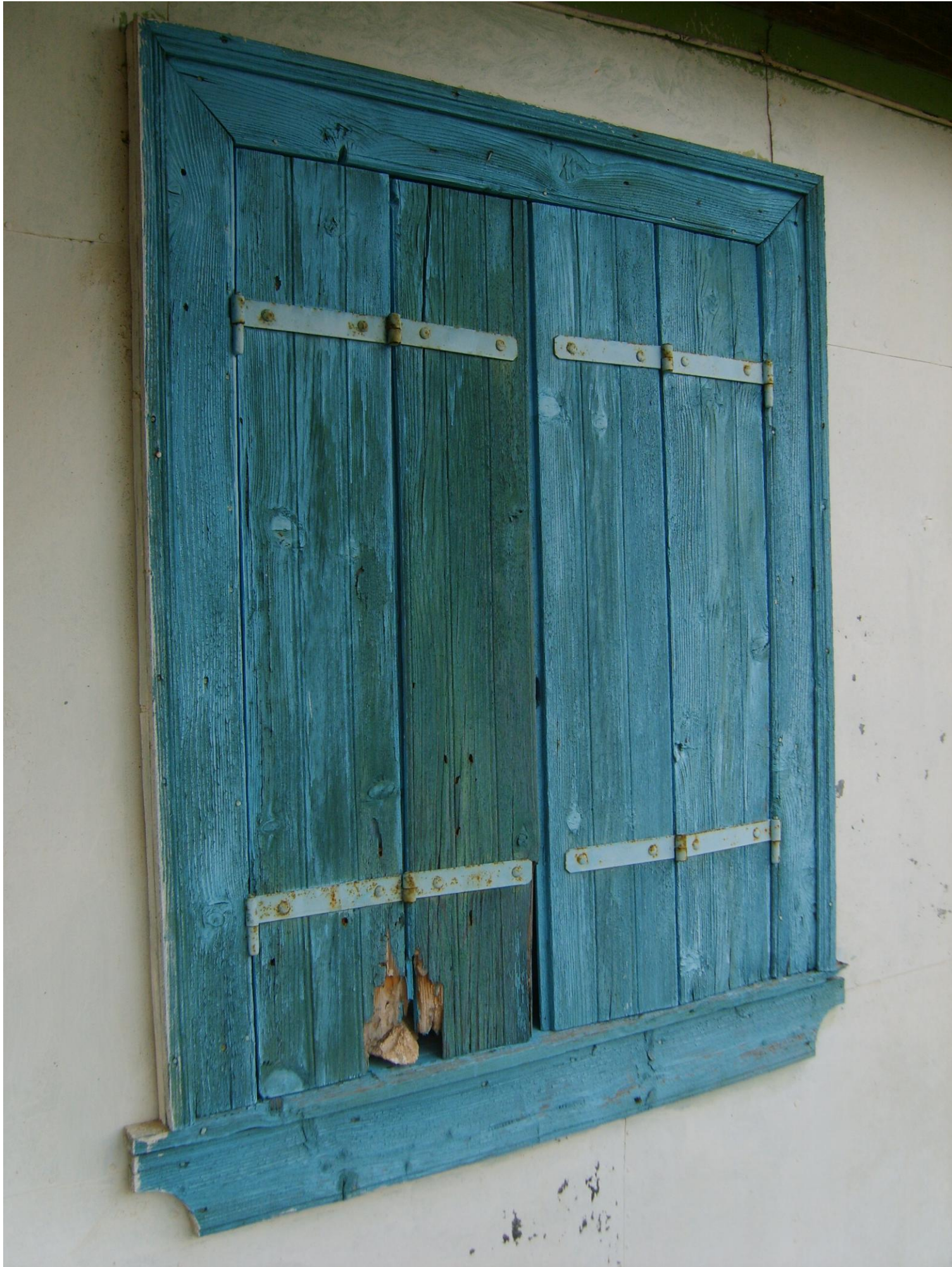
28. Εξωτερική όψη παραθύρου στον όροφο κτίριο 1.
