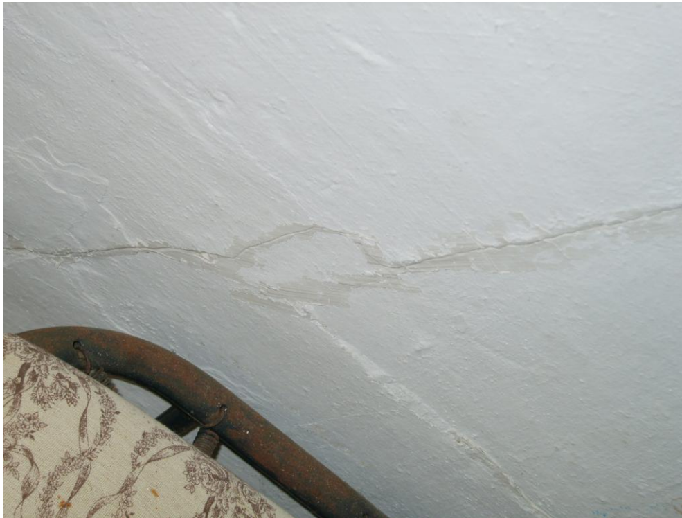
52. Η επιφάνεια της τοιχοποιίας αυτής είναι ο μεσότοιχος στον όροφο που έχει υγρασία και ρωγμές.
