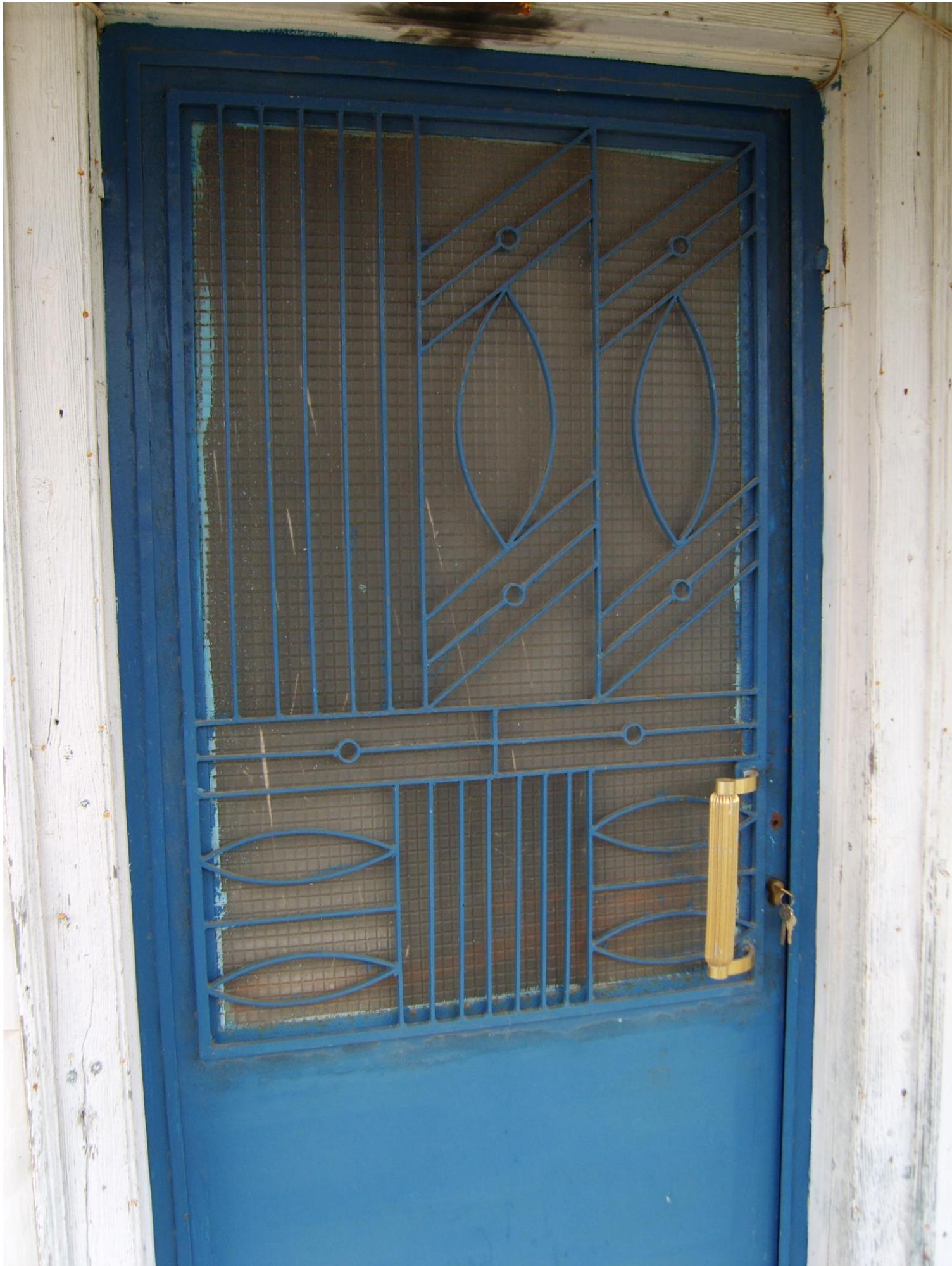
27. Κεντρική πόρτα εισόδου μεταλλική στον όροφο κτίριο 1.
