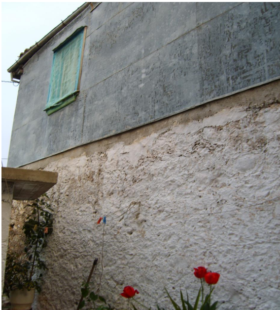
24.Βόρεια όψη υπάρχον κατάσταση κτίριο 1.
