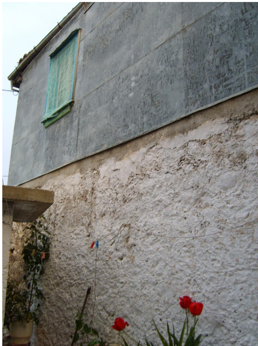
49. Η εξωτερική πλευρά του ορόφου στο κτίριο 1 έχει επενδυθεί με λαμαρίνα.
