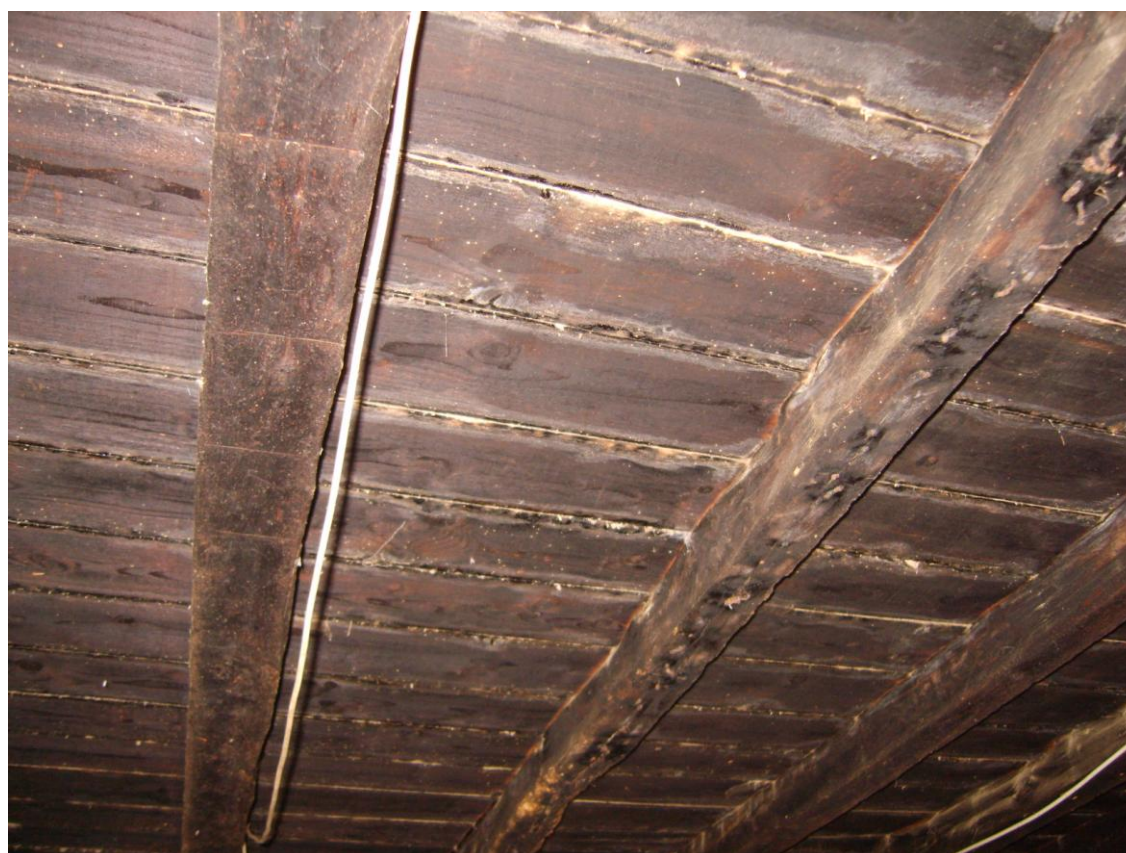
55. Το μεσοπάτωμα είναι ξύλινο με φέροντα οργανισμό από ξύλο με δοκάρια και ποταμό.
