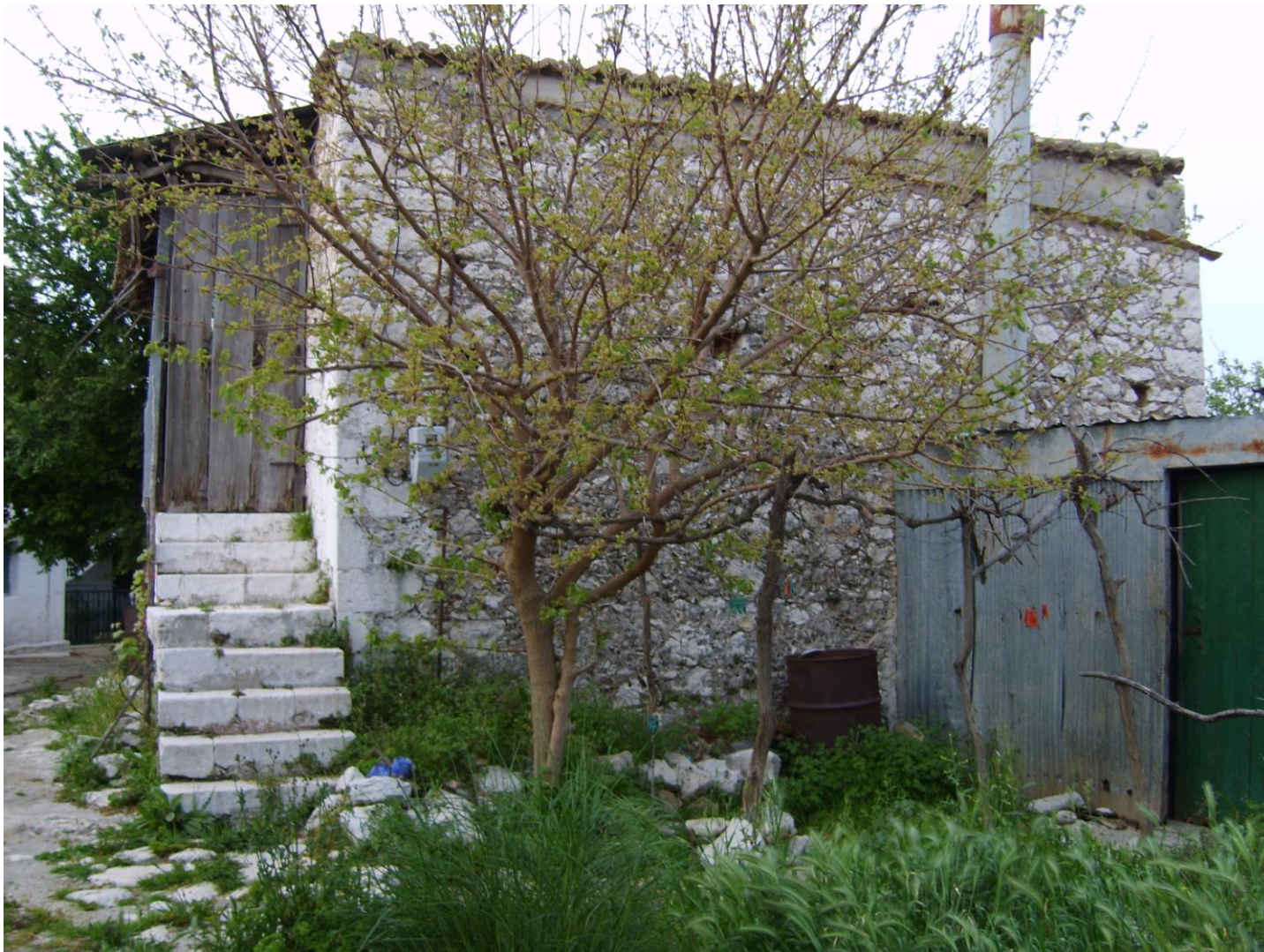
40.Νότια όψη κτιρίου 3.
