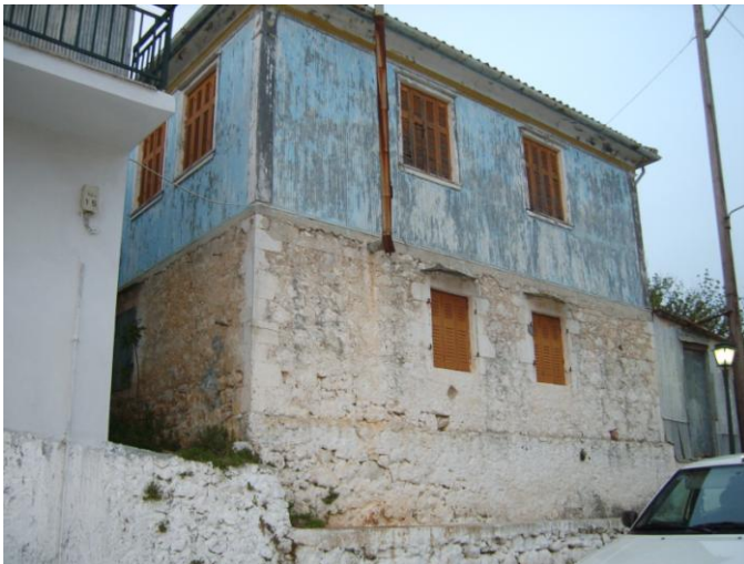
12. Σε αυτό το κτίριο το ισόγειο είναι λιθόκτιστο και ο όροφος είναι από λαμαρίνα.
