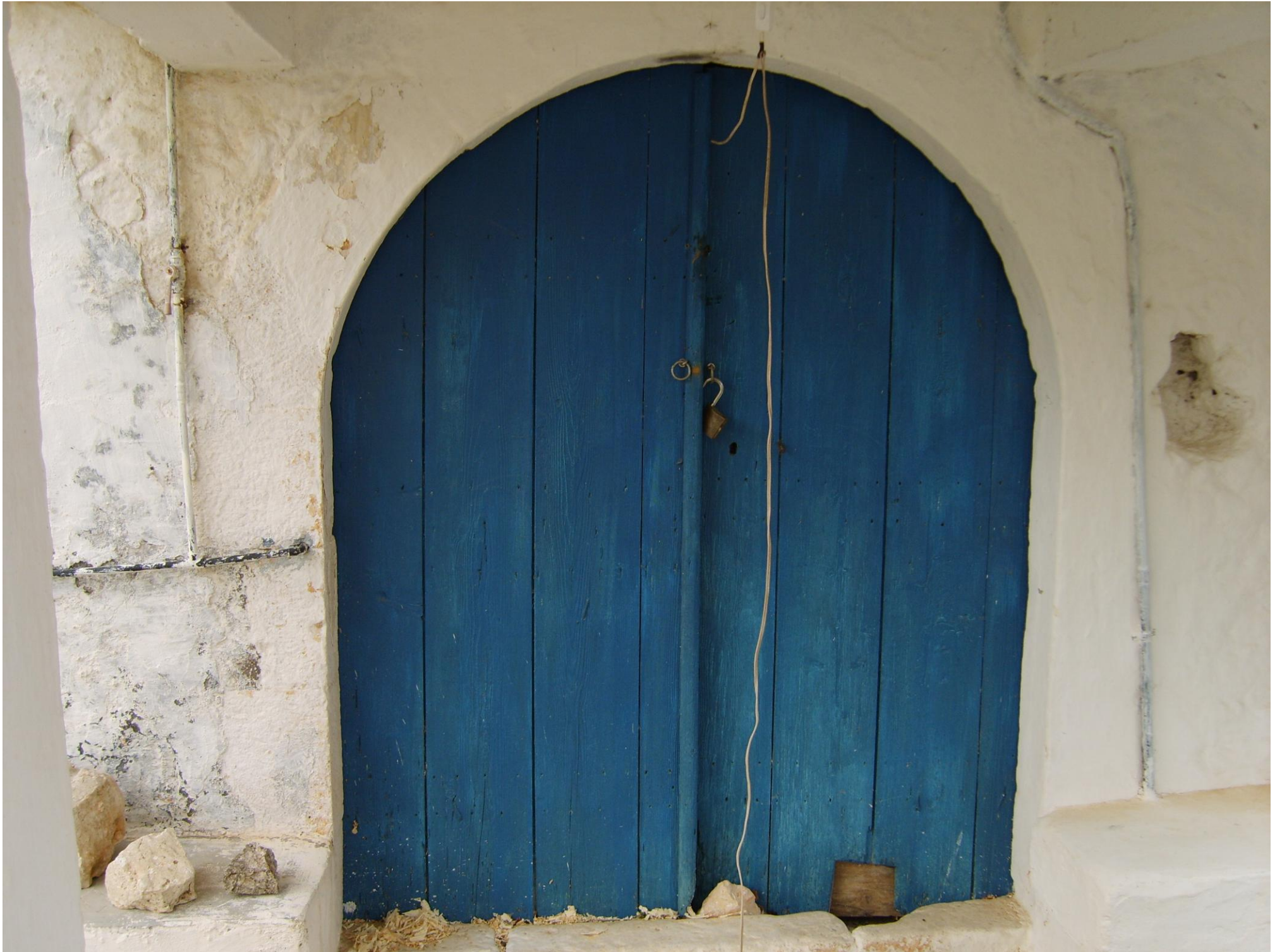
26. Κεντρική πόρτα εισόδου ξύλινη στο ισόγειο κτίριο 1.
