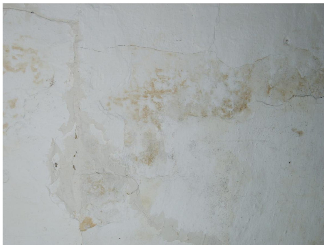
51. Η επιφάνεια της τοιχοποιίας αυτής είναι ο μεσότοιχος στον όροφο που έχει υγρασία και ρωγμές.
