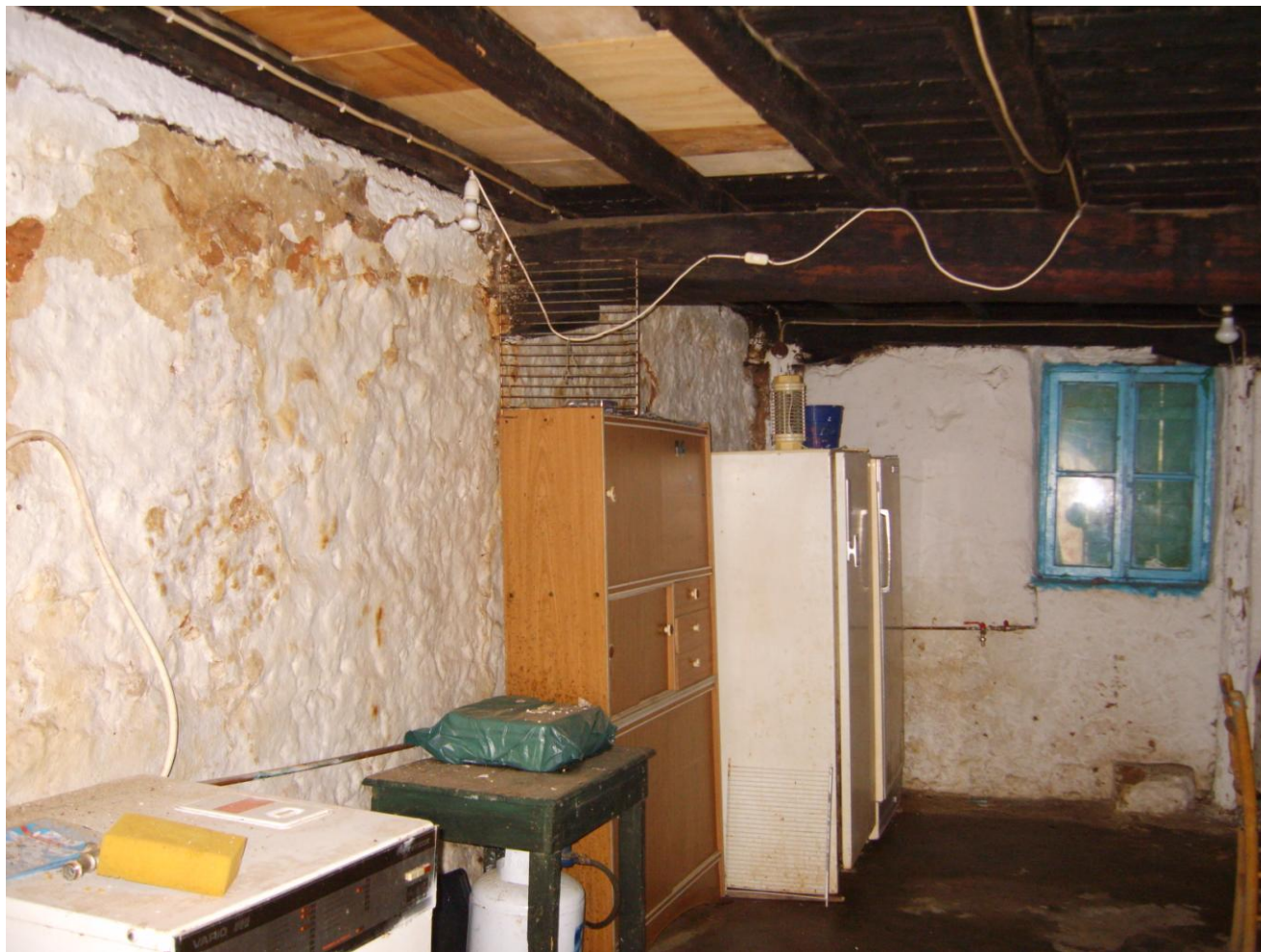
45. Συνολική εικόνα του μεσότοιχου με το κτίριο 2.
