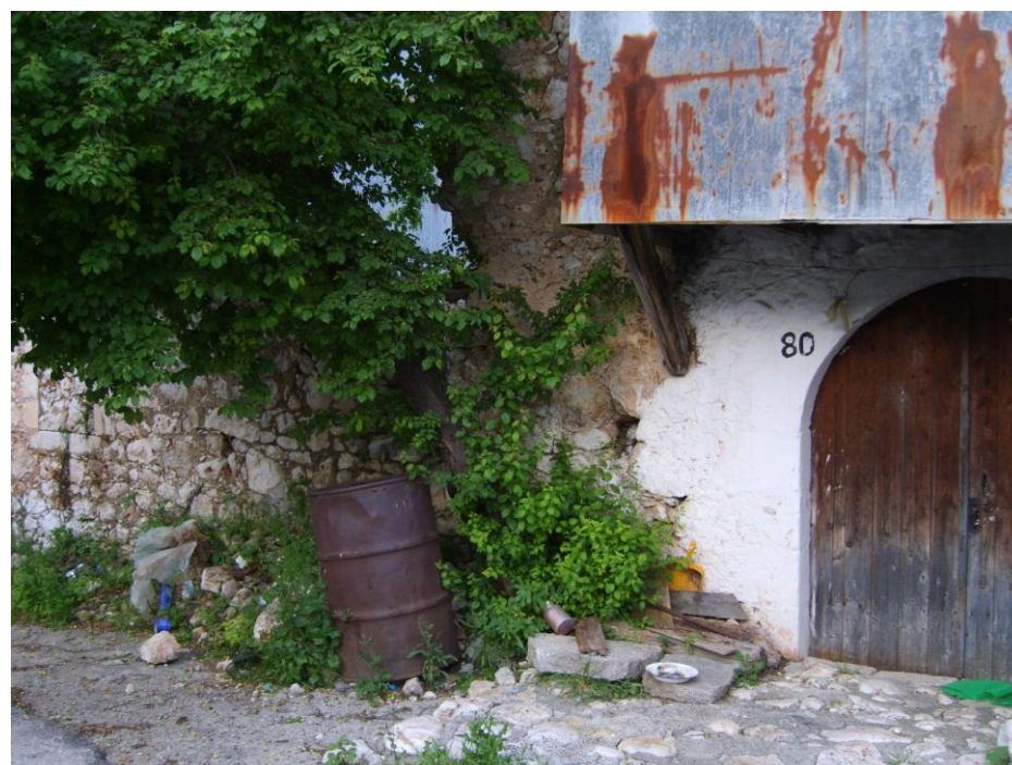
66. Απεικονίζεται ο εξώστης που στηρίζεται σε ξύλινα υποστηλώματα.
