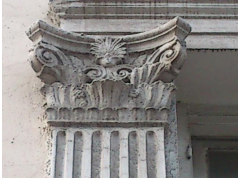
Εικόνα 28. Κορινθιακό προκατασκευασμένο κεραμικό κιονόκρανα, πλαισιώνει τα ανοίγματα ισογείου στην στέγη των παραστάδων.
