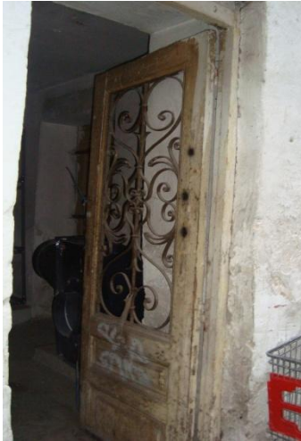
Θ7. Εξώθυρα μεταλλική μονόφυλλη με υαλοστάσιο και φεγγίτη.
