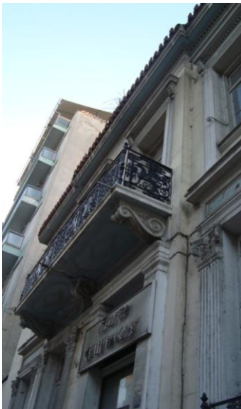
Μ7. Άποψη ανατολικής όψης, από πλάγια. Διακρίνονται καθαρά τα φουρούσια, το χυτοσιδηρό κιγκλίδωμα και κλασικιστικά στοιχεία που πλαισιώνουν τα ανοίγματα.
