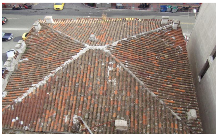
Εικόνα 11. Άποψη στέγης με γαλλικά κεραμίδια απο ψηλά.
