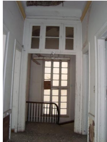
Θ4. Εσωτερική ξύλινη δίφυλλη πόρτα με φεγγίτη.
