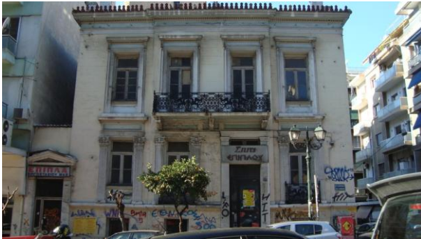
M1. Ανατολική όψη επί της οδού Γρηγορίου Λαμπράκη.
