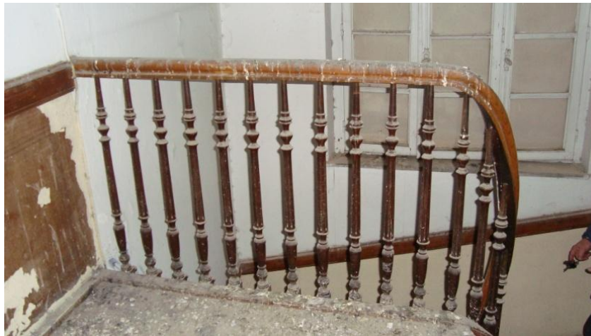
Εικόνα 20. Τα ξύλινα από μασίφ κιγκλιδώματα το κλιμακοστασίου.
