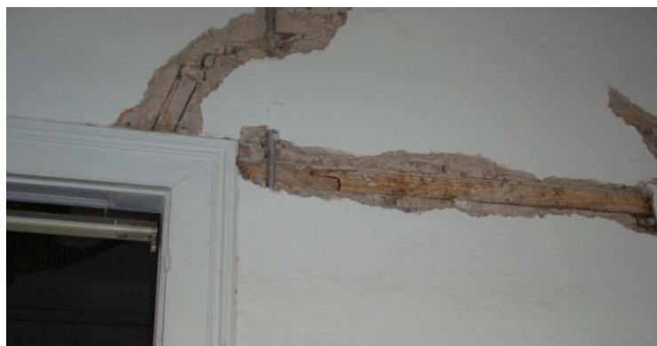
Εικόνα 18. Ξυλοδεσιά στο πρέκι εσωτερικών κουφωμάτων.
