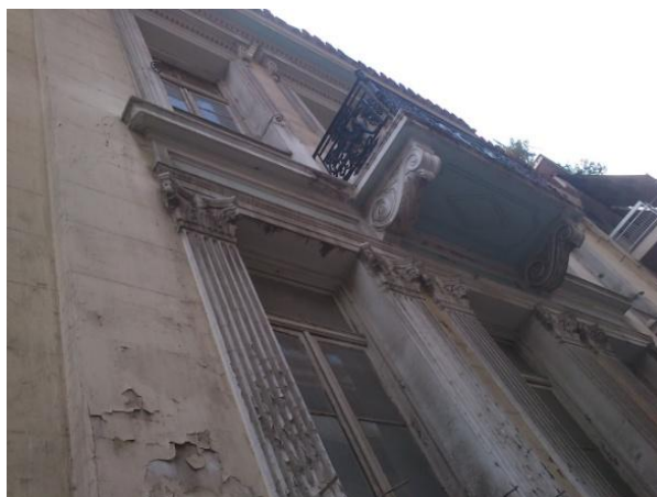
Εικόνα 26. Άποψη εξώστη και μαρμάρινων φουρουσιών.
