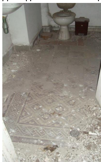
Π28. Άποψη δαπέδου λουτρού, επανατοποθέτηση κεραμικών πλακιδίων. Χώρος 307.
