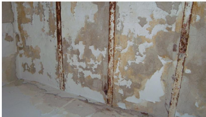
Εικόνα 10. Άποψη συστήματος Karren στον χώρο 210.
