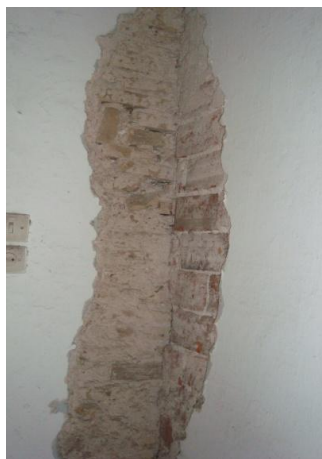
Π24. Αποκόλληση επιχρίσματος και λιθοδομής από συμπαγές οπτοπλινθοδομή. Χώρος 311.
