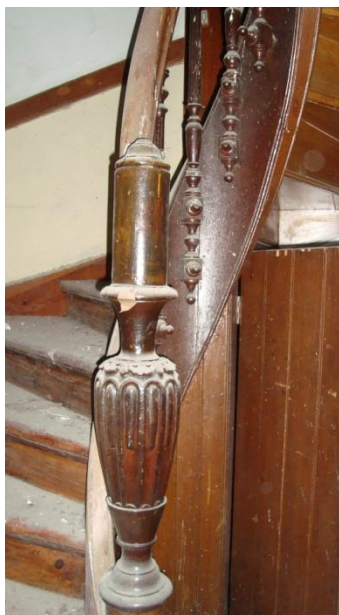
Εικόνα 21. Ο ορθοστάτης του κλιμακοστασίου.
