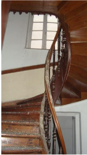
Εικόνα 22. Φαίνονται τα τρία τμήματα του κλιμακοστασίου ακριβώς εκεί που στρέφεται ο χειρολισθήρας.
