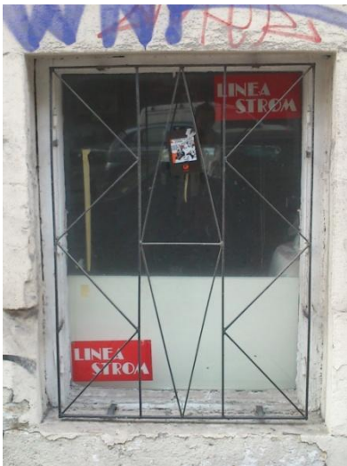
Π1. Ξύλινο μονόφυλλο παράθυρο με μεταλλικό κιγκλίδωμα. Άποψη από εξωτερικά.
