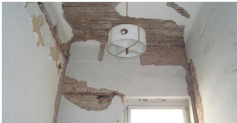
Εικόνα 17. Περιμετρικό μεταλλικό δοκάρι κατα μήκος της λιθοδομής.
