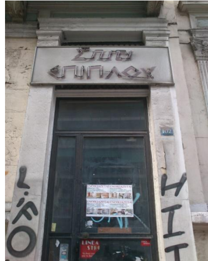
Θ9. Κύρια εξώθυρα μεταλλική μονόφυλλη με υαλοστάσιο και φεγγίτη. Αποψη από εξωτερικά..
