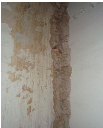
Π17. Αποκόλληση επιχρίσματος και αποκόλληση τοιχοποιών λιθοδομής με συμπαγής οπτοπλινθοδομή. Χώρος 311.
