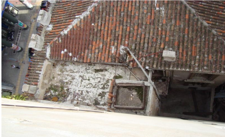
Εικόνα 12. Άποψη στέγης και δώματος απο ψήλα.
