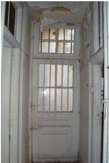
Θ8. Εξώθυρα ξύλινη μονόφυλλη με ταμπλάδες, φεγγίτη και μεταλλικά κυγκλιδώματα.
