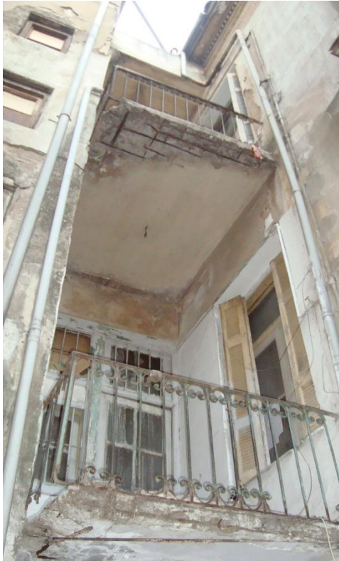
M11. Άποψη του εξώστη ισογείου που βρίσκεται στην πίσω νοτιοδυτική όψη.
