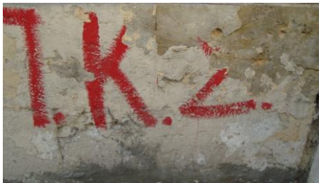
Π13. Μεταγενέστερες επεμβάσεις στο εξωτερικό επίχρισμα του κτηρίου.
