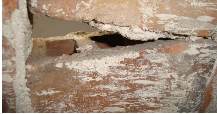
Εικόνα 15. Τοίχους πλήρωσες από διάτρητους οπτόπλινθους (τρίοπο τούβλο)
