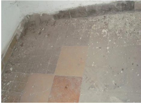
Π29. Άποψη δαπέδου λουτρού, επανατοποθέτηση κεραμικών πλακιδίων. Χώρος 209.
