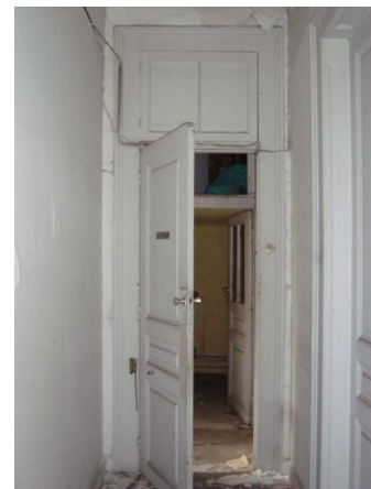
Θ5. Εσωτερική ξύλινη μονόφυλλη πόρτα με ταμπλάδες και φεγγίτη.
