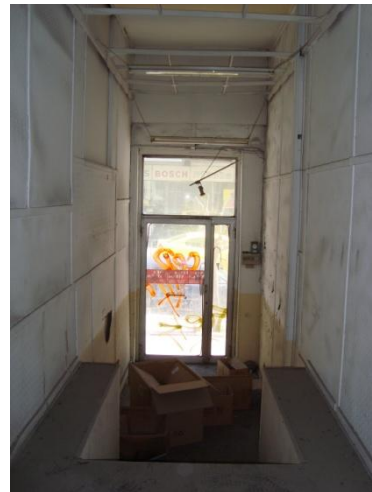
Θ10. Κύρια εξώθυρα μεταλλική μονόφυλλη με υαλοστάσιο.
