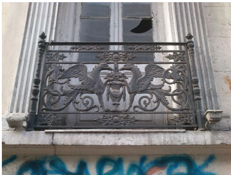
Εικόνα 35. Χυτοσιδηρό κιγκλίδωμα με μυθικές μορφές, παραγωγή του Ε. Τσίλερ
