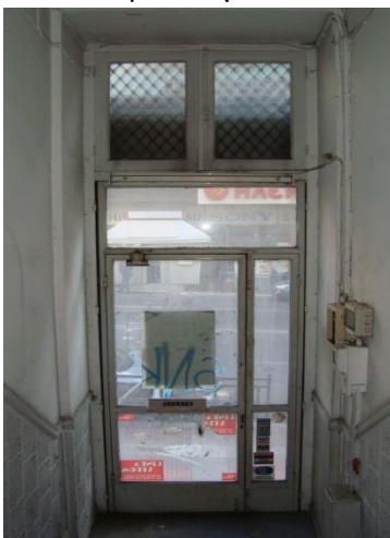
Θ9. Κύρια εξώθυρα μεταλλική μονόφυλλη με υαλοστάσιο και φεγγίτη. Άποψη από εσωτερικά.
