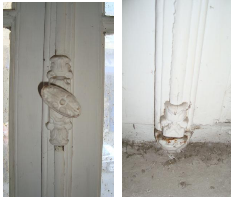
Εικόνα 19. Λεπτομέρειες μεταλλικής χειρολαβής εξωτερικών ξύλινων κουφωμάτων.
