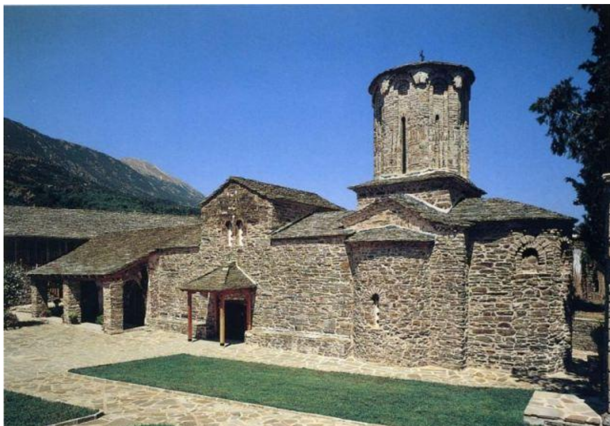
Εικ. 34. Μονή Μολυβδοσκεπάστου, εξωτερική όψη
