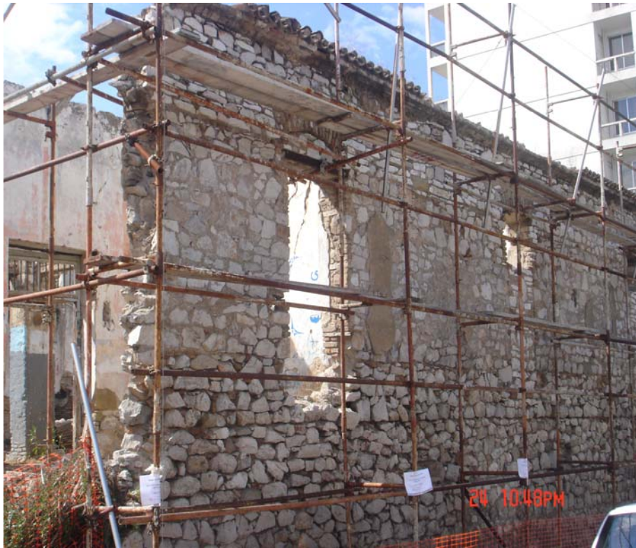
Εικόνα 33: Τμήμα εξωτερικής λιθοδομής.
