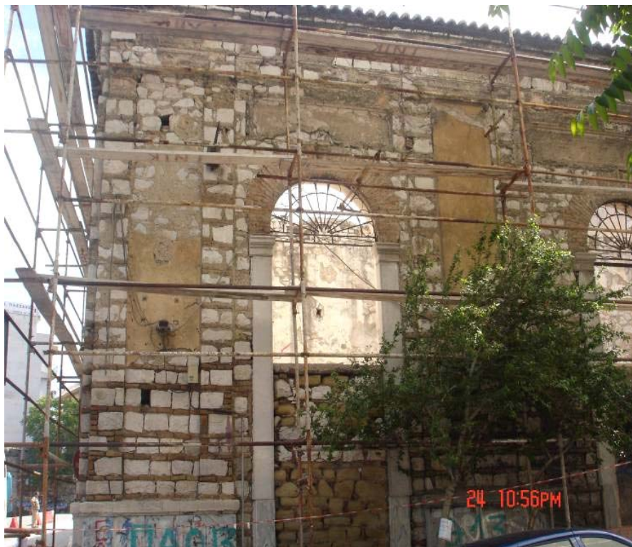
Εικόνα 32: Τμήμα εξωτερικής λιθοδομής.
