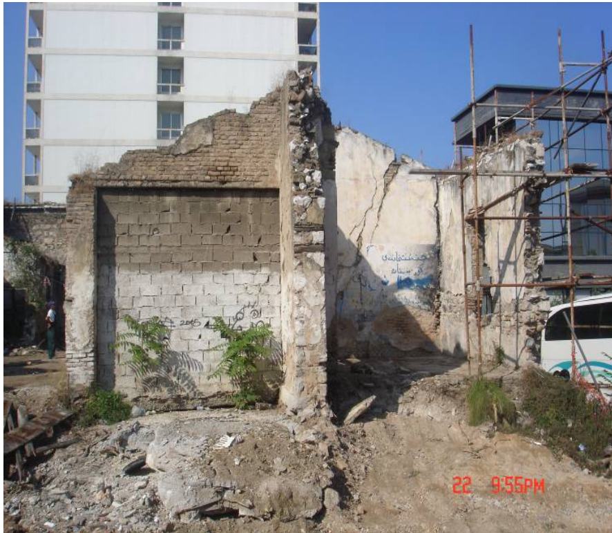
Εικόνα 31: Τμήμα εσωτερικής λιθοδομής
