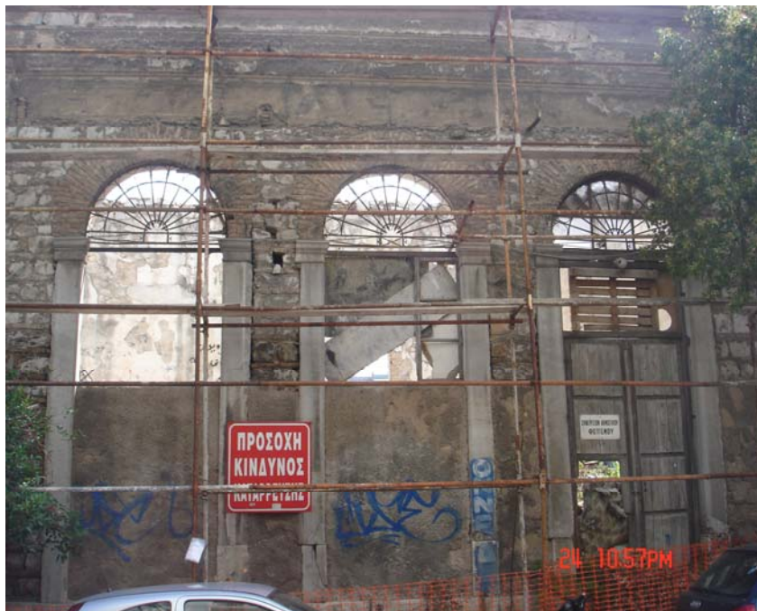
Εικόνα 28: Ανοίγματα επί της οδού Αγ.Ανδρέου.
