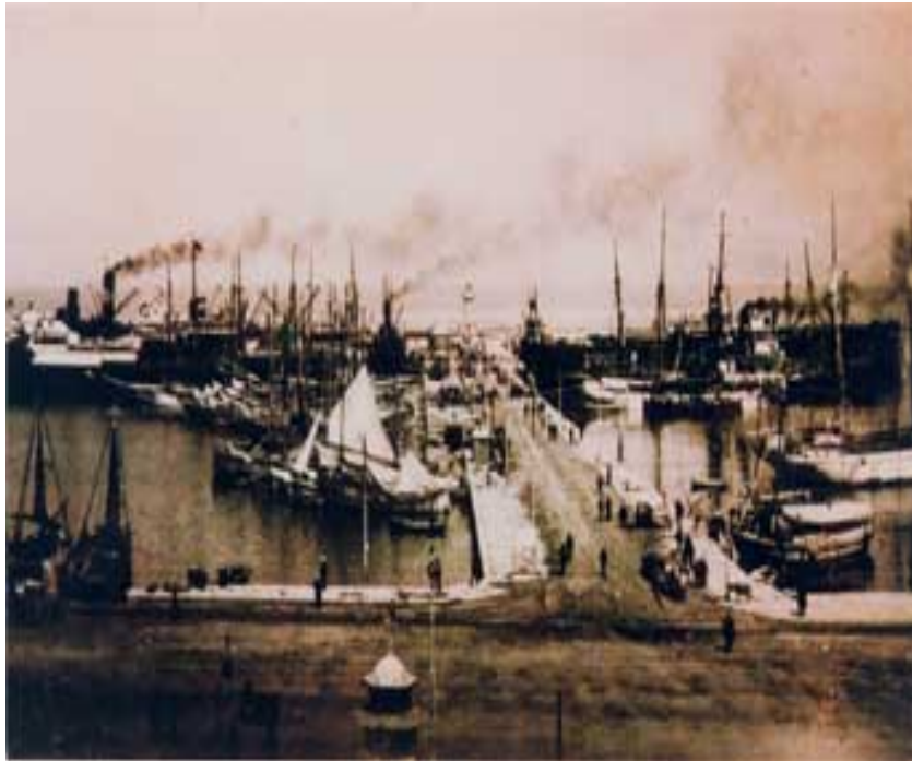
Εικόνα 55: κατασκευή τεχνικού λιμανιού
