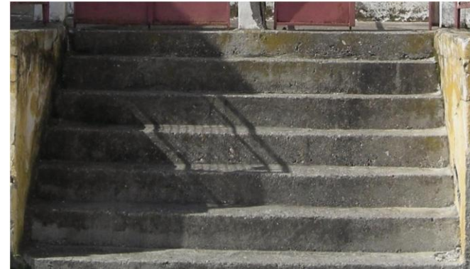
Εικόνα 71 Εξωτερική κεντρική κλίμακα από οπλισμένο σκυρόδεμα
