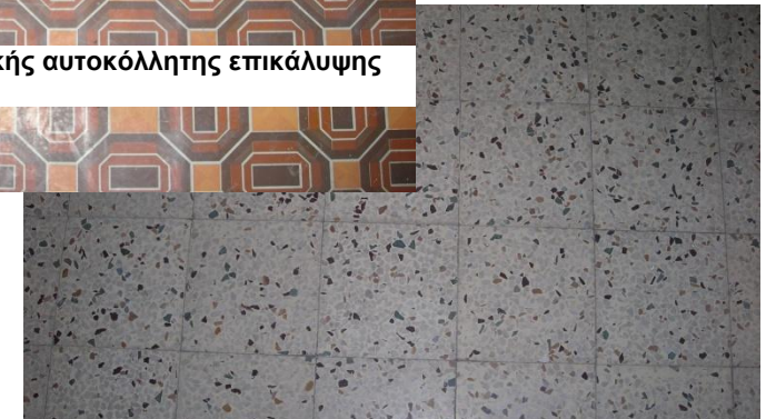
Εικόνα 76 Τμήμα δαπέδου από μωσαϊκό πλακίδιο
