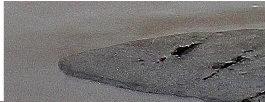
Εικόνα 77 Τμήμα οροφής στον χώρο 109
