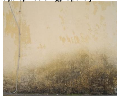
Εικόνα 93 Βιολογική διάβρωση
