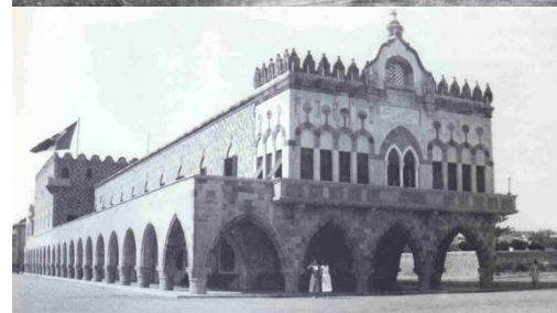
Εικόνα 9 Ιταλικά κτίρια, σημερινό α. Καζίνο ( www.ellinikakazino.gr ) Ρόδου, β. Εθνικό Θέατρο Ρόδου ( rhodesvolunteers.files.wordpress.com ), γ. Νομαρχία ( 1.bp.blogspot.com )
