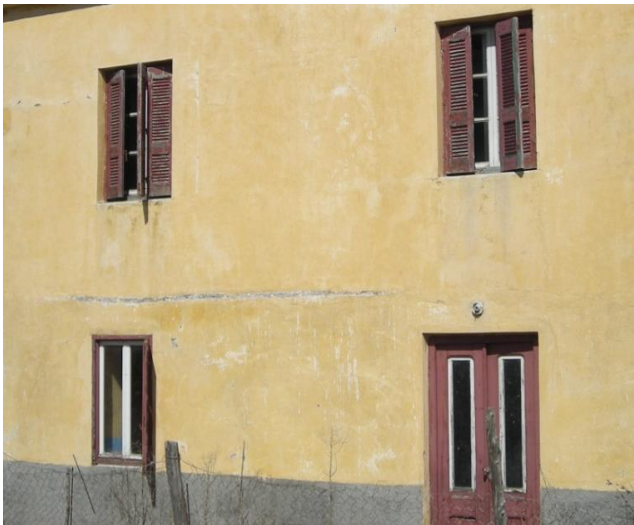
Εικόνα 98 Αλλοιώσεις στους χρωματισμούς
