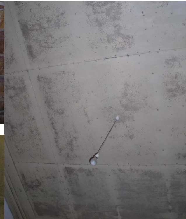
Εικόνα 79 Τμήμα οροφής στον όροφο
