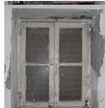
Εικόνα 90 Εσωτερική άποψη κουφώματος ισογείου
