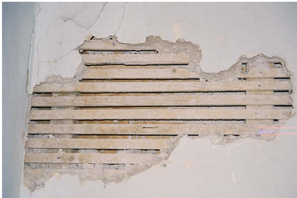
32. Ταβάνι Ορόφου(Κεντρικού Κτιρίου Διωρόφου)
