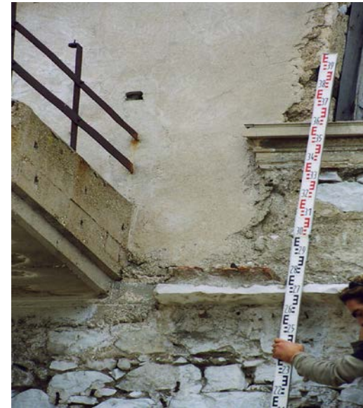
39. Δυτική Όψη (μέτρηση υψομέτρου)
