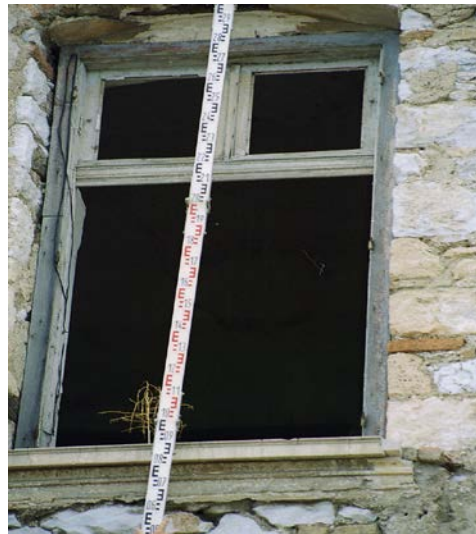
38. Μέτρηση ανοίγματος (παράθυρου)
