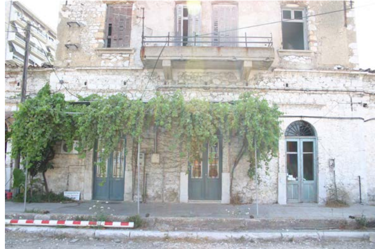
10. Δυτική Όψη Κεντρικού Κτιρίου (Διώροφου)
