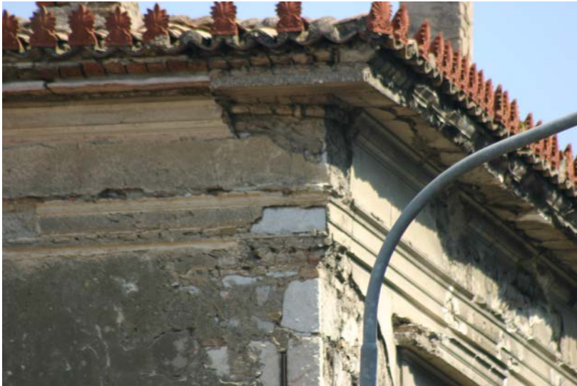
21. Βορειοανατολική Όψη (Λεπτομέρεια στέγης)
