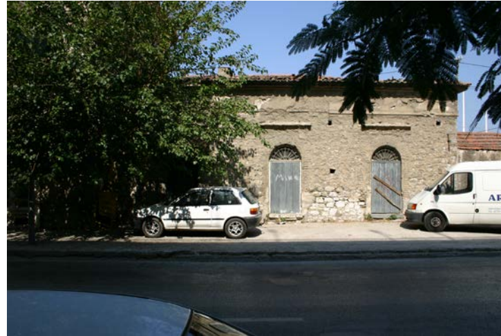
2. Ανατολική Όψη (Ισόγειο Βόρειο τμήμα)
