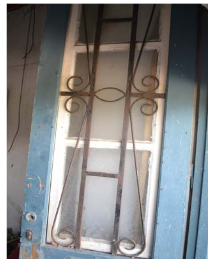
Πόρτα Εξωτερική Δυτικής Όψης Ισογείου
