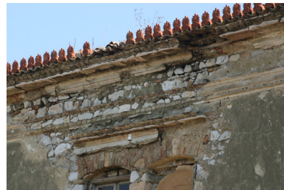
Τόξα Ορόφου Νότια Όψη
