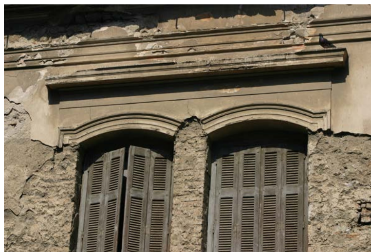
8. Ανατολική (παράθυρα ορόφου)
