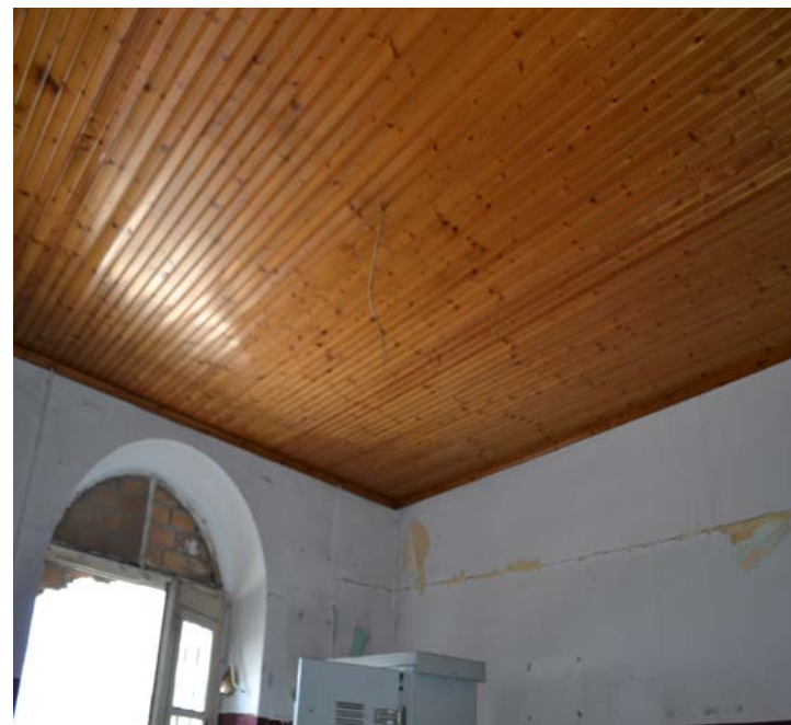
33. Οροφή (Ταβάνι Ισογείου)
