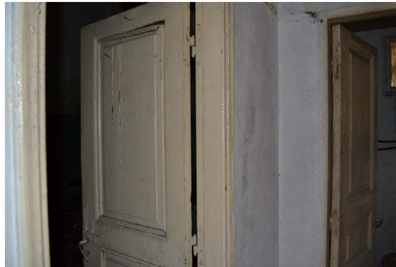
28. Εσωτερική Πόρτα Ισογείου
