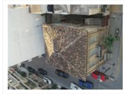
ΦΩΤΟΓΡΑΦΙΑ 44 Άποψη στέγης
