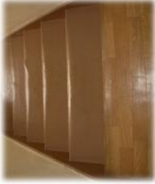
Εικόνα 81: Ξύλινη εσωτερική σκάλα.
