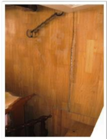
ΦΩΤΟΓΡΑΦΙΑ 26 Πλάκα ορόφου
