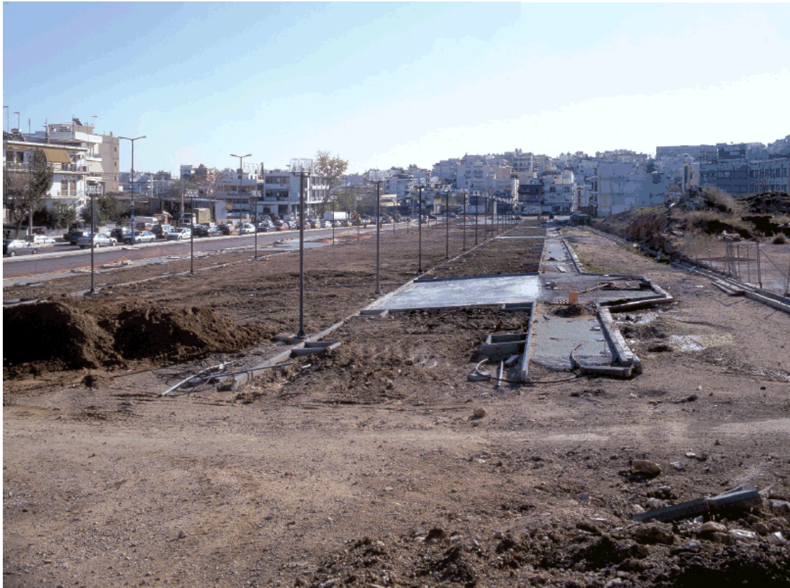
Το Πάρκο Ιστορικής Μνήμης υπό κατασκευή (Δεκέμβριος 2006)
