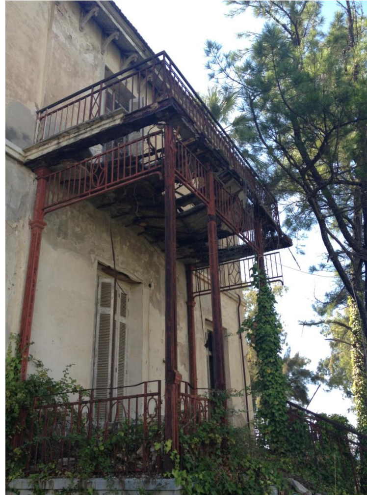
εικ. 3.3 Εξώστης στη βόρεια όψη
