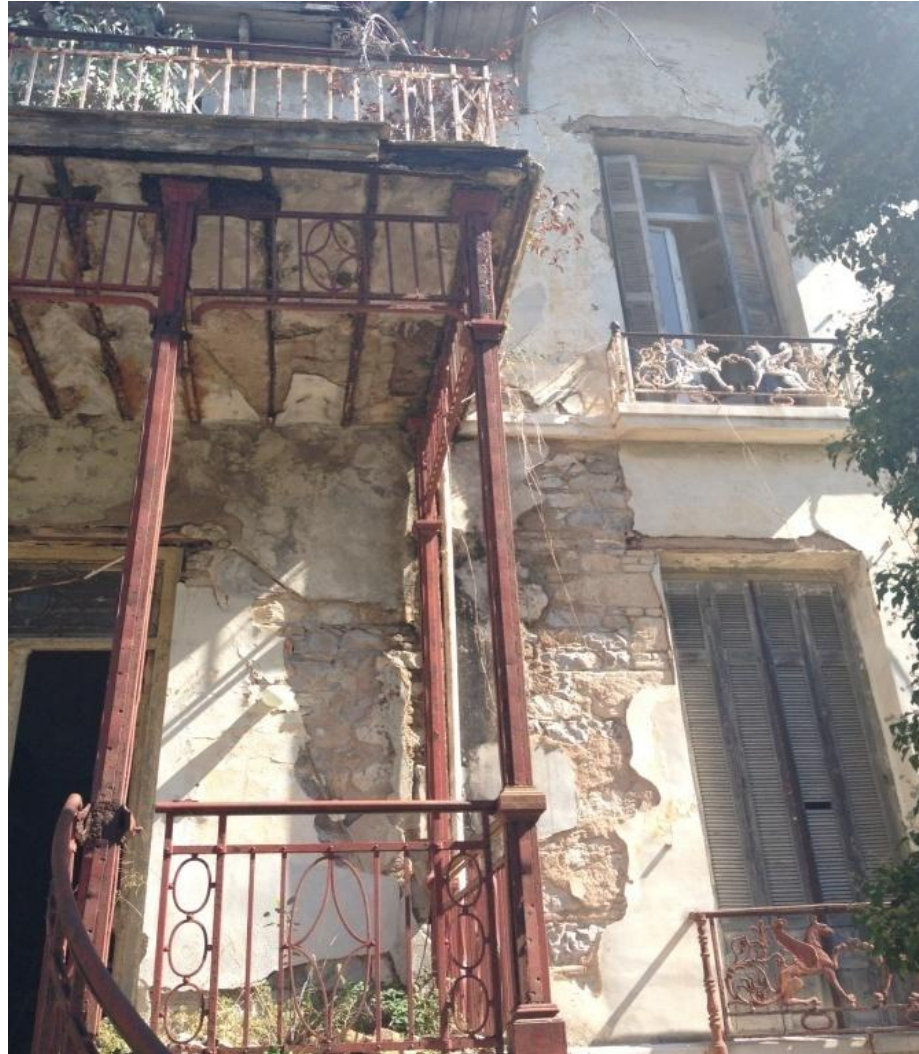
εικ. 3.10 Τμήμα βόρειας όψης
