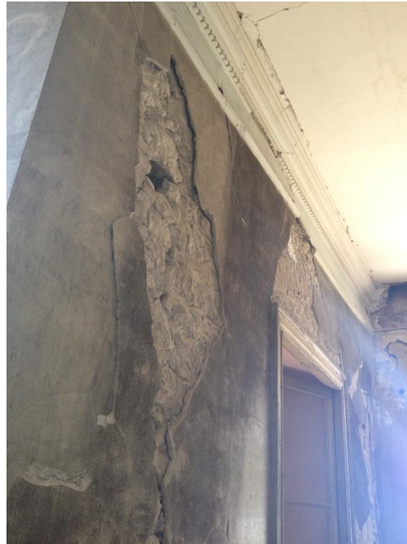
εικ. 3.4 Εσωτερική τοιχοποιία
