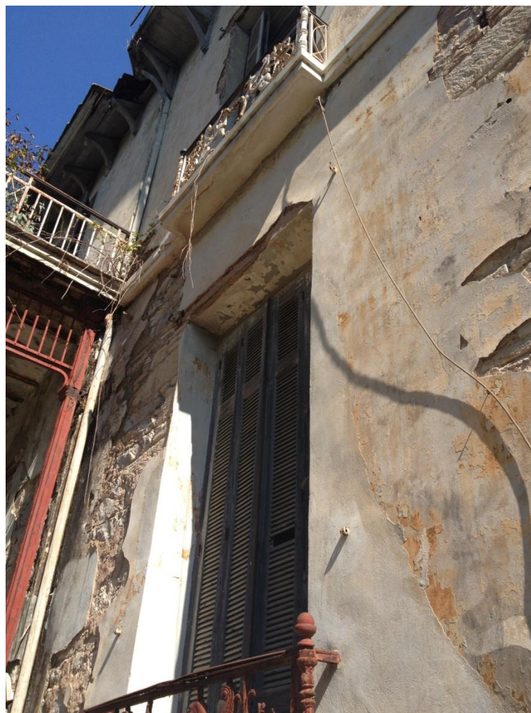
εικ. 3.5 Εξωτερική τοιχοποιία
