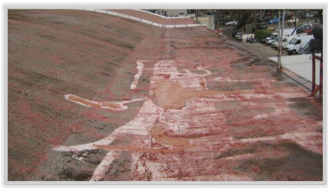
Εικόνα 19 Φωτογραφία θολωτής στέγης
