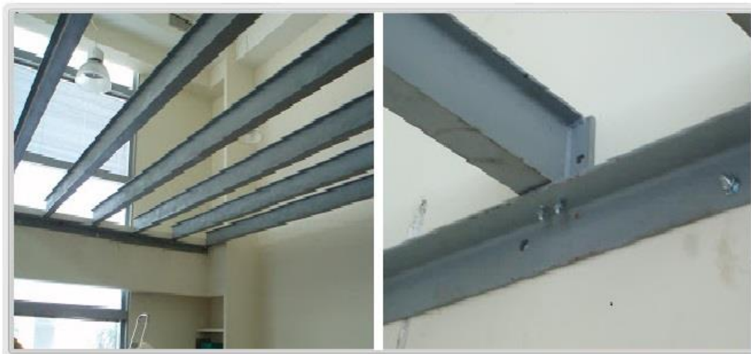
Εικόνα 37 Κατασκευή εσωτερικού ορόφου με κοιλοδοκούς
