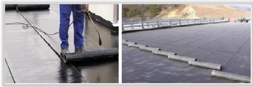
Εικόνα 45 τοποθέτηση ασφαλτόπανου με τη χρήση φλόγιστρου
