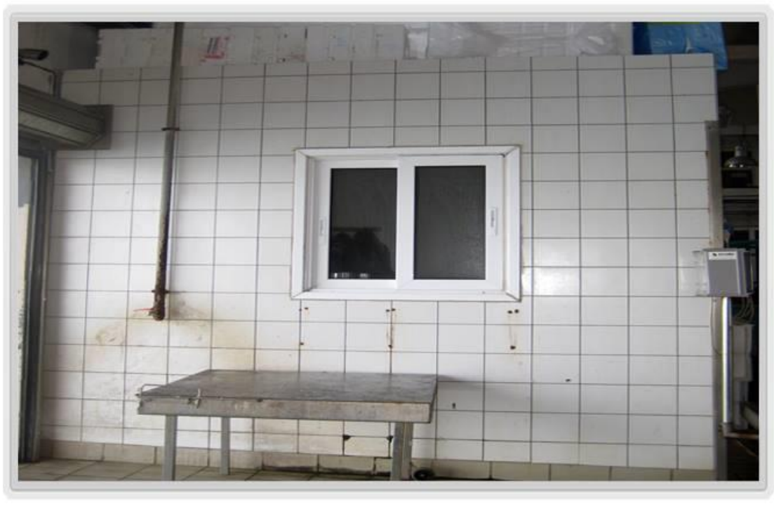
Εικόνα 24 Εσωτερική τοιχοποιία με επικάλυψη πλακιδίων
