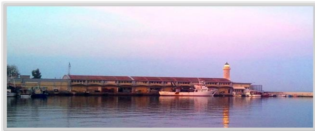
Εικόνα 5 Δυτική όψη του κτιρίου της ιχθυόσκαλας
