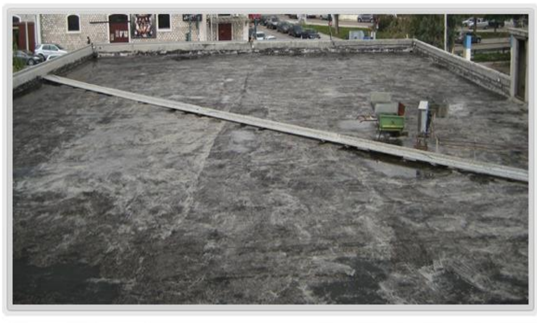
Εικόνα 20 Φωτογραφία πλάκας οροφής κτιρίου 1
