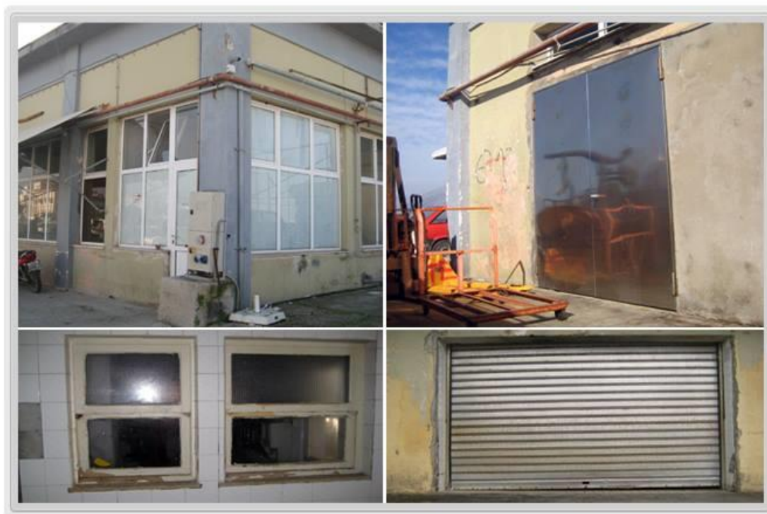
Εικόνα 25 Δείγματα από κουφώματα του κτιρίου
