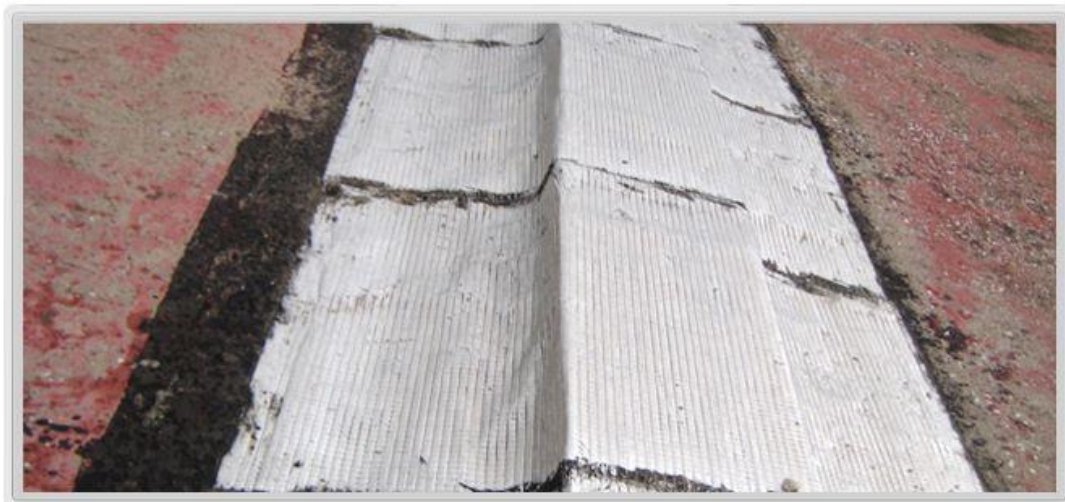
Εικόνα 31 Αρμός διαστολής κτιρίων 2 και 3 στις στέγες των κτιρίων
