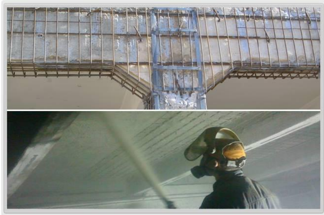
Εικόνα 36 Πάνω φέρων στοιχείο μετά την τοποθέτηση οπλισμού και πριν καλυφθεί από εκτοξευμένο σκυρόδεμα. Κάτω επικάλυψη με μανδύα εκτοξευμένου σκυροδέματος
