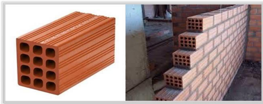
Εικόνα 39 Αριστερά πλίνθος διαστάσεων 9× 12×29εκ και δεξιά μονή δρομική τοιχοποιία
